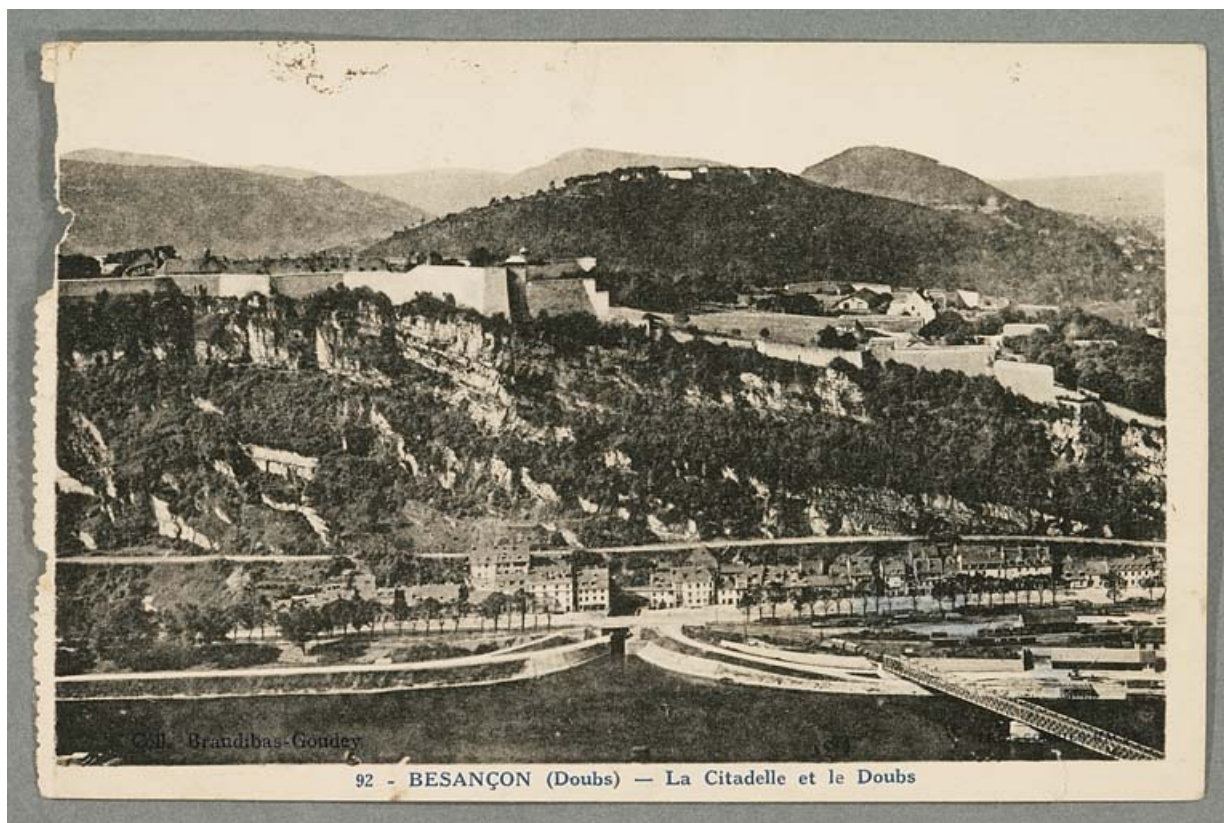
[La citadelle, le port de Rivotte et l'extrémité amont du tunnel, vus de Bregille], 1ère moitié 20e siècle. 25, Besançon Faubourg Tarragnoz 7, lieudit : îlot Tarragnoz
