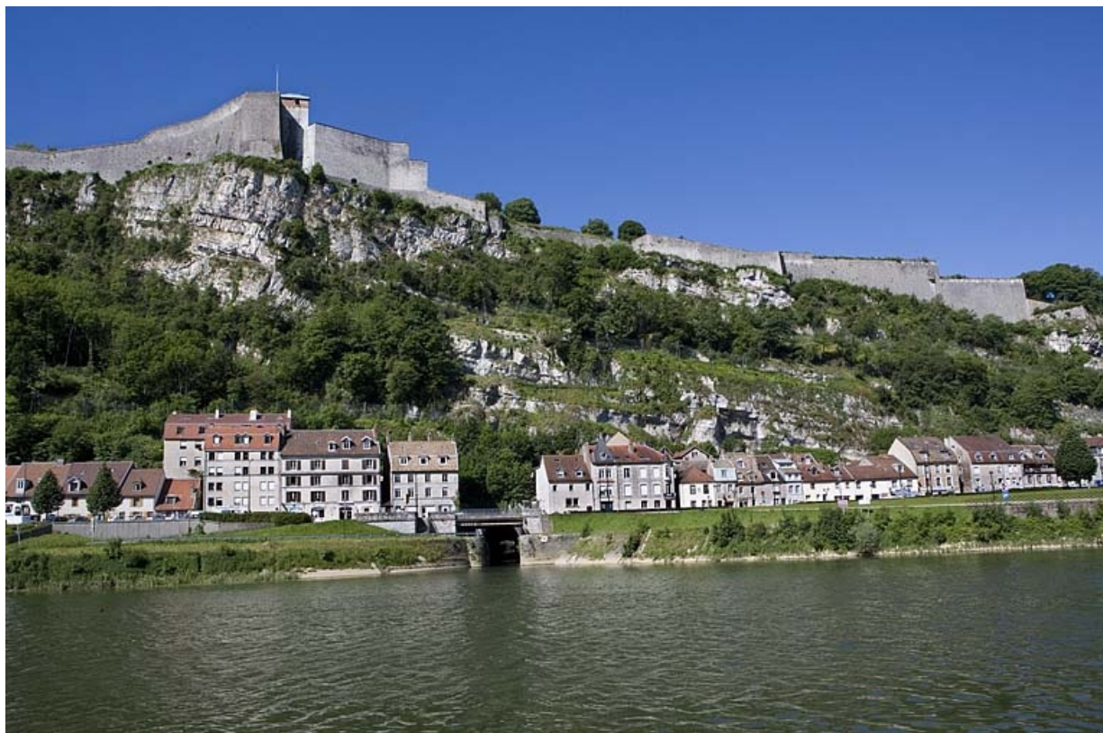
Vue d'ensemble de la partie amont du site, côté faubourg Rivotte.
