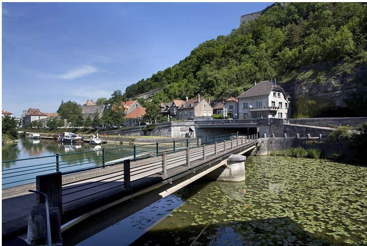
Vue d'ensemble de la partie aval du site, côté faubourg Tarragnoz.
