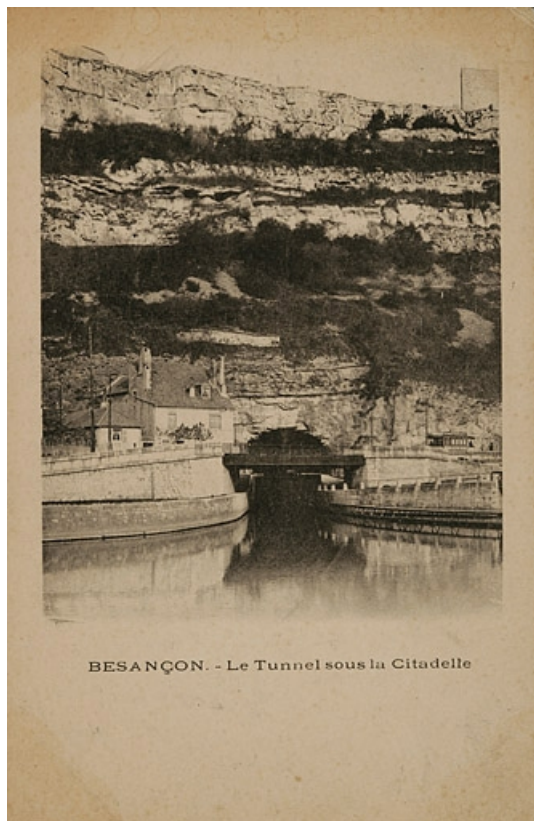
Besançon. - Le Tunnel sous la Citadelle, 4e quart 19e siècle.
