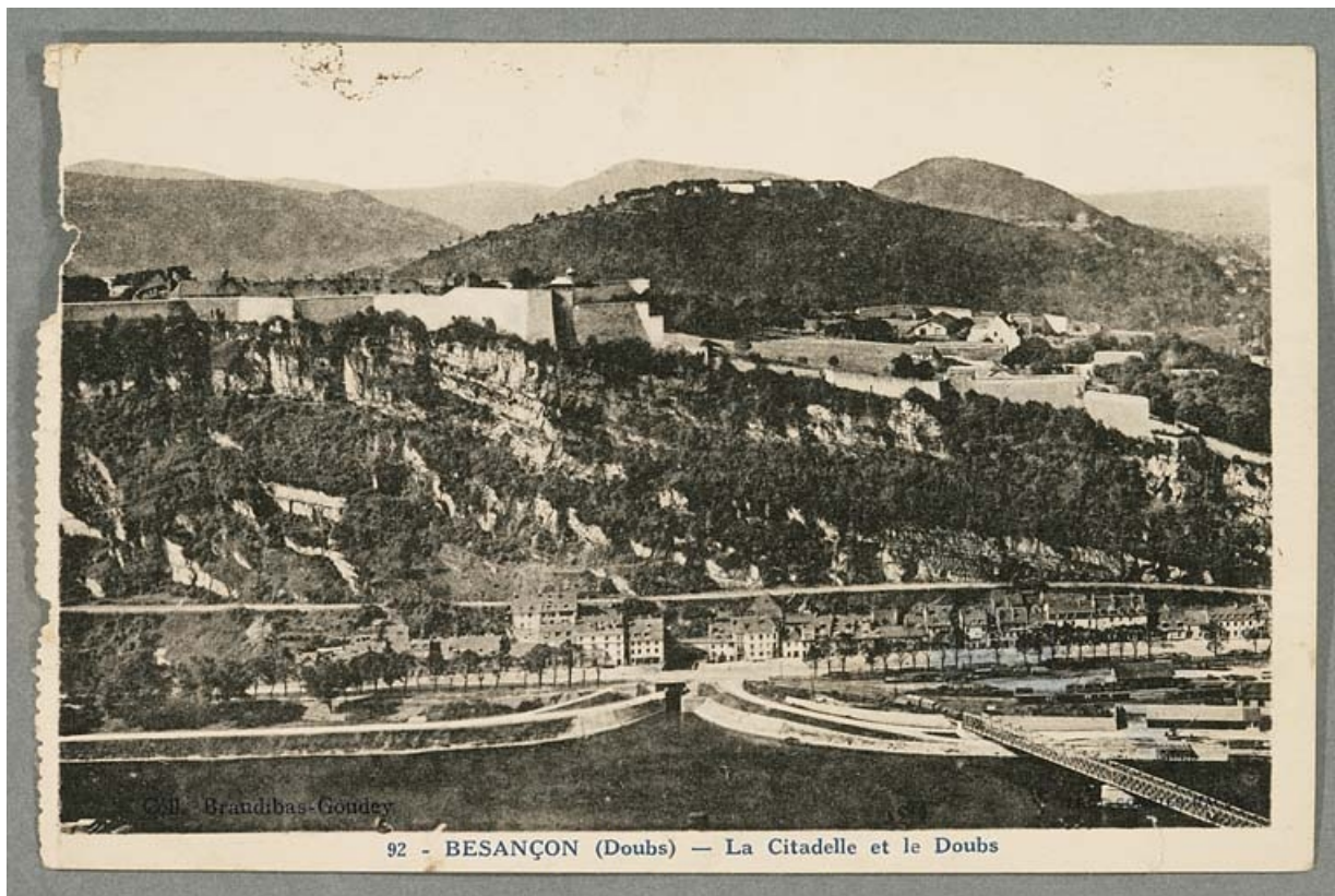
[La citadelle, le port de Rivotte et l'extrémité amont du tunnel, vus de Bregille], 1ère moitié 20e siècle. 25, Besançon Faubourg Tarragnoz 7, lieudit : îlot Tarragnoz
