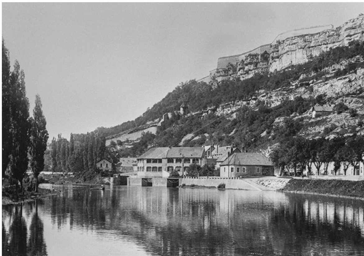
Façades sur le Doubs vues depuis l'aval [1re moitié 20e siècle].
