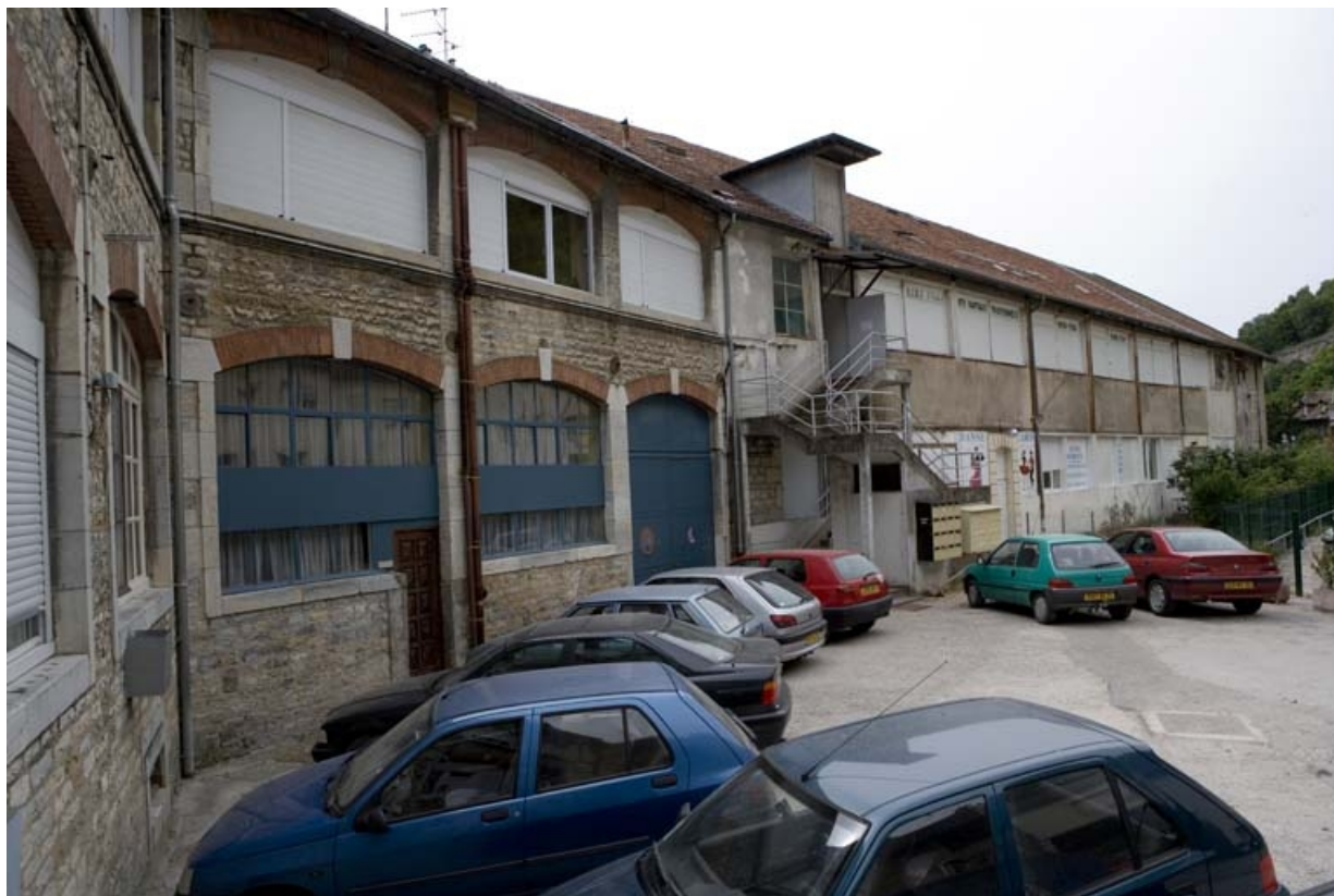
Façade antérieure des ateliers de fabrication, de trois quarts gauche. 25, Besançon Faubourg Tarragnoz 2 à 6, lieudit : îlot Tarragnoz
