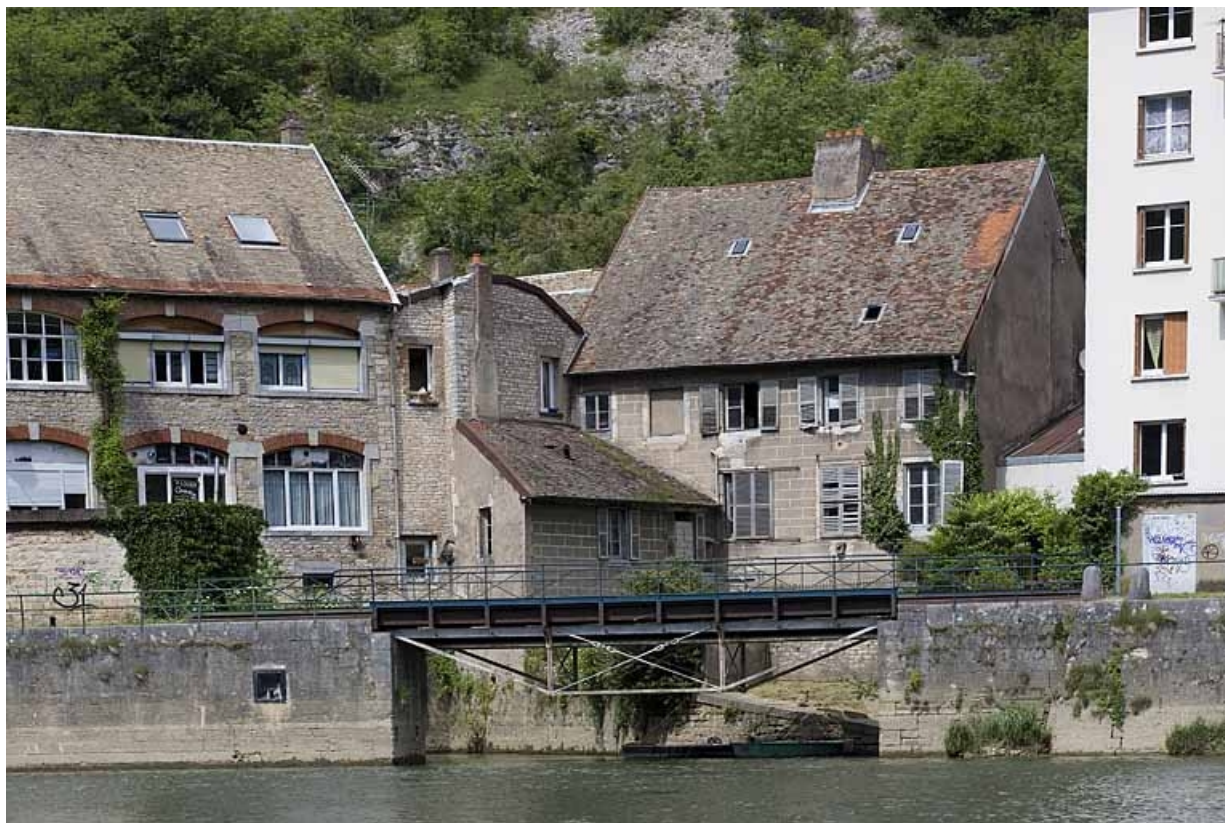
Pont de halage enjambant le canal de fuite gauche.
