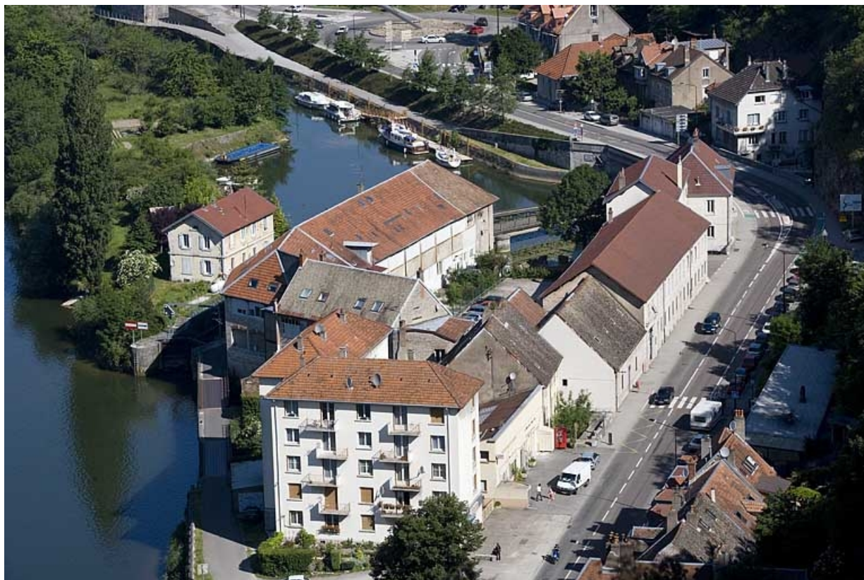
Vue d'ensemble plongeante sur les bâtiments, depuis l'aval. 25, Besançon Faubourg Tarragnoz 2 à 6, lieudit : îlot Tarragnoz
