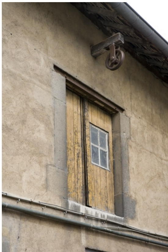
Fenêtre haute de la remise (côté cour), surmontée d'une poulie.
