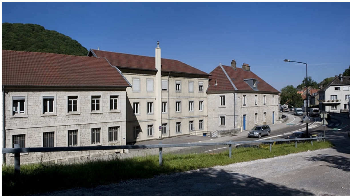
Façade antérieure des bâtiments sur rue, depuis l'est.
