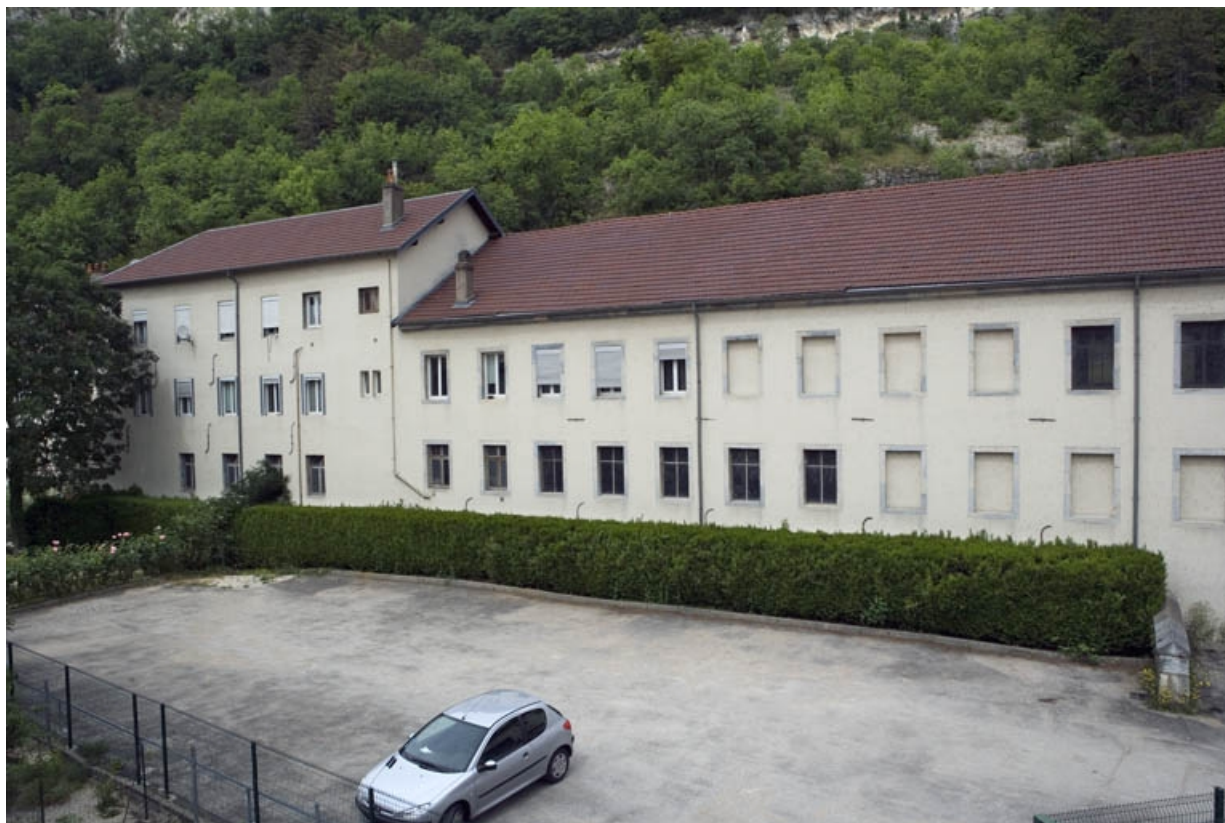
Façade postérieure du bâtiment d'eau et de l'ancien moulin, de trois quarts droite. 25, Besançon Faubourg Tarragnoz 2 à 6, lieudit : îlot Tarragnoz
