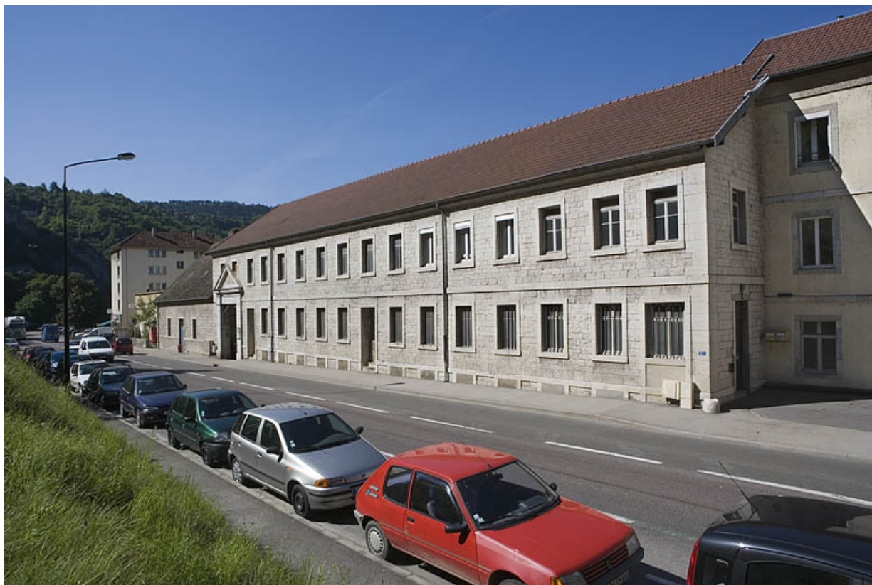
Façade antérieure de l'ancien moulin, de trois quarts droite. 25, Besançon Faubourg Tarragnoz 2 à 6, lieudit : îlot Tarragnoz
