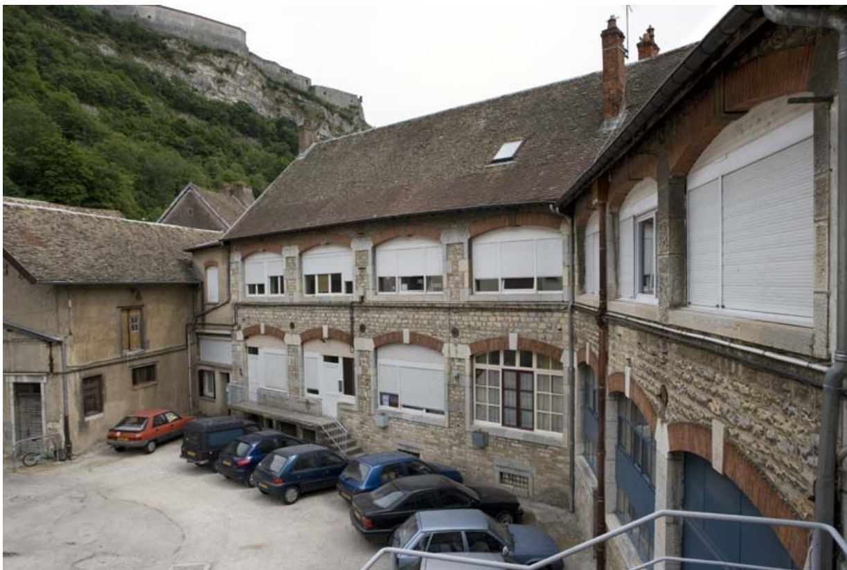
Façade antérieure des ateliers de fabrication, de trois quarts droite.
