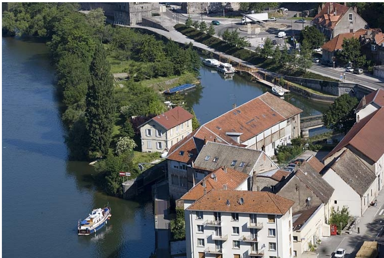
Vue d'ensemble plongeante, depuis l'aval.
