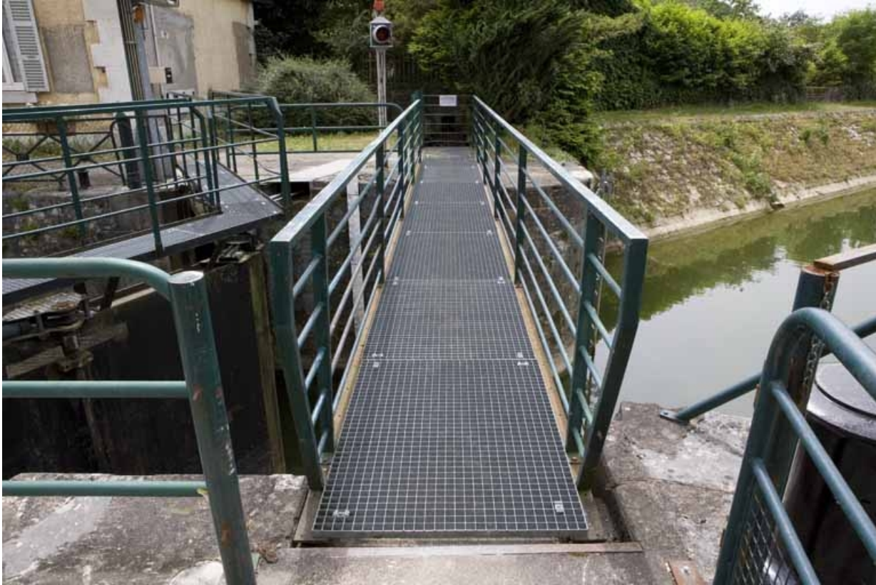
Tête amont de l'écluse : passerelle d'accès à la maison d'éclusier en place.
