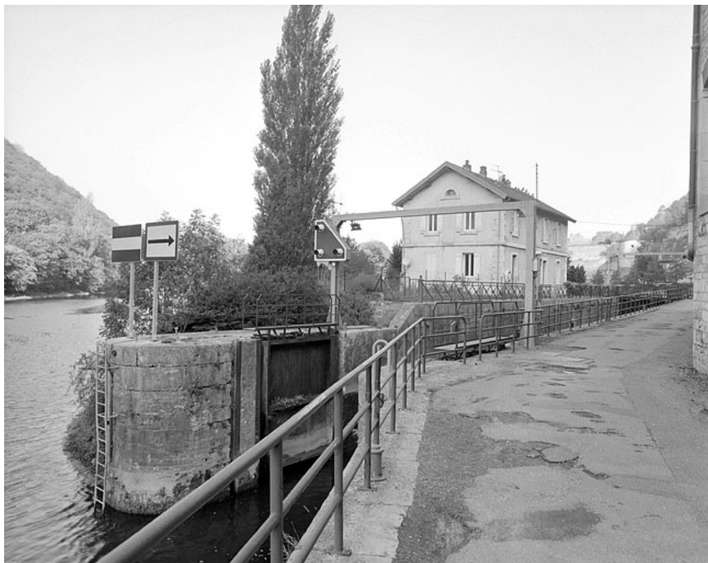
Vue d'ensemble depuis le chemin de halage, en aval.
