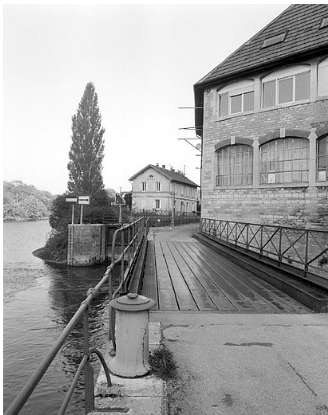
Façades antérieure et latérale gauche, depuis les ponts de halage sur les canaux de fuite de l'usine. 25, Besançon Faubourg Tarragnoz 2a, lieu-dit : îlot Tarragnoz
