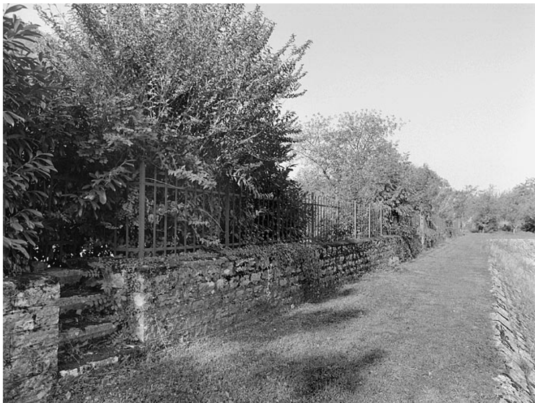
Mur de clôture du jardin, du côté de la gare d'eau.
