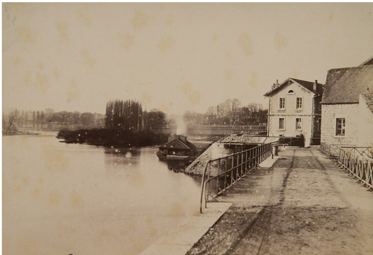
[Bateau lavoir, maison d'éclusier et pont de halage enjambant les canaux de fuite de l'usine], 4e quart 19e siècle. 25, Besançon Faubourg Tarragnoz 2 à 6, lieudit : îlot Tarragnoz
