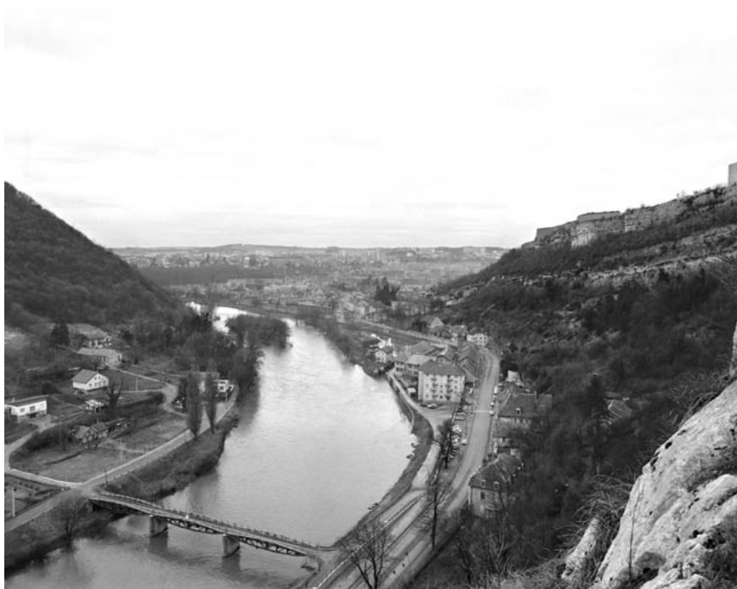
Vue d'ensemble plongeante sur l'usine et l'écluse de Tarragnoz, depuis la rive gauche en aval, en 1975. 25, Besançon Faubourg Tarragnoz 2 à 6, lieudit : îlot Tarragnoz
