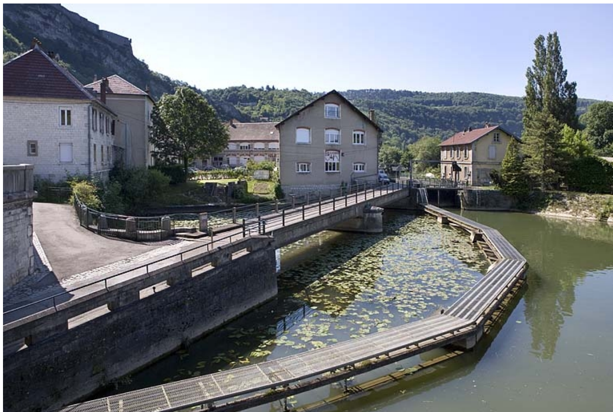
Pont de halage sur le bassin en amont des canaux d'amenée de l'usine, vu depuis la route.
