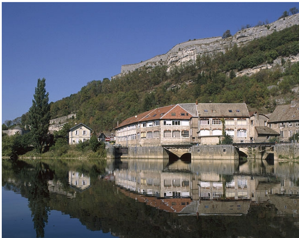
Maison d'éclusier, écluse et usine, depuis la rive gauche en aval.
