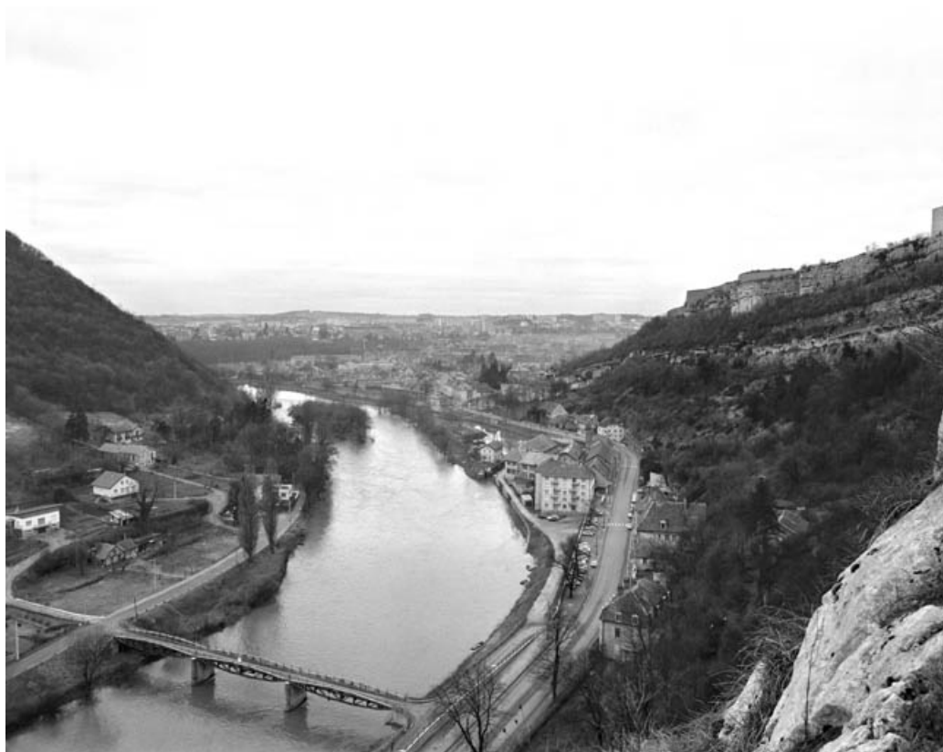
Vue d'ensemble plongeante sur l'usine et l'écluse de Tarragnoz, depuis la rive gauche en aval, en 1975. 25, Besançon Faubourg Tarragnoz 2 à 6, lieudit : îlot Tarragnoz
