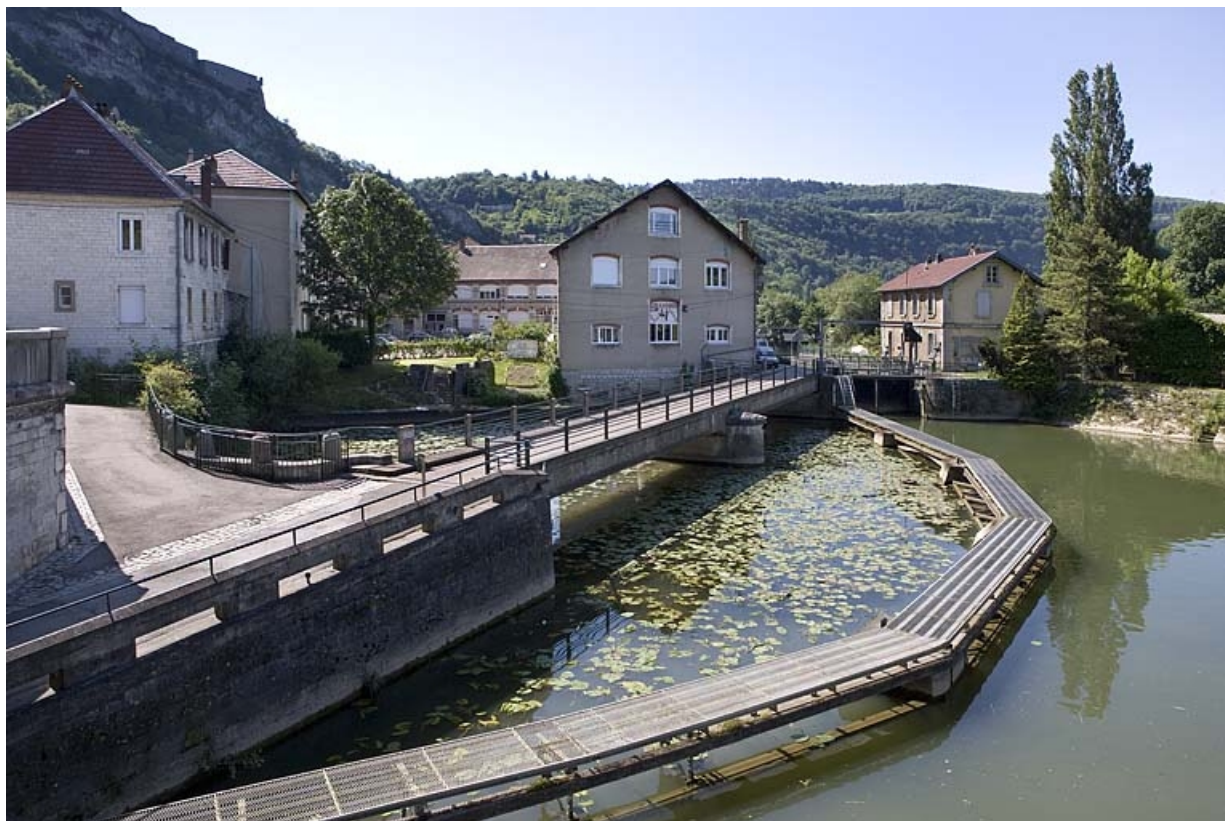
Pont de halage sur le bassin en amont des canaux d'amenée de l'usine, vu depuis la route. 25, Besançon Faubourg Tarragnoz 2 à 6, lieudit : îlot Tarragnoz
