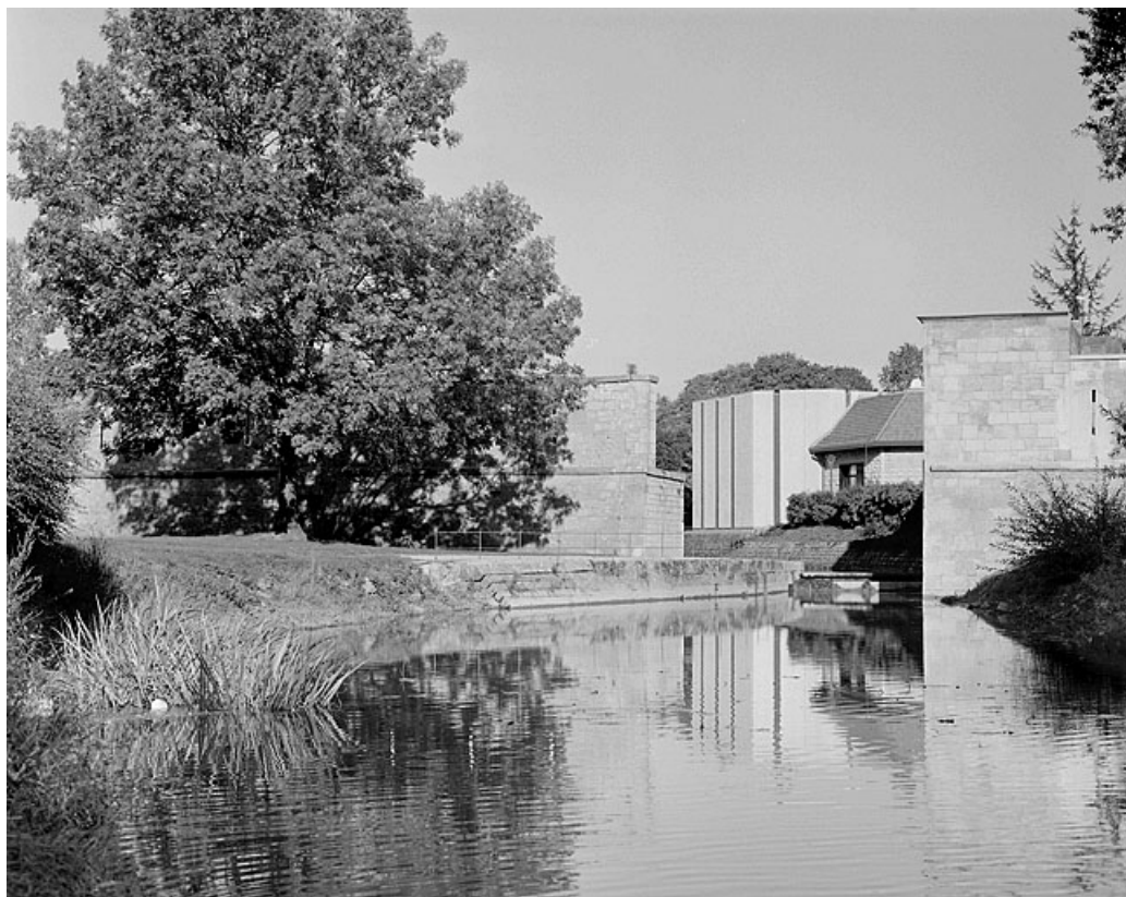
Courtine et chenal, depuis la passerelle de halage au sud.
