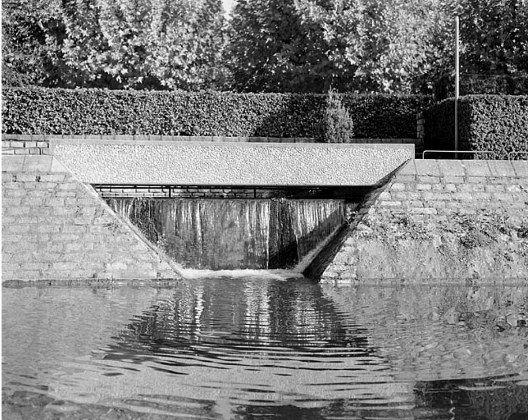
Déversoir à l'extrémité du canal de jardin.
