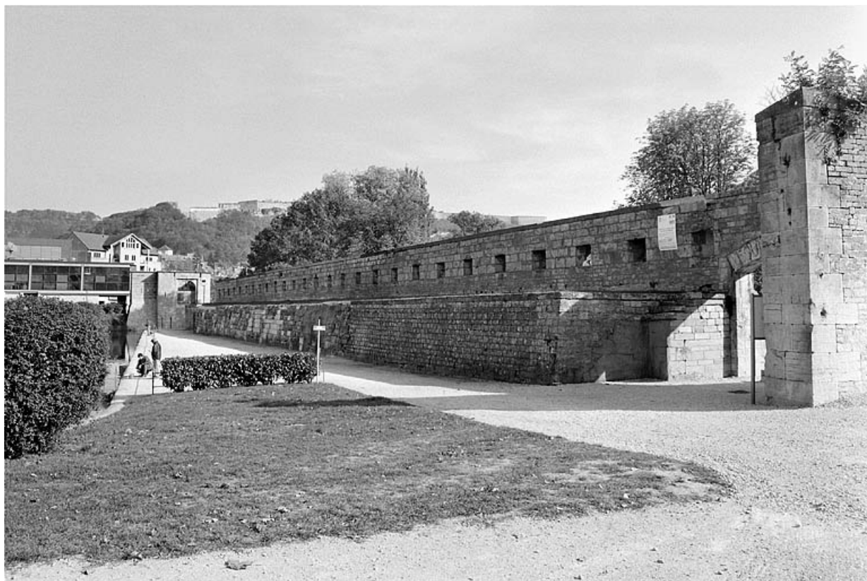
Cortine entre le bassin (à gauche) et le Doubs (à droite). 25, Besançon avenue de la Gare d'Eau, lieudit : îlot Préfecture
