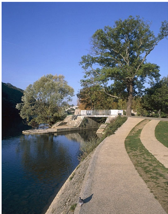
Chemin de halage et débouché du chenal dans le Doubs, depuis l'aval.
