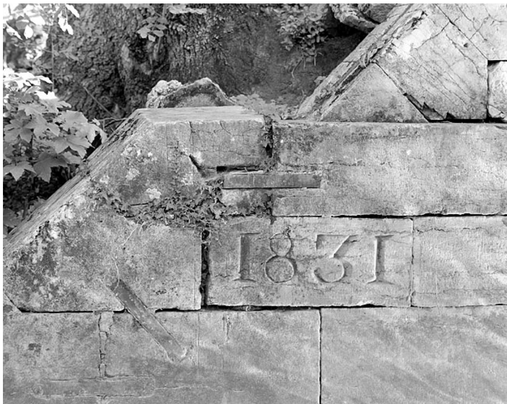
Date 1831 portée sur le bajoyer gauche de la passerelle de halage.
