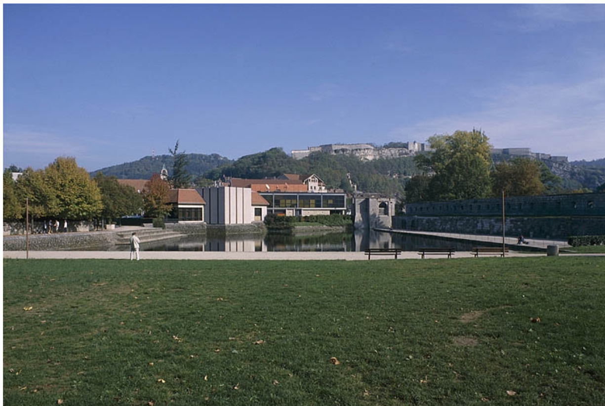
Vue d'ensemble depuis l'ouest.
