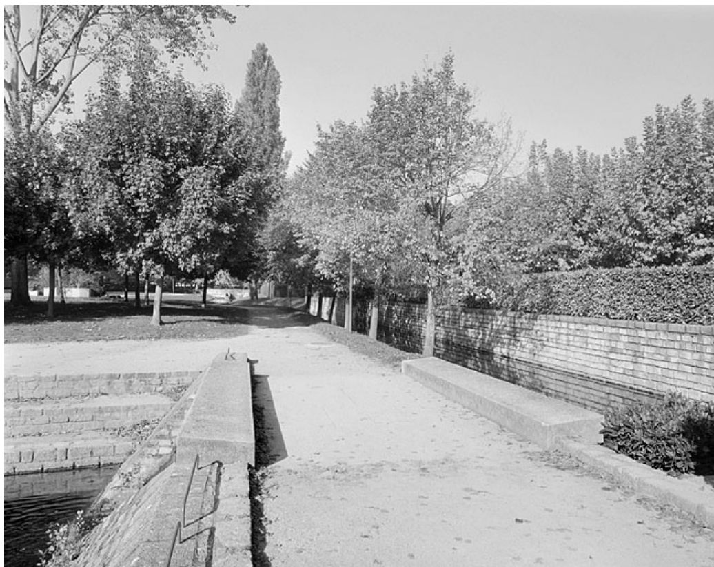
Passerelle enjambant le déversoir et canal de jardin.
