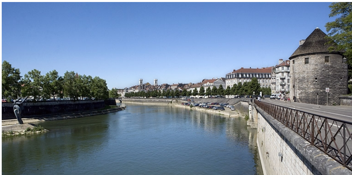
Vue d'ensemble depuis la rive droite, en amont. 25, Besançon quai de Strasbourg, lieudit : îlot Pelotte
