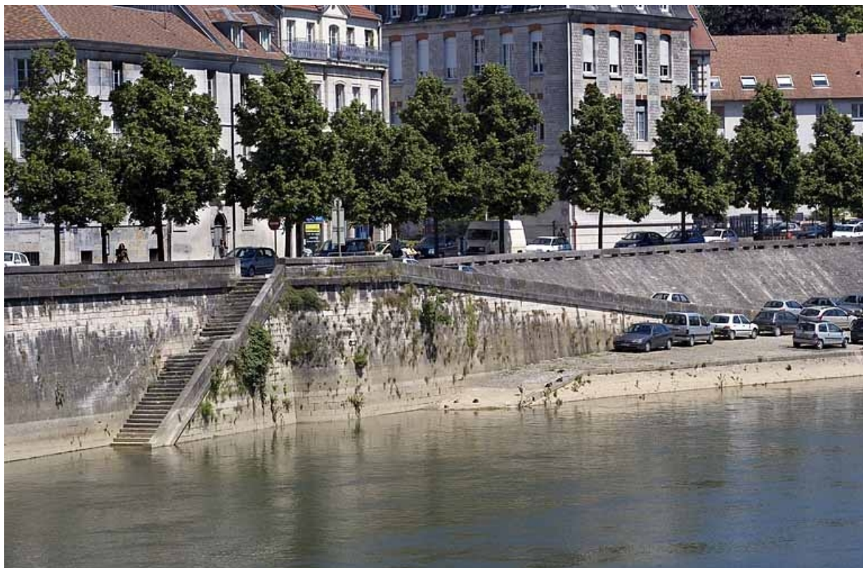
Escalier et rampes d'accès au port et au Doubs. 25, Besançon quai de Strasbourg, lieudit : îlot Pelotte
