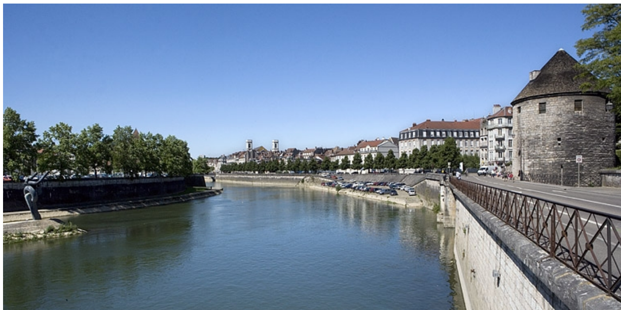
Vue d'ensemble depuis la rive droite, en amont. 25, Besançon quai de Strasbourg, lieudit : îlot Pelotte
