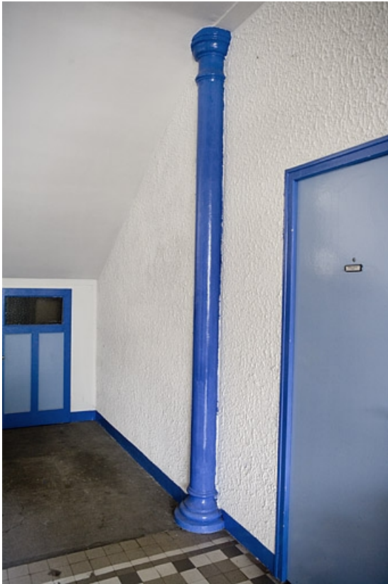
Intérieur de l'entrée : poteau en fonte.
