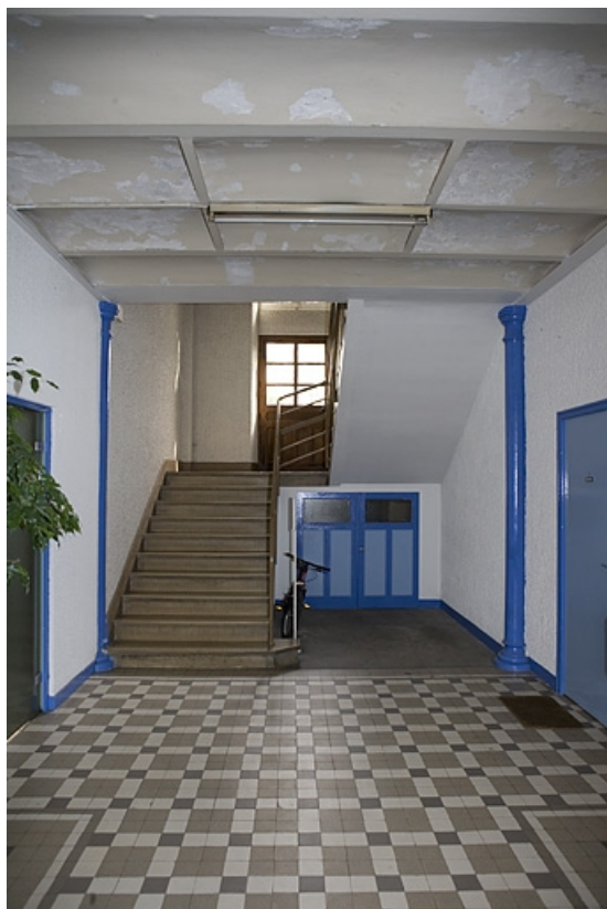
Intérieur de l'entrée : escalier, poteaux en fonte et voûtains.
