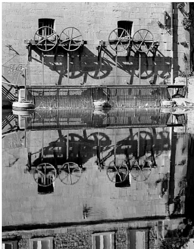
Vannes de prise d'eau à l'amont.
