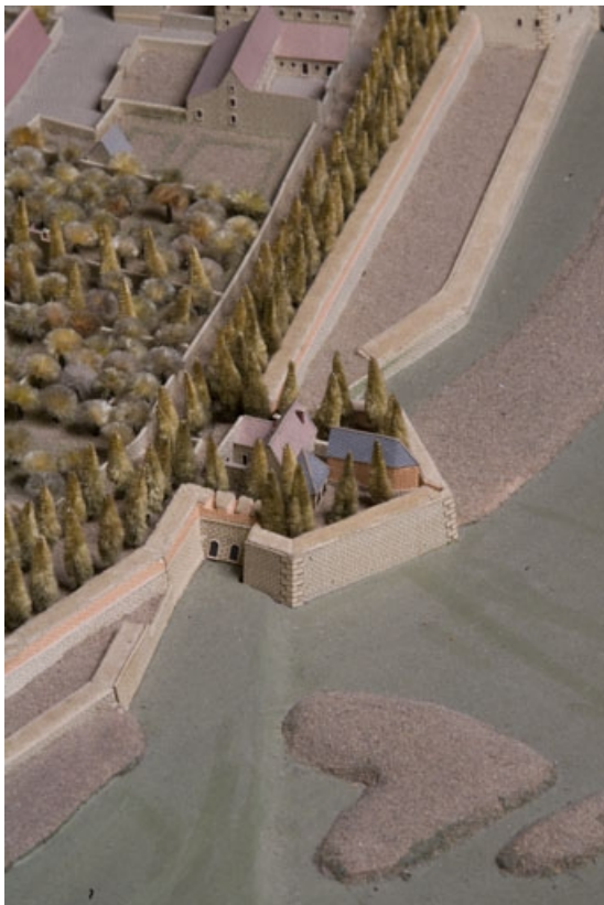
Vue plongeante sur le moulin depuis l'amont : détail du plan-relief de Besançon, 1722.
