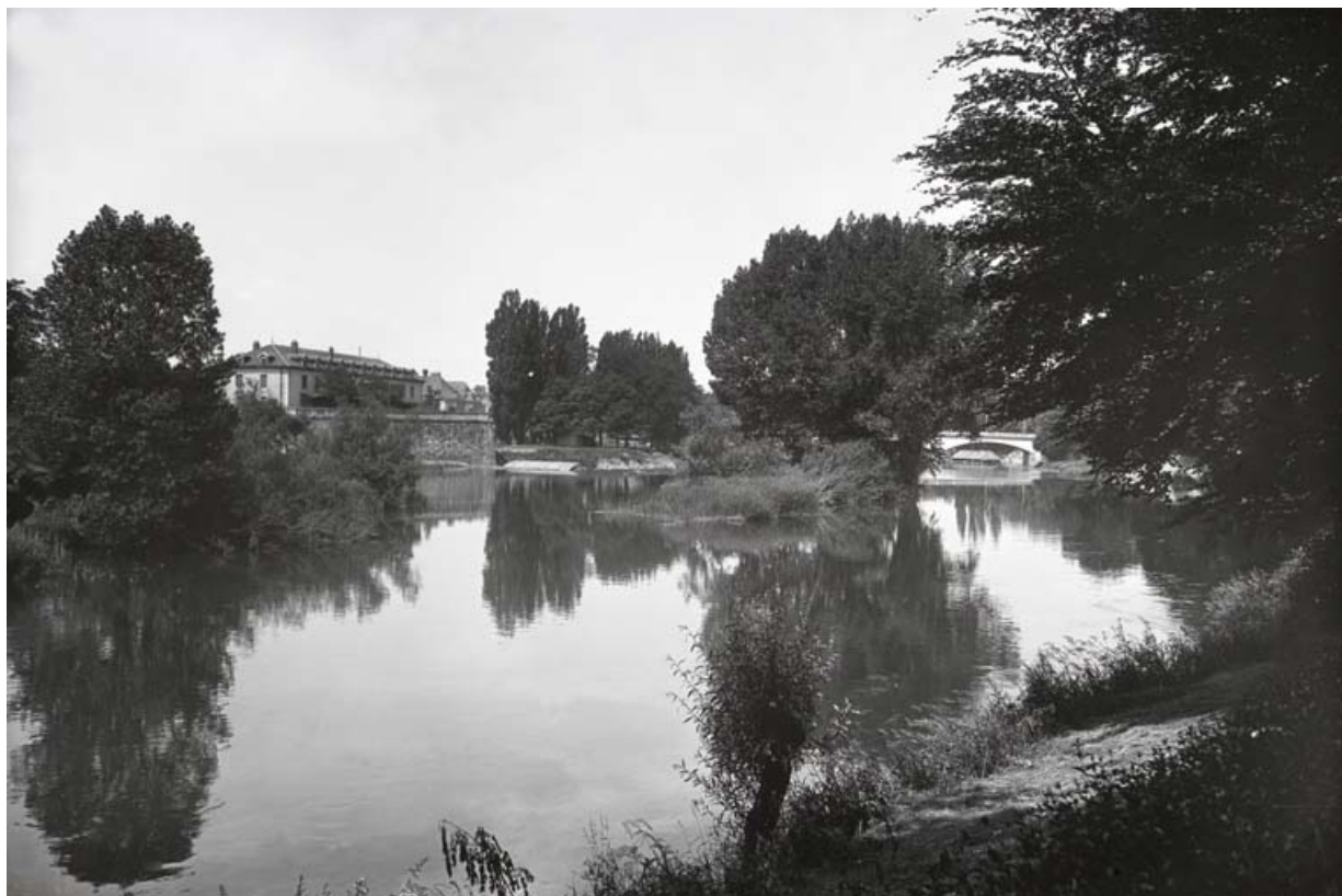
[Vue d'ensemble du moulin Saint-Paul et de son barrage, depuis la rive droite en amont], 1ère moitié 20e siècle. 25, Besançon, 18 avenue Arthur Gaulard, lieudit : îlot Moulin Saint-Paul
