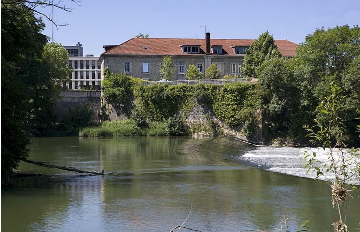
Vue d'ensemble depuis l'extrémité du barrage, rive droite.
