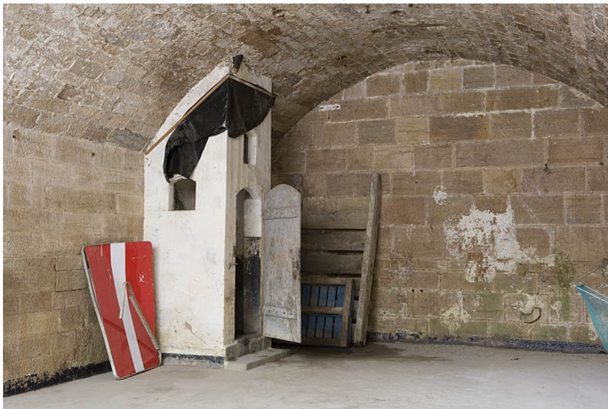
Intérieur d'une casemate : latrine et mur du fond.
