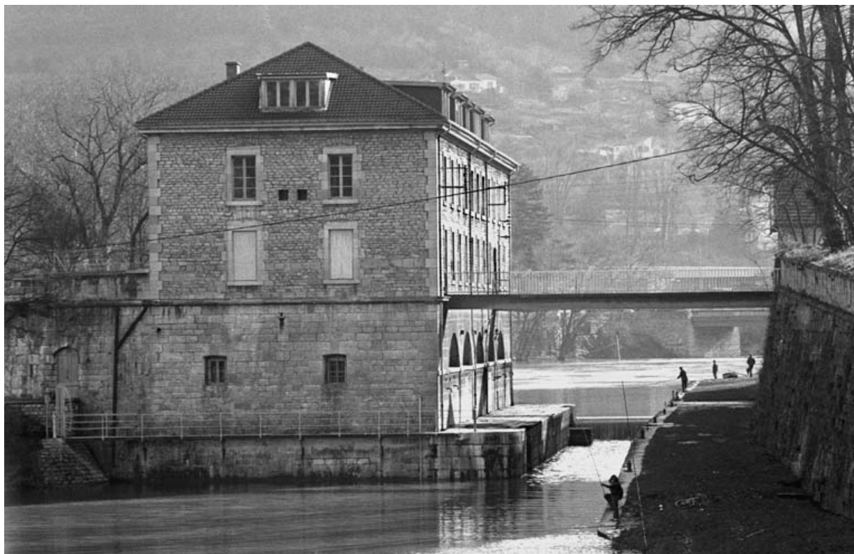
Ecluse et moulin Saint-Paul, depuis l'aval, en 1975. L'écluse est fermée à l'amont par un batardeau. 25, Besançon avenue Arthur Gaulard, lieudit : îlot Moulin Saint-Paul
