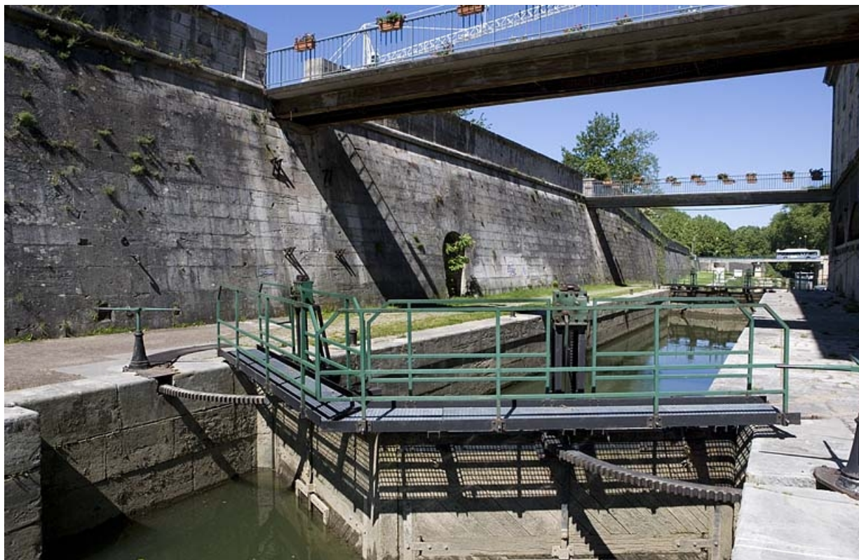
Vue d'ensemble rapprochée depuis l'amont, côté droit.
