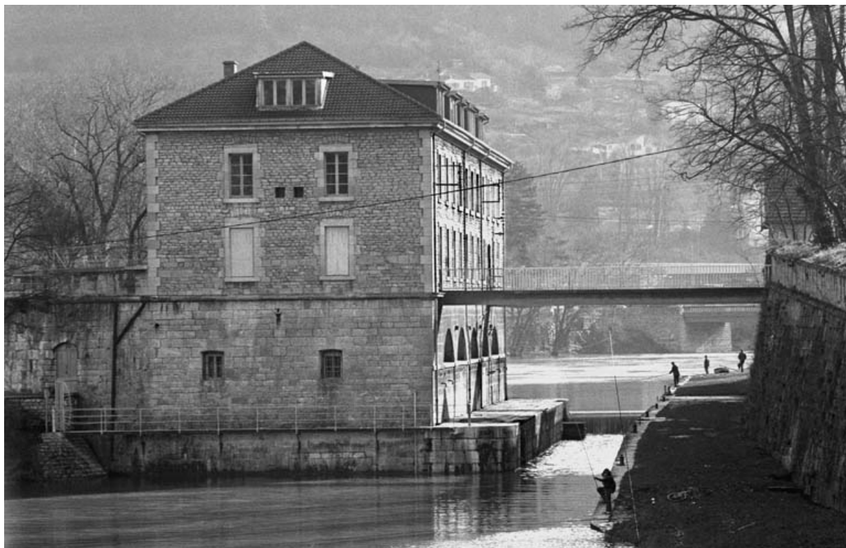
Ecluse et moulin Saint-Paul, depuis l'aval, en 1975. L'écluse est fermée à l'amont par un batardeau. 25, Besançon avenue Arthur Gaulard, lieudit : îlot Moulin Saint-Paul
