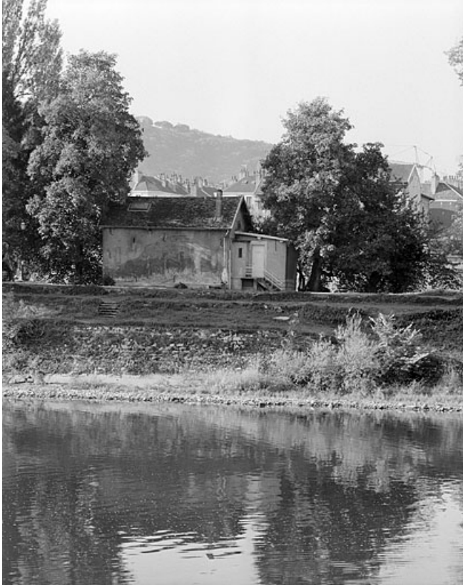
Façade antérieure en 2003, avant restauration.
