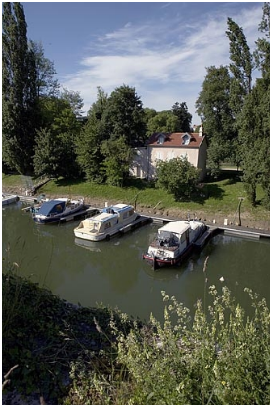
Vue d'ensemble depuis la rive gauche du canal (façade postérieure).
