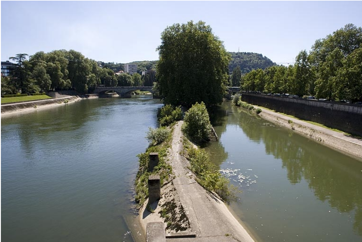
Vue d'ensemble du Doubs, du canal et de leur digue de séparation, depuis le pont Denfert-Rochereau (en aval). 25, Besançon, 4 pont de la République, lieudit : îlot Moulin Saint-Paul
