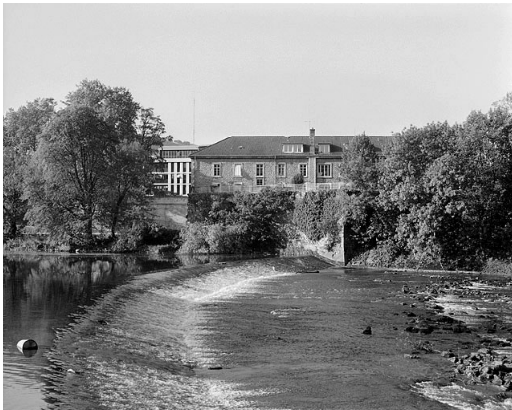
Vue d'ensemble depuis l'extrémité du barrage, rive droite.
