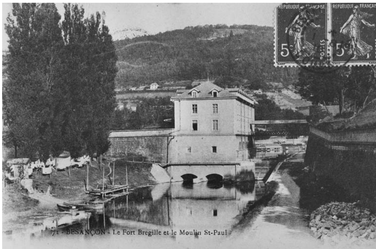
Besançon - Le Fort Brégille et le Moulin St-Paul, entre 1906 et 1910.
