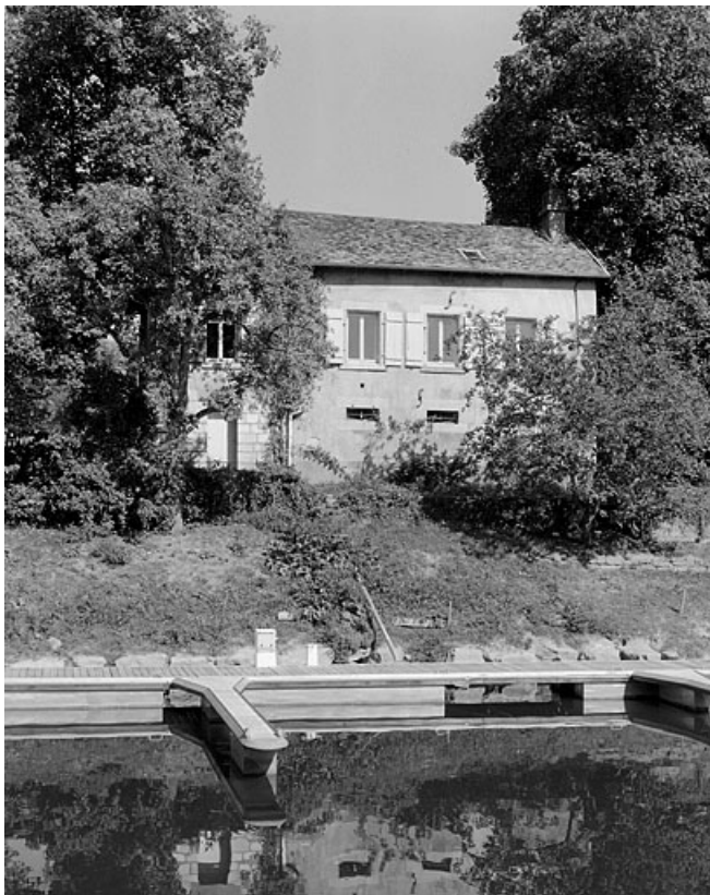
Façade postérieure de la maison d'éclusier (côté canal), en 2003. Le bâtiment a été restauré en 2004. 25, Besançon, 4 pont de la République, lieudit : îlot Moulin Saint-Paul
