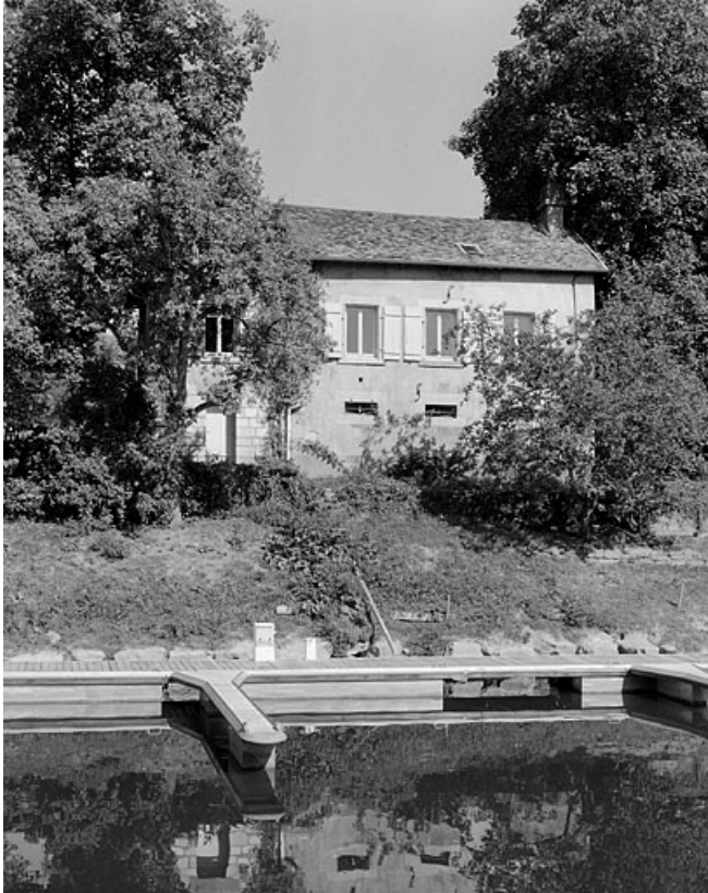
Façade postérieure de la maison d'éclusier (côté canal), en 2003. Le bâtiment a été restauré en 2004. 25, Besançon, 4 pont de la République, lieudit : îlot Moulin Saint-Paul
