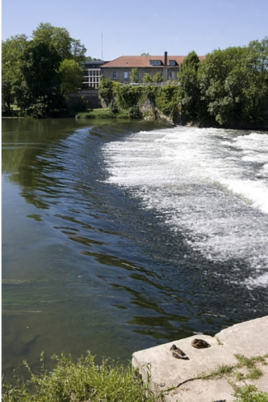
Vue d'ensemble depuis l'extrémité du barrage, rive droite (cadrage vertical). 25, Besançon, 4 pont de la République, lieudit : îlot Moulin Saint-Paul
