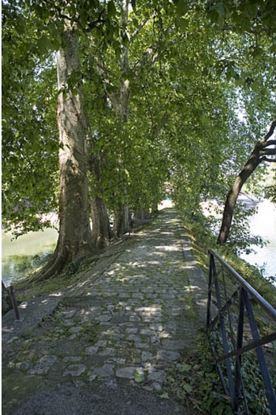
Sommet de la digue de séparation, vers le pont de la République. Le canal est à gauche, le Doubs à droite. 25, Besançon, 4 pont de la République, lieudit : îlot Moulin Saint-Paul
