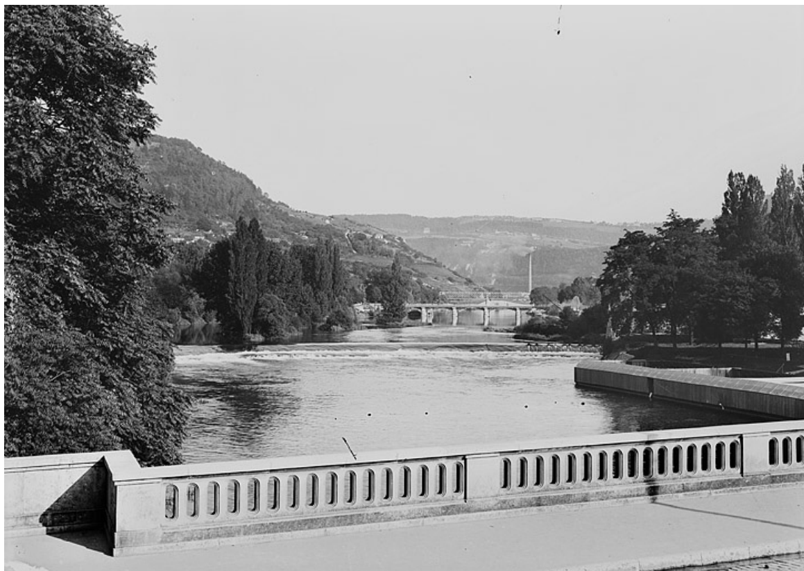
[Vue d'ensemble du barrage de Saint-Paul et du Doubs vers l'amont, depuis le pont de la République], 1ère moitié 20e siècle. 25, Besançon, 4 pont de la République, lieudit : îlot Moulin Saint-Paul
