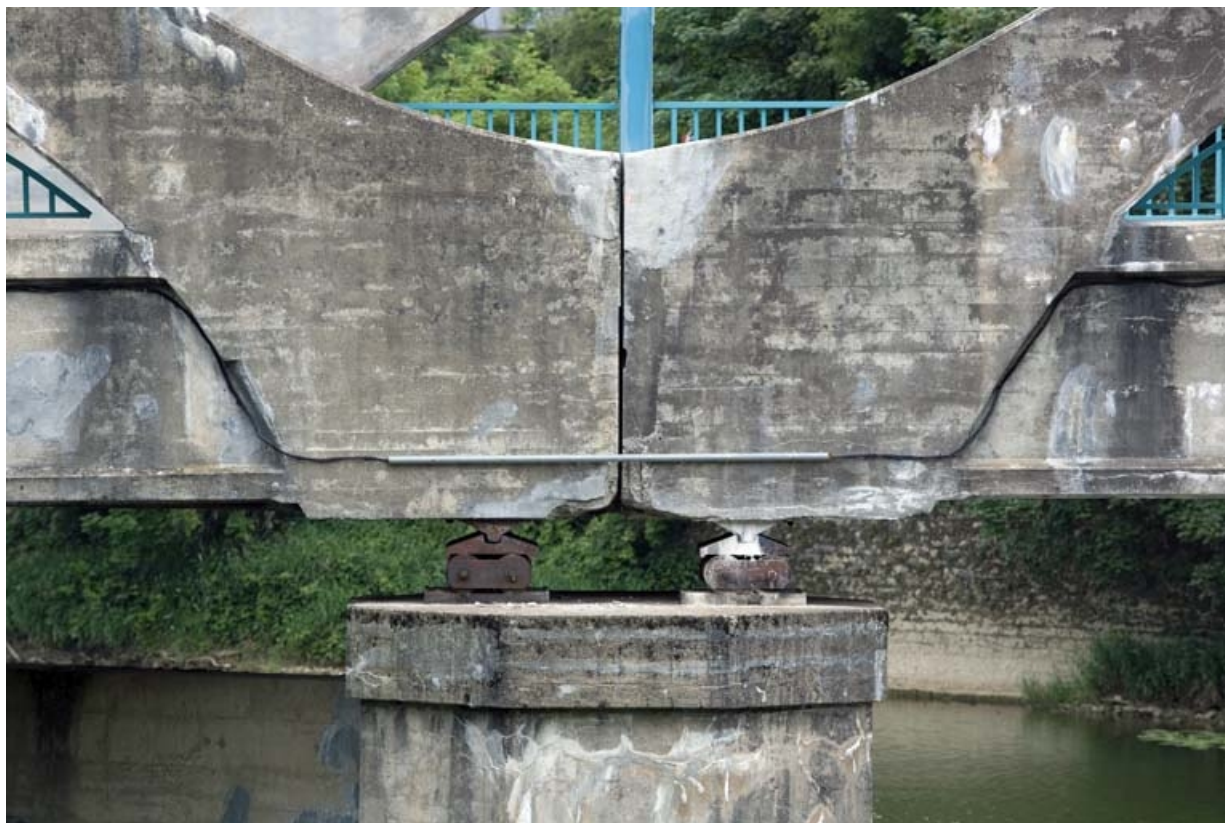
Doubles rotules supportant le tablier (piles côté rive gauche).
