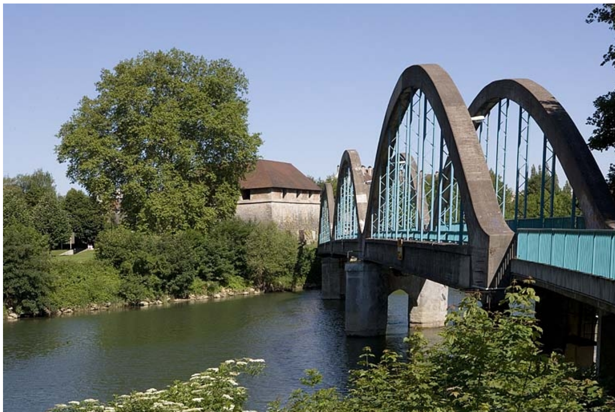
Face amont depuis la rive droite.
