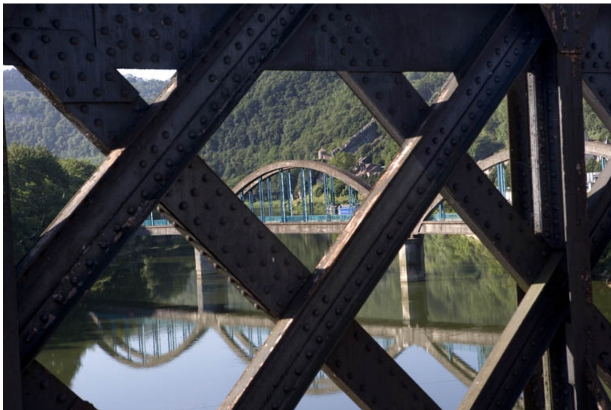
Vue d'ensemble du pont au travers du treillis métallique du pont-rail de la ligne de Morteau.
