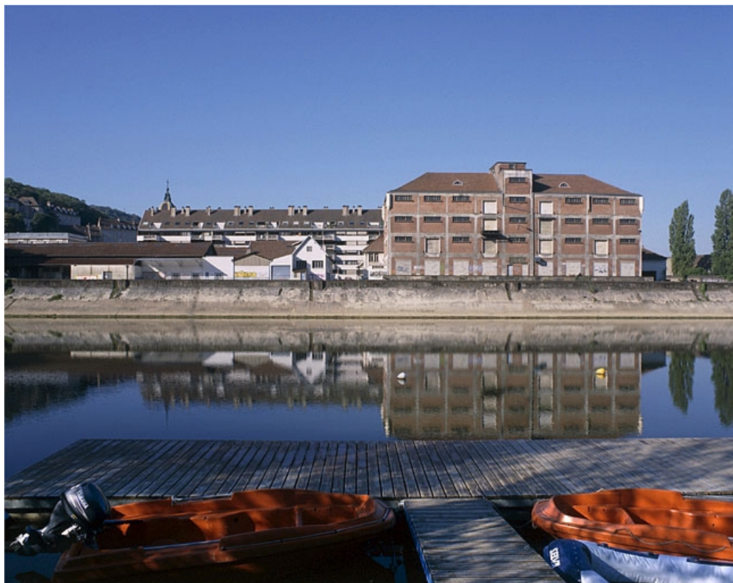
Vue d'ensemble depuis la rive droite, 2003. 25, Besançon, 4 à 16 avenue Arthur Gaulard
