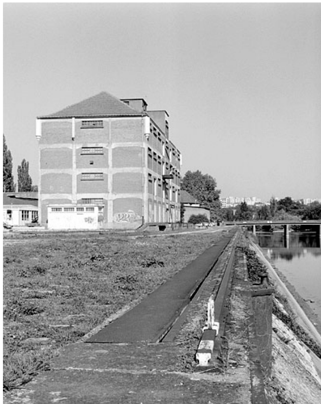
Entrepôt et quai, depuis l'amont (vue rapprochée)
