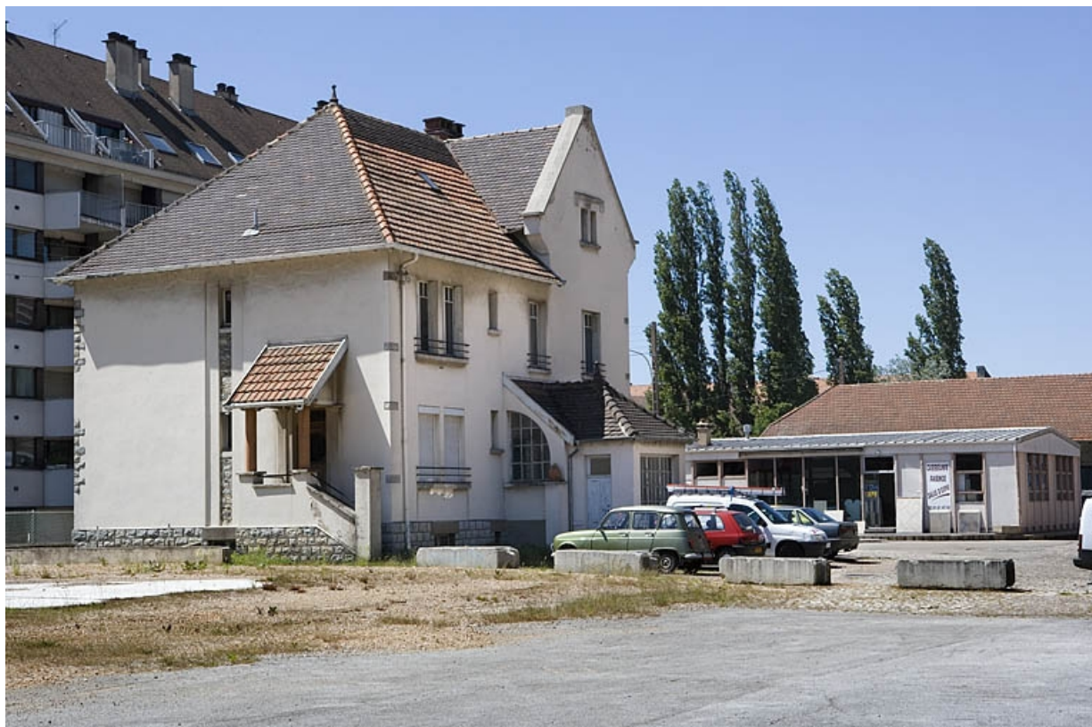
Bureau : façade postérieure de trois quarts gauche.
