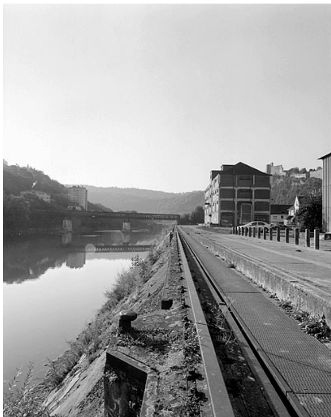
Entrepôt et quai, depuis l'aval.
