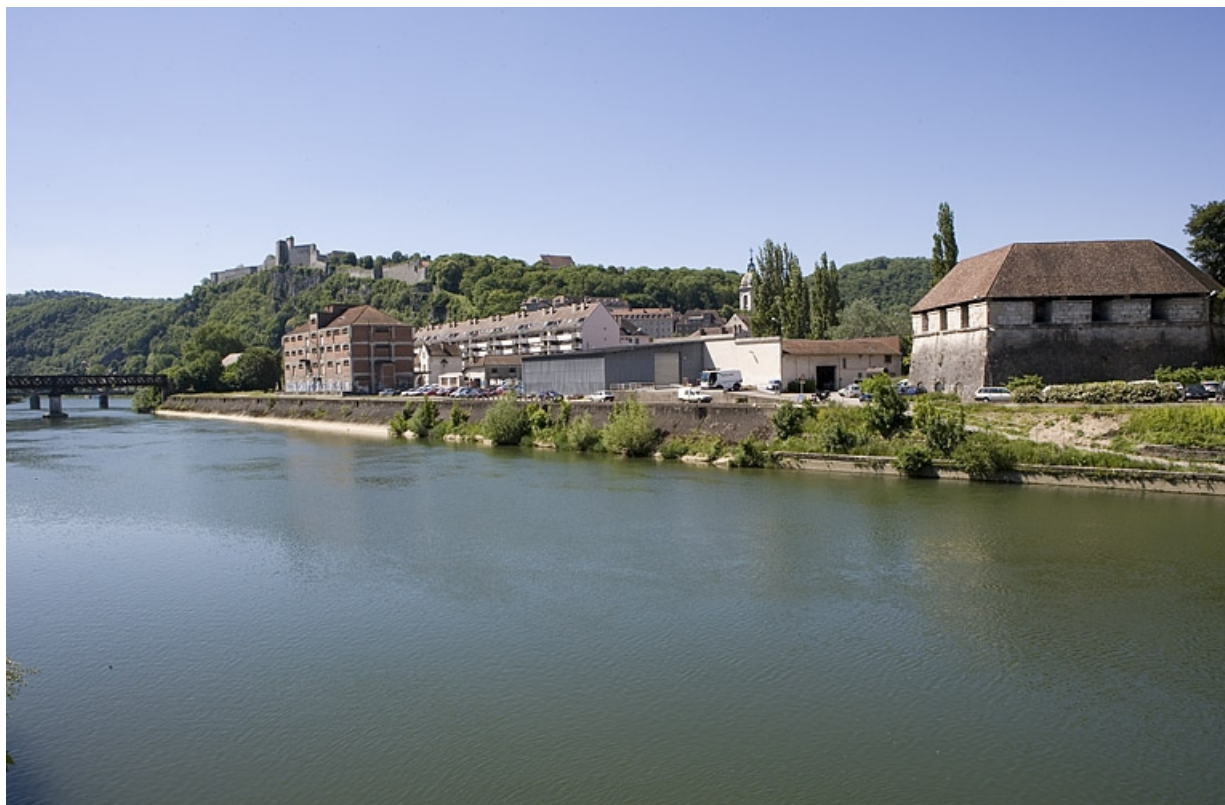
Vue d'ensemble depuis le nord (rive droite en aval).
