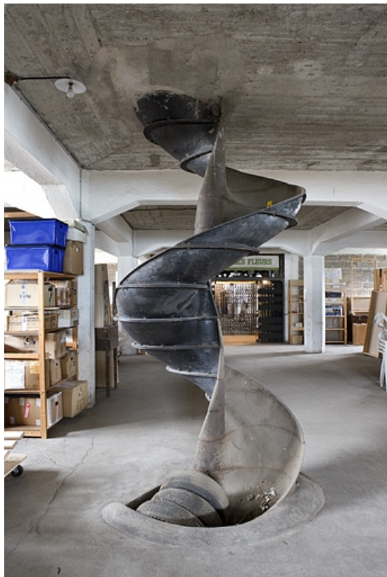
Entrepôt : toboggan à l'intérieur du 2e étage. 25, Besançon, 4 à 16 avenue Arthur Gaulard
