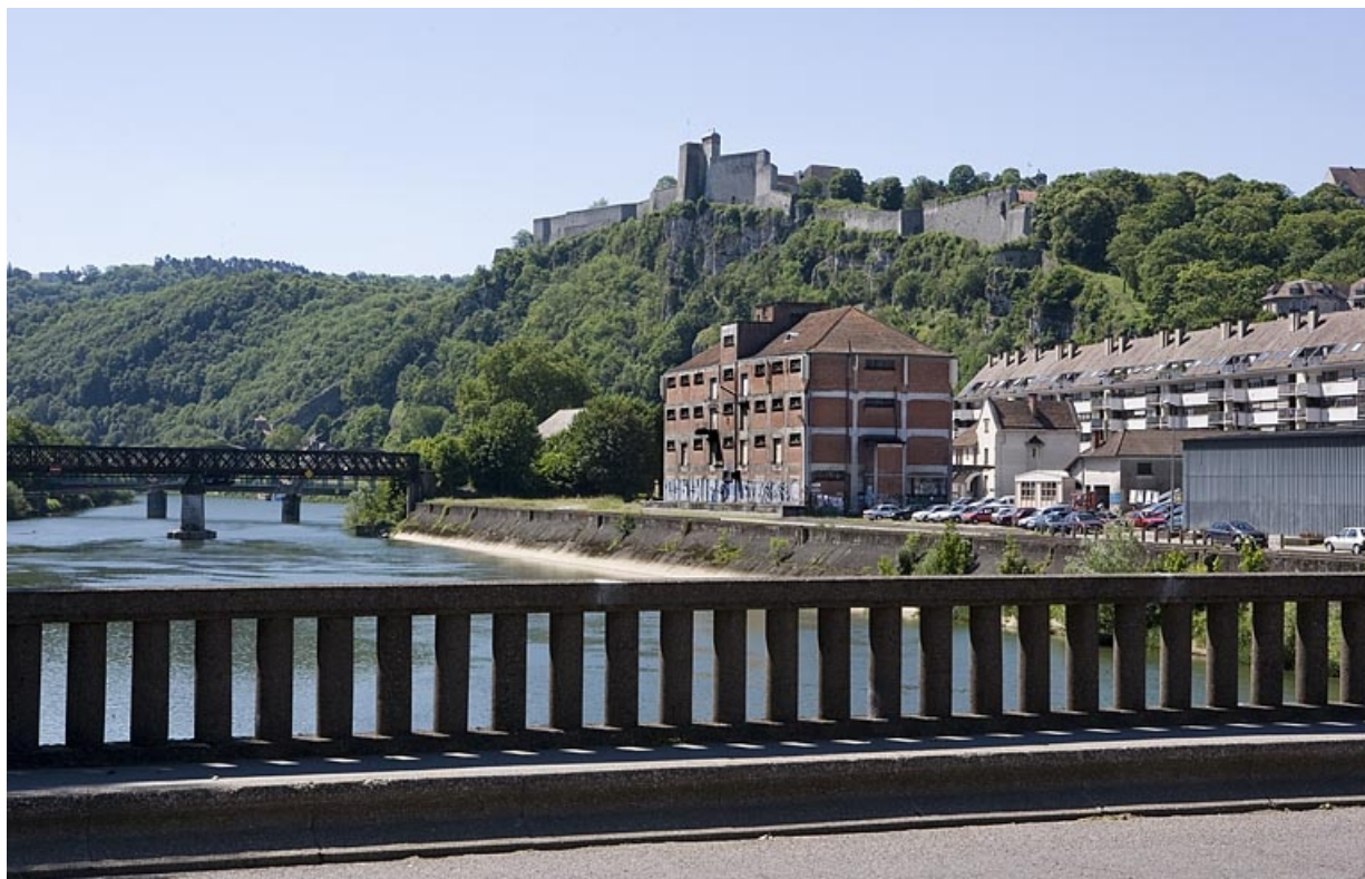
Entrepôt et quai, depuis le pont de Bregille en aval.
