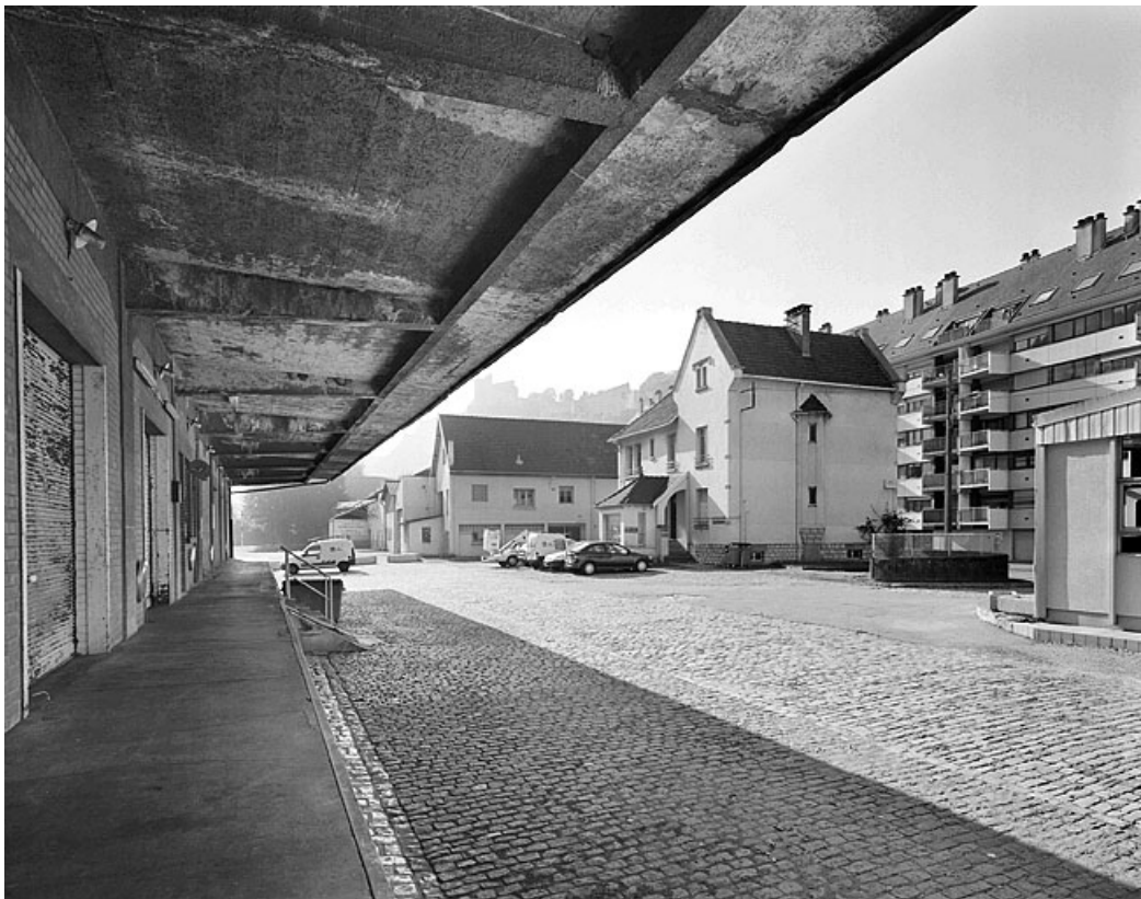
Vue d'ensemble de la cour depuis le quai protégé par l'auvent, 2003. Les entrepôts des particuliers, au fond, ont été démolis en 2004.
