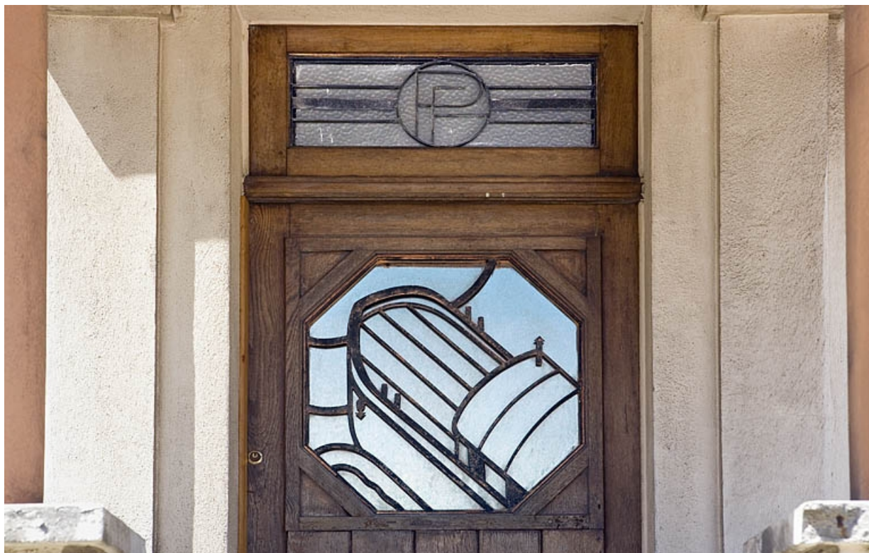
Bureau : décor de ferronnerie avec les initiales PF (Port fluvial) et le dessin d'une péniche. 25, Besançon, 4 à 16 avenue Arthur Gaulard
