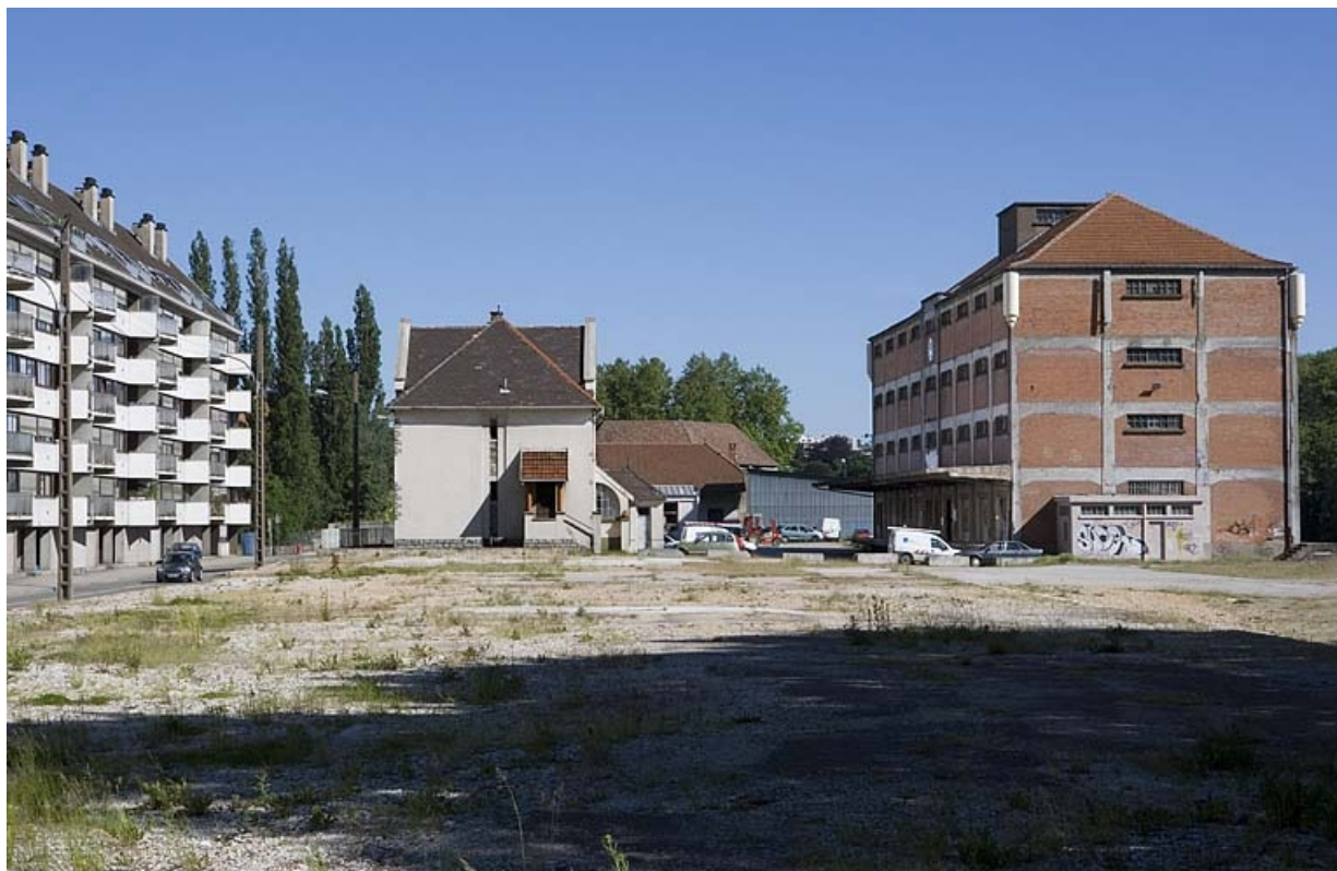
Entrepôt et bureau, depuis l'emplacement des entrepôts des particuliers démolis.
