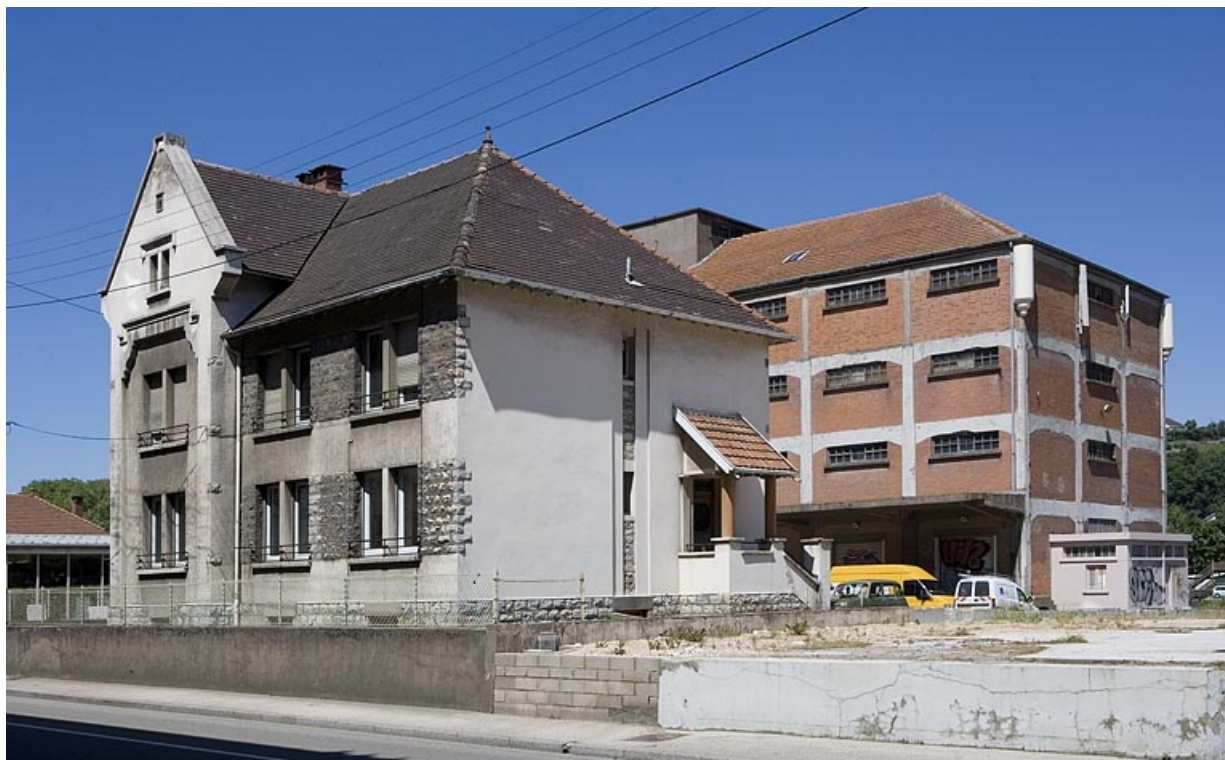
Bureau : façade antérieure de trois quarts droite.
