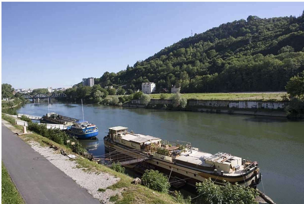
Vue d'ensemble depuis la rive gauche, en amont.
