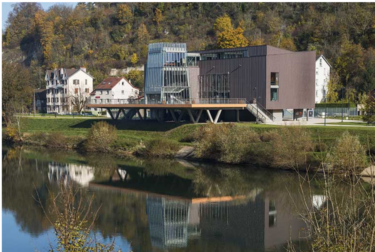
La salle des musiques actuelles La Rodia, depuis l'amont. 25, Besançon avenue De Chardonnet, lieudit : les Près-de-Vaux
