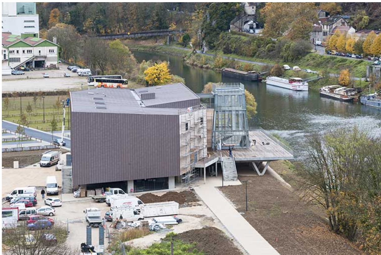
Vue plongeante sur la salle des musiques actuelles La Rodia. 25, Besançon avenue De Chardonnet, lieudit : les Près-de-Vaux
