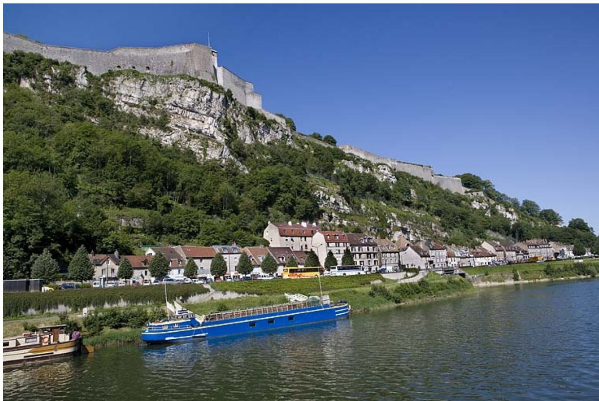
Vue d'ensemble de la partie sud depuis la rive droite : chemin de halage et bateaux amarrés aux pontons. 25, Besançon Faubourg Rivotte, lieu-dit : îlot Porte Rivotte
