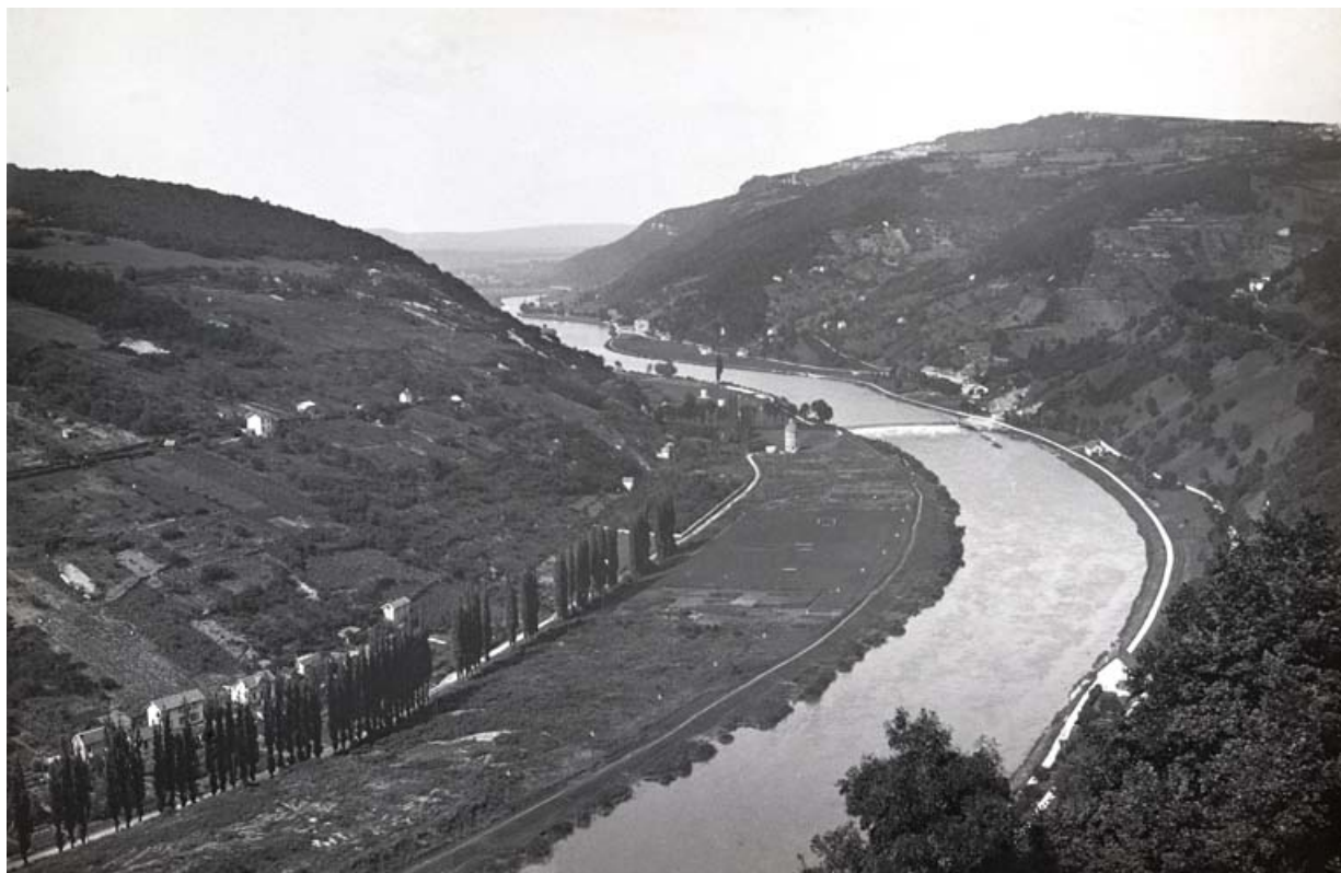
[Vue d'ensemble plongeante sur la vallée du Doubs et le site d'écluse de la Malate, depuis l'aval], 1ère moitié 20e siècle. 25, Besançon, 35 chemin de la Malate, lieudit : la Malate
