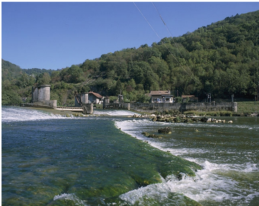
Vue d'ensemble depuis l'extrémité du barrage, rive droite.
