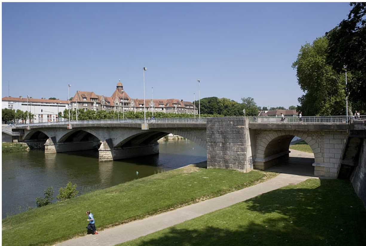
Le pont Canot et le chemin de halage. 25, Besançon
