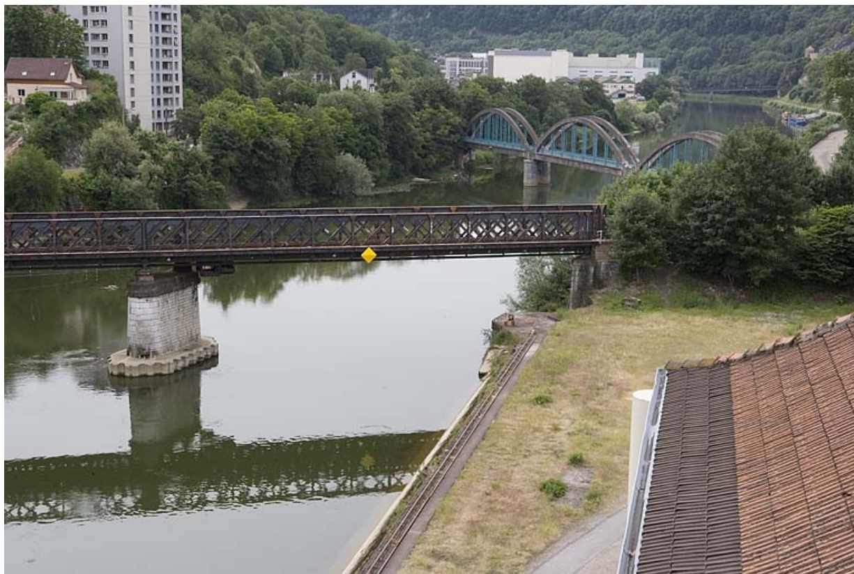
Vue d'ensemble du Doubs vers l'amont, depuis le toit de l'entrepôt du Port fluvial. 25, Besançon
