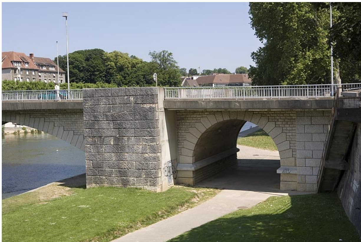
Arche permettant le passage du chemin de halage sous le pont Canot. 25, Besançon
