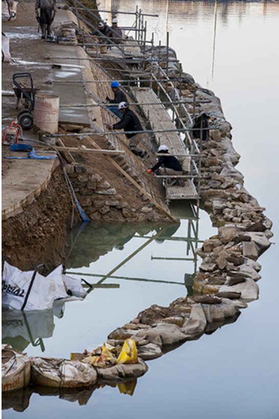
Réfection du perré du chemin de halage en aval du moulin Saint-Paul : coupe du perré. 25, Besançon
