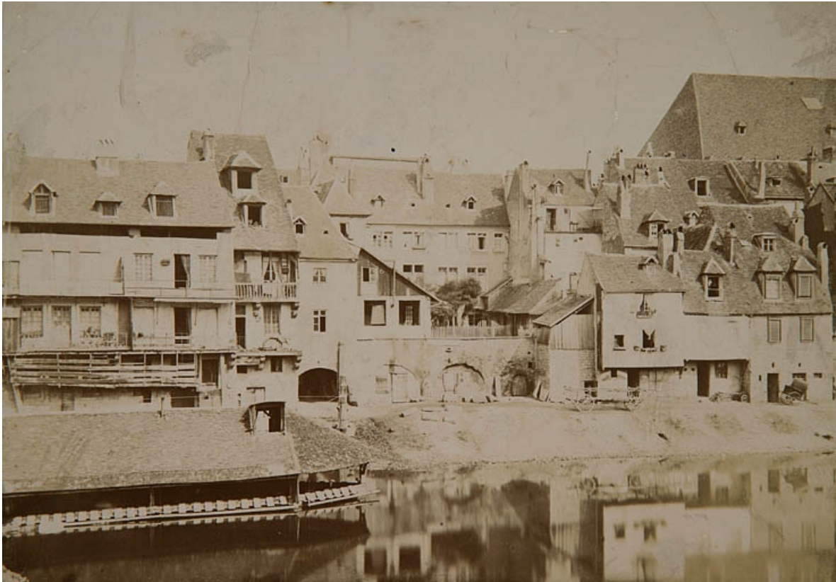
[Barque lavandière et façade sur l'eau des maison du quartier Battant avant la construction du quai Veil-Picard], milieu 19e siècle. 25, Besançon
