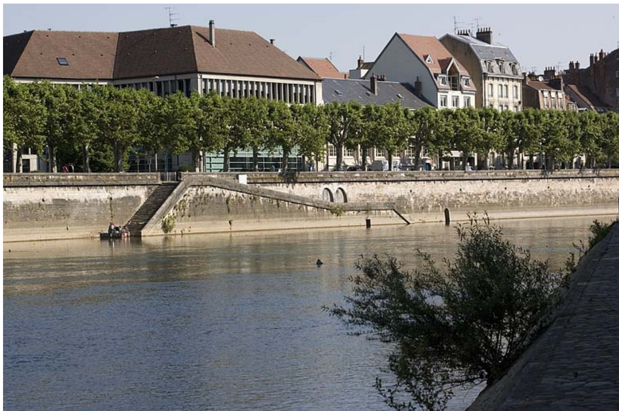
Escalier et rampe d'accès à la rivière, quai Veil-Picard (rive droite). 25, Besançon
