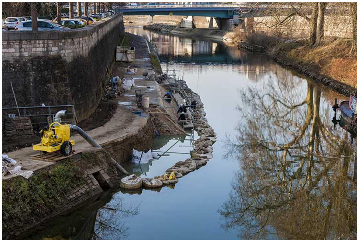
Réfection du perré du chemin de halage en aval du moulin Saint-Paul : vue d'ensemble depuis l'amont. 25, Besançon
