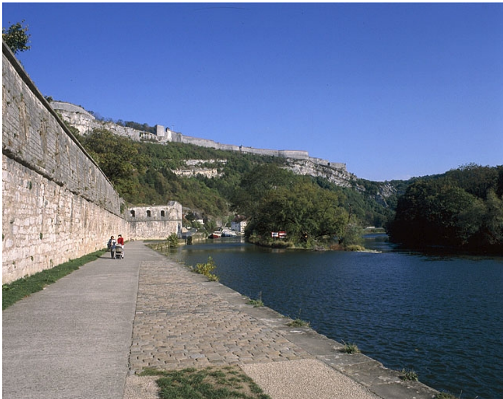
Le Doubs et le chemin de halage en aval de Chamars, entre la guérite double et le bastion Notre-Dame. 25, Besançon
