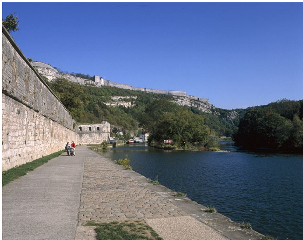
Le Doubs et le chemin de halage en aval de Chamars, entre la guérite double et le bastion Notre-Dame. 25, Besançon
