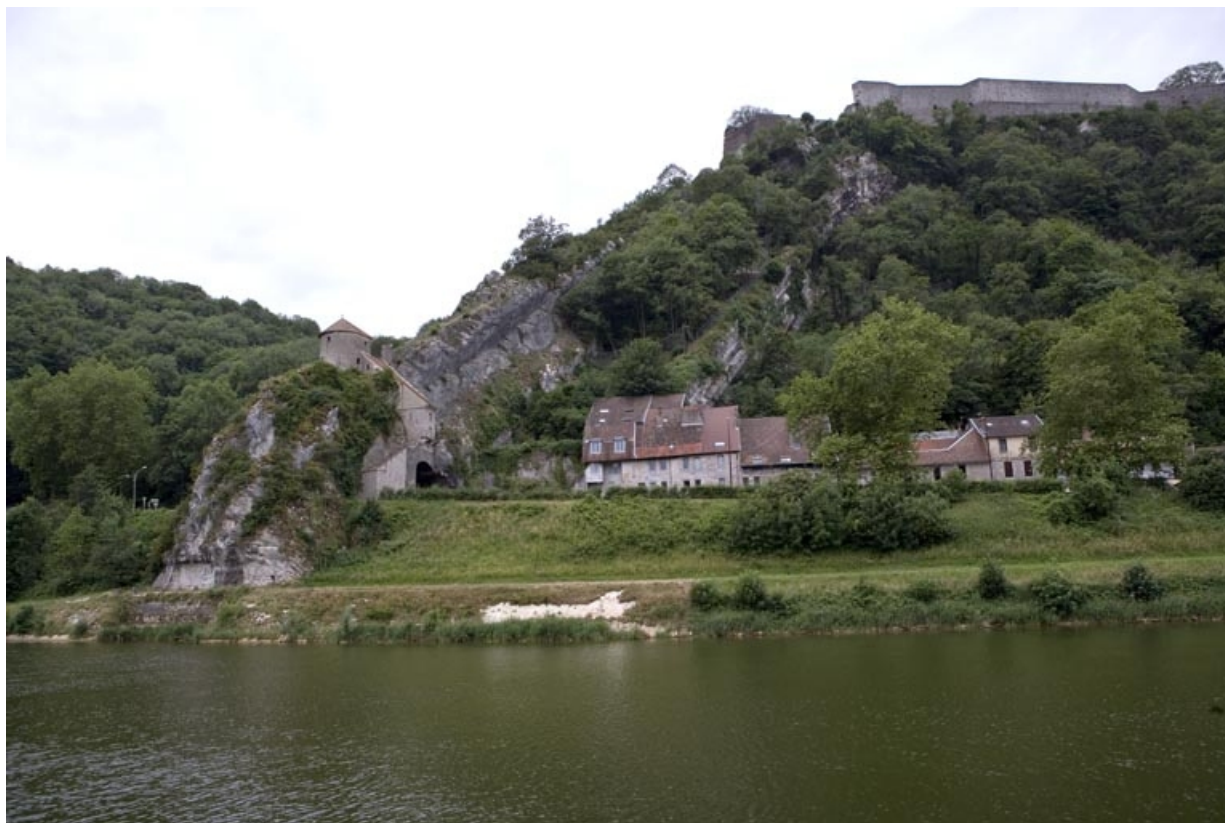
Quai au niveau de la Porte Taillée et partie sud du port de Rivotte, depuis la rive droite. 25, Besançon
