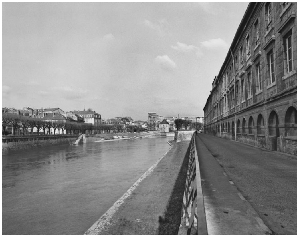
Vue d'ensemble du chemin de halage et du port de Strasbourg, depuis le quai Vauban (rive gauche en aval), en 1975. 25, Besançon
