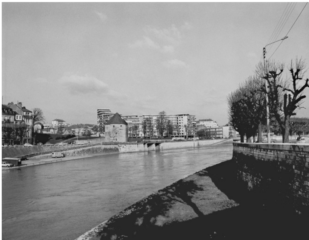
Vue d'ensemble de la rive droite vers la tour de la Pelote (rampe d'accès au port de Strasbourg et débouché du ruisseau de la Mouillère), depuis le bastion du Saint-Esprit (rive gauche en aval), en 1975.
