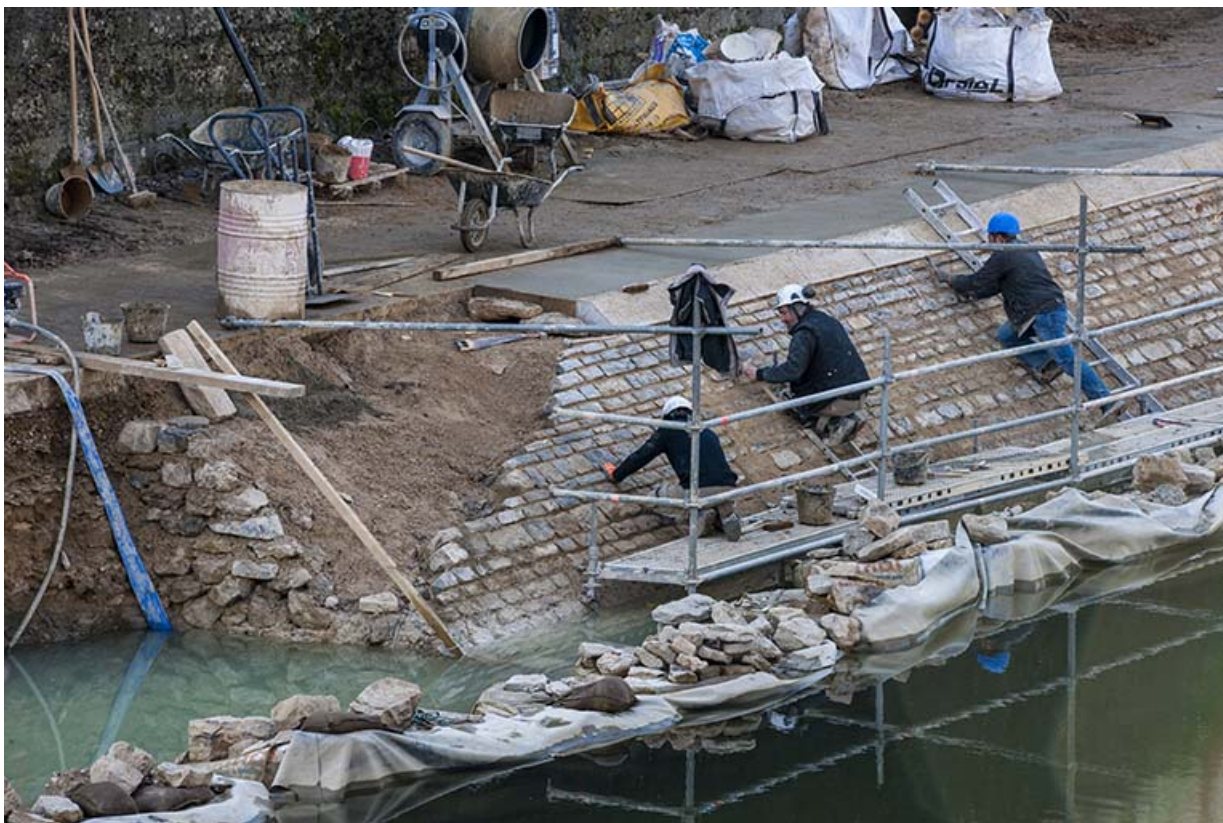
Réfection du perré du chemin de halage en aval du moulin Saint-Paul : ouvriers refaisant le parement. 25, Besançon
