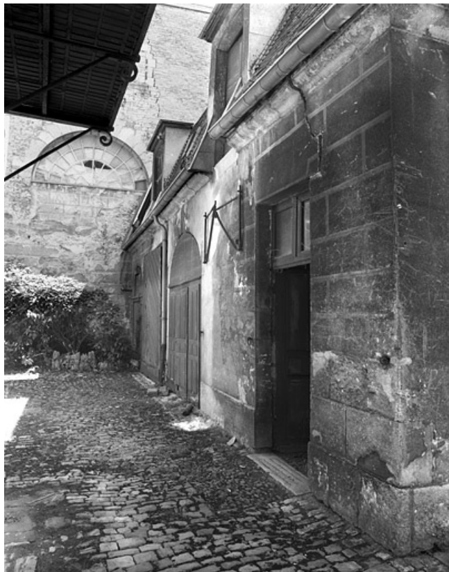
Façade antérieure de trois quarts droit des remises et écurie. 25, Besançon, 86 rue des Granges, lieudit : îlot Forum
