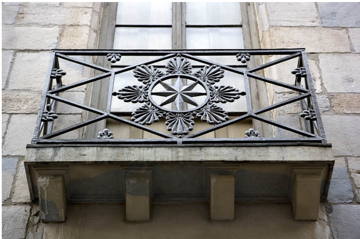
Détail de la ferronnerie d'un balcon : premier étage sur rue.
