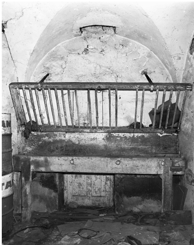
Etable : vue de l'intérieur.
