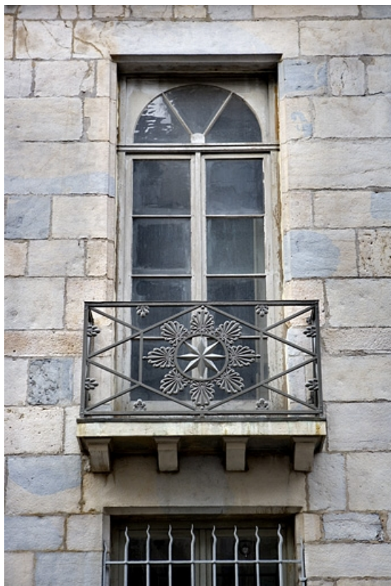
Détail d'une fenêtre du premier étage sur rue.
