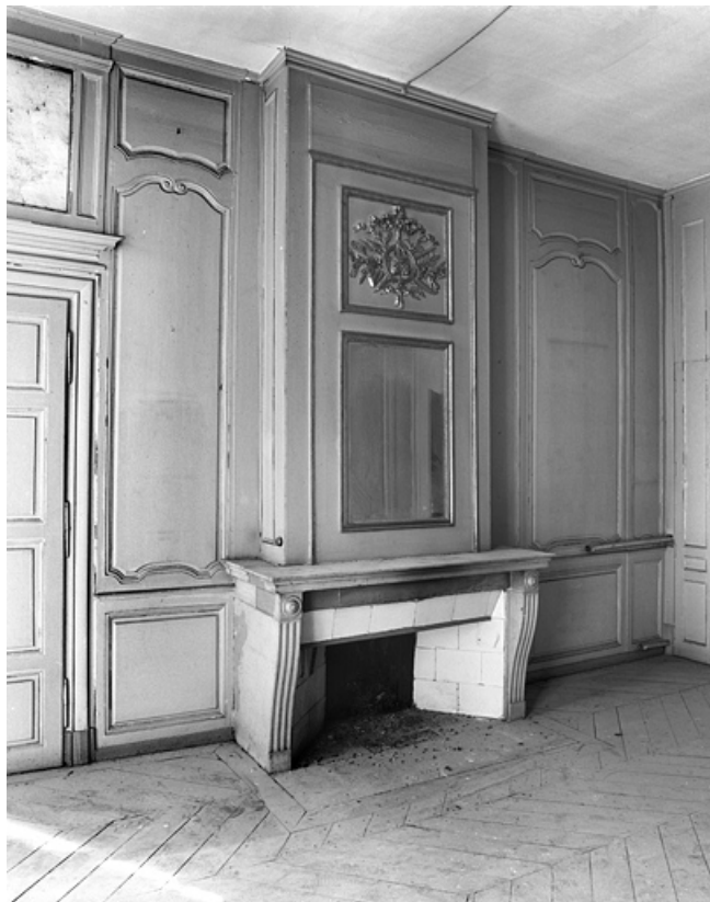
Logis principal : vue d'une cheminée dans une pièce du premier étage.
