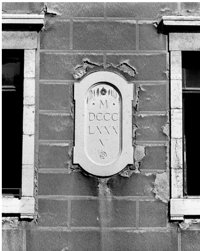
Logis secondaire : façade antérieure, détail du médaillon gauche.
