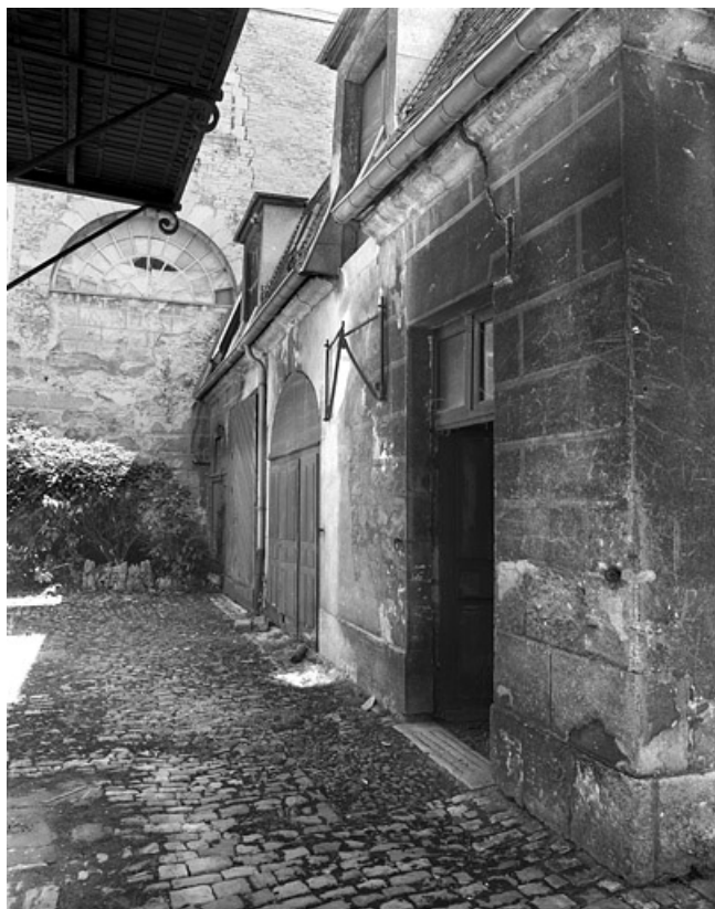
Façade antérieure de trois quarts droit des remises et écurie.
