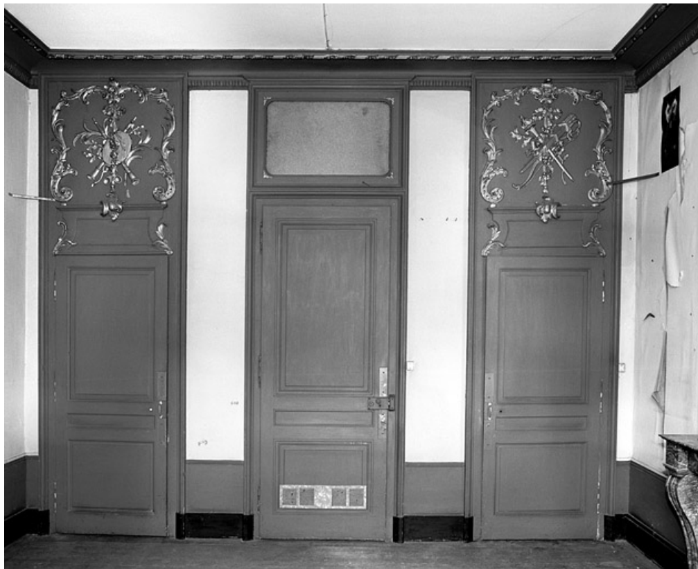
Logis secondaire droit : détail des lambris d'une pièce du premier étage.
