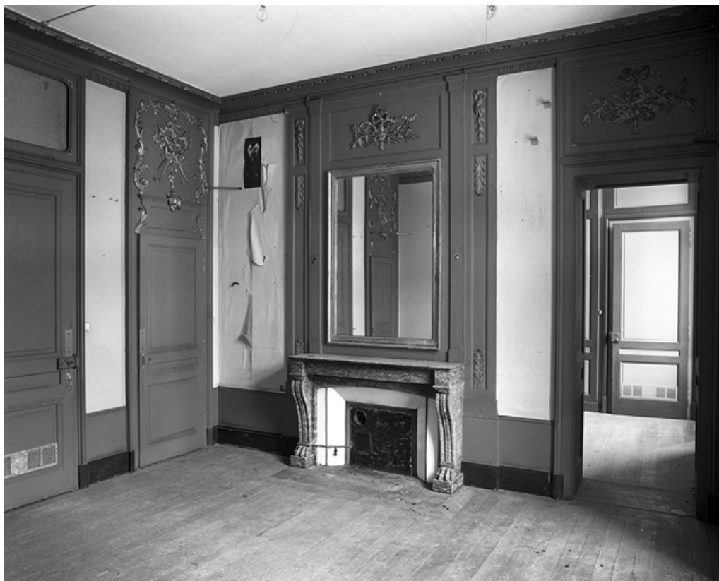
Logis secondaire droit : détail d'une pièce du premier étage.
