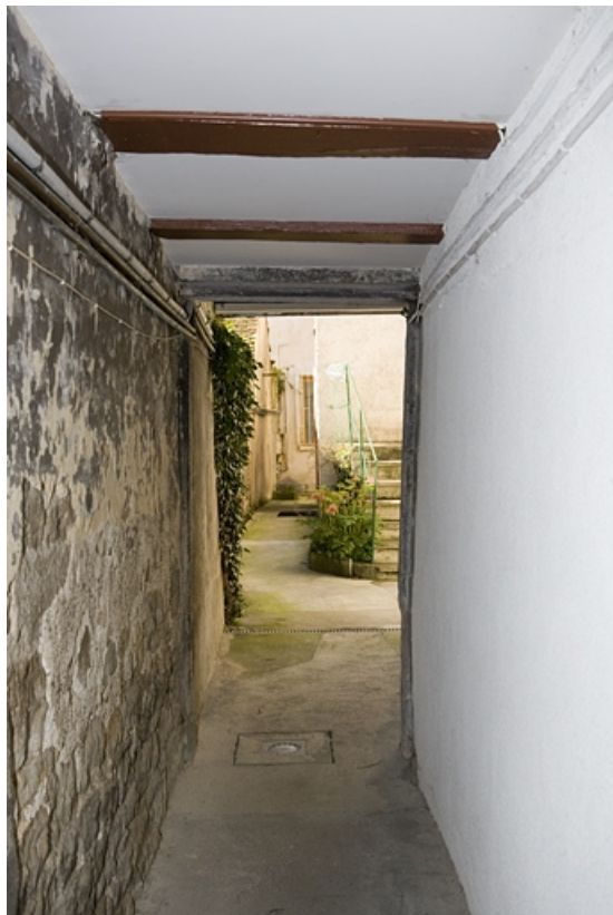
Détail du couloir à gauche du logis secondaire donnant accès à la deuxième cour. 25, Besançon, 80 rue des Granges, lieudit : îlot Forum
