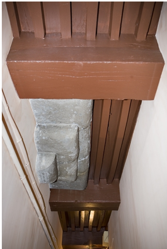
Détail de l'encorbellement en pierre de taille situé dans le premier couloir.
