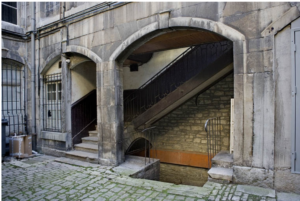
Détail des arcades situées au rez-de-chaussée de l'aile gauche dans la première cour.
