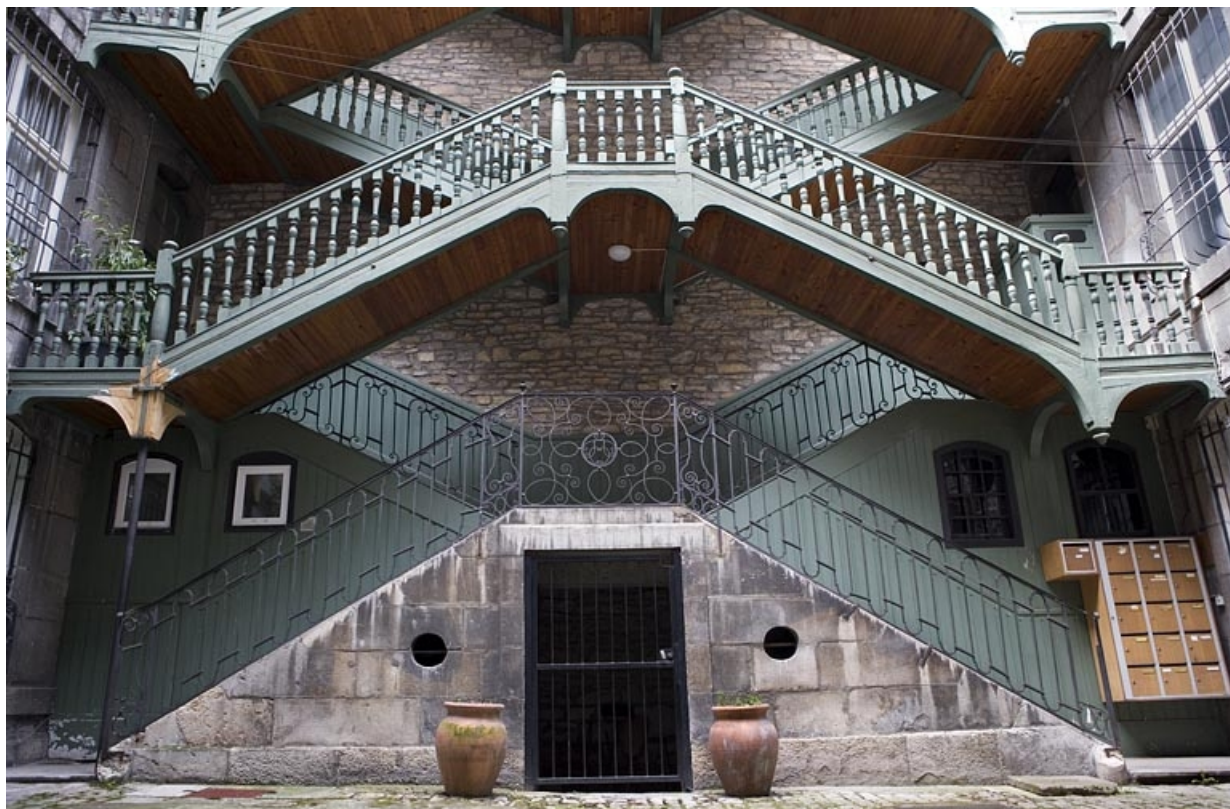
Escalier à cage ouverte à droite de la première cour : vue d'ensemble, de face, des premières volées en maçonnerie. 25, Besançon, 72 rue des Granges, lieudit : îlot Forum
