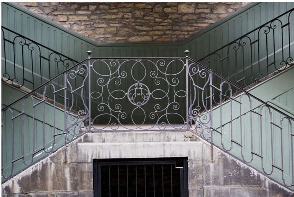
Escalier à cage ouverte à droite de la première cour : détail de la grille en ferronnerie.
