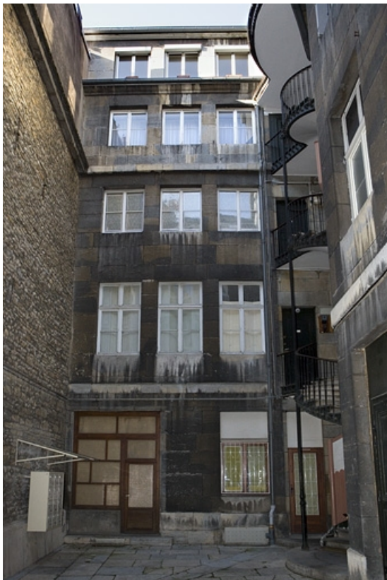
Vue d'ensemble de la façade antérieure du logis secondaire.
