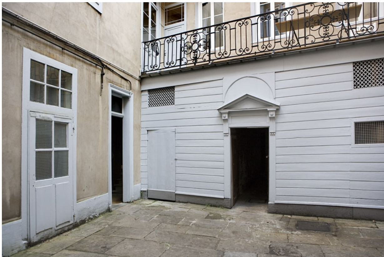
Vue du rez-de-chaussée des bâtiments au fond de la première cour : de trois quarts gauche.
