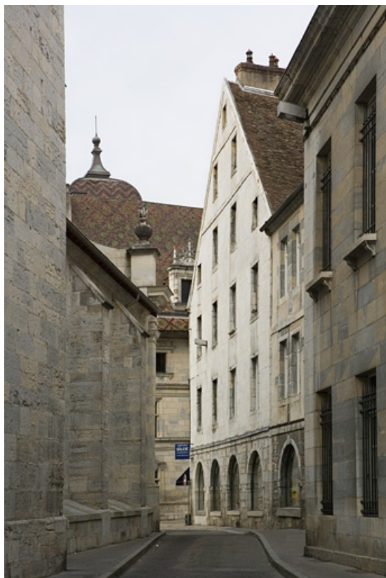
Vue d'ensemble de la façade sur pignon du logis principal depuis la rue de la Bibliothèque. 25, Besançon Grande Rue 119, lieudit : îlot Forum
