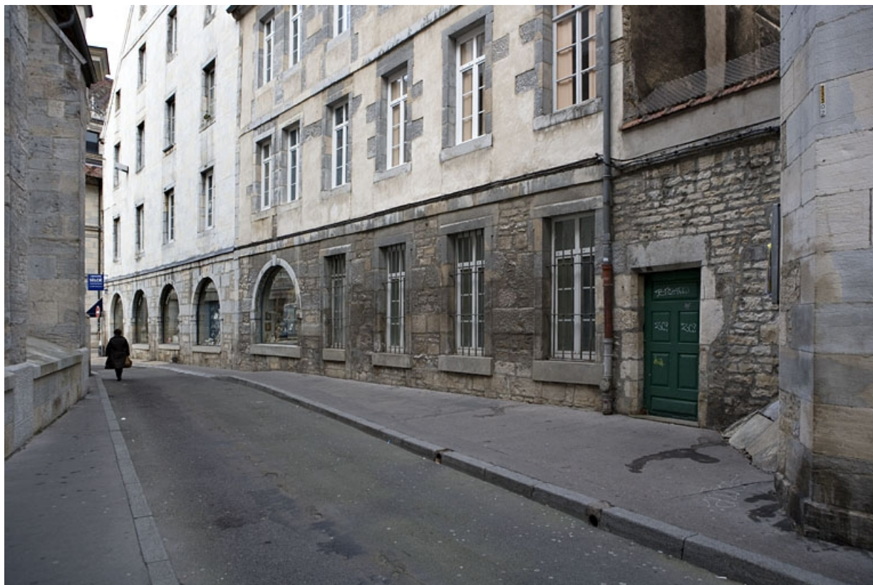
Détail des rez-de-chaussée de la façade latérale du logis principal et du logis secondaire depuis la rue de la Bibliothèque. 25, Besançon Grande Rue 119, lieudit : îlot Forum
