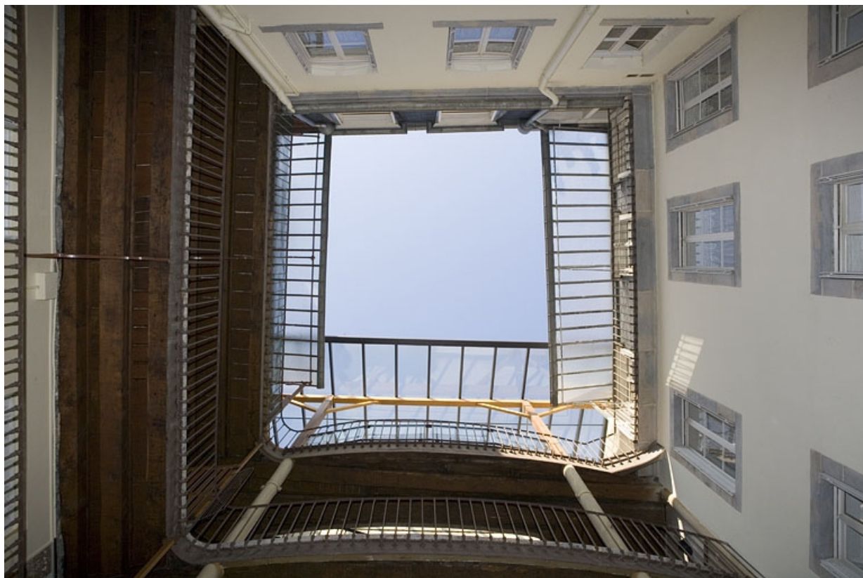
Première cour : vue en contre-plongée de l'escalier à cage ouverte.
