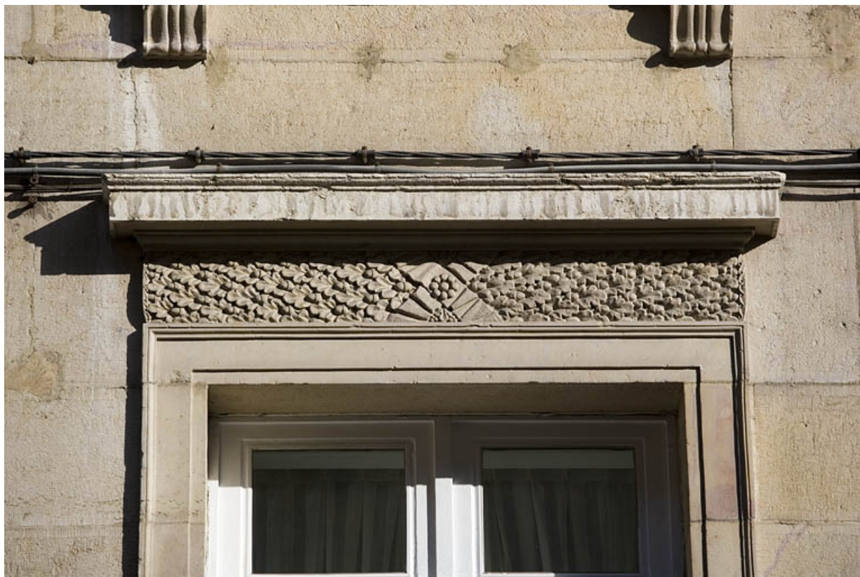
Détail d'un décor sculpté au-dessus d'une fenêtre du premier étage.
