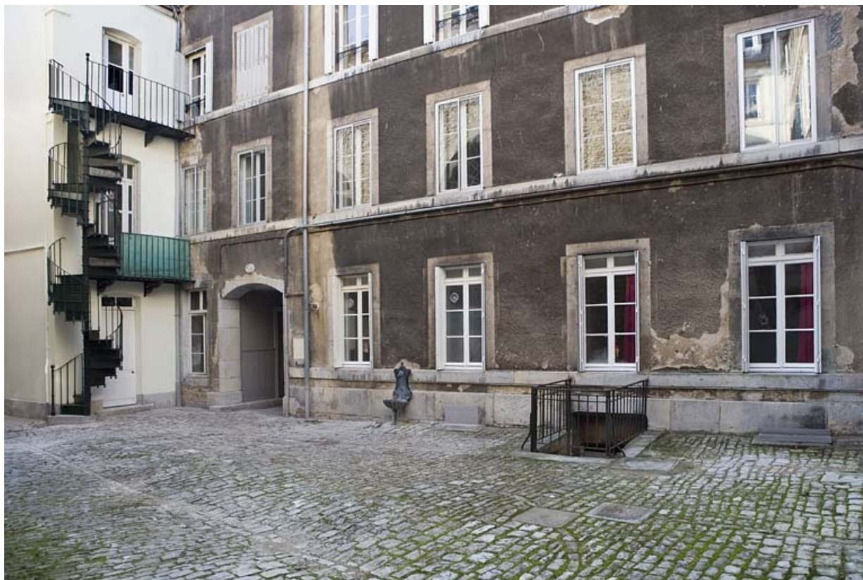
Deuxième cour : vue de la façade postérieure du logis secondaire, de trois quarts droit.
