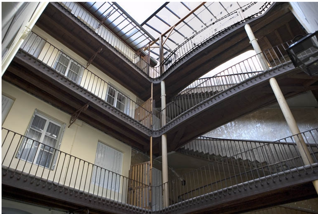
Première cour : vue de l'escalier à cage ouverte et des coursières sur la façade postérieure du logis principal.
