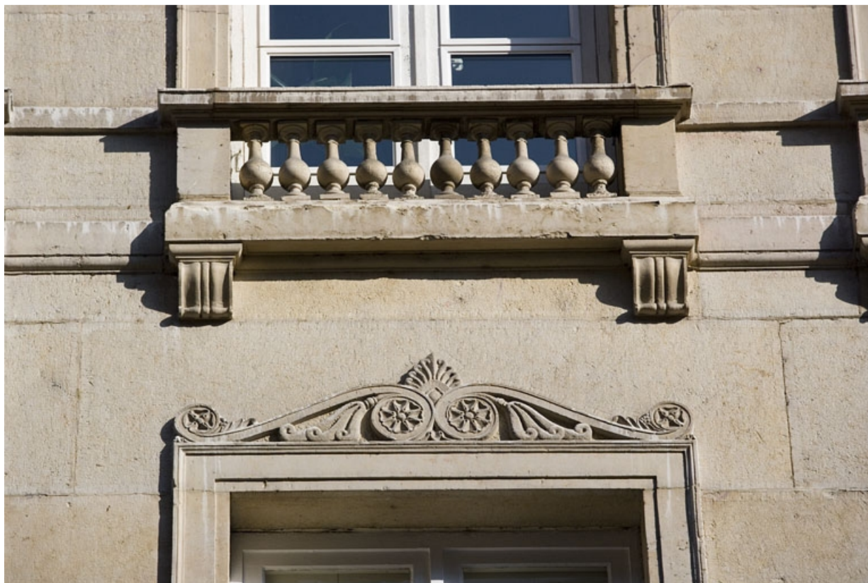
Détail d'un garde-corps d'une fenêtre du troisième étage.
