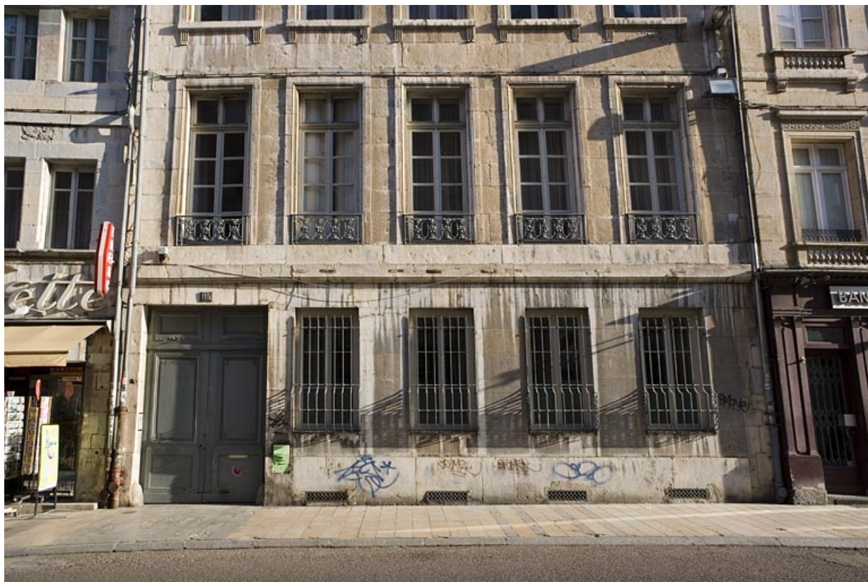
Logis principal sur rue : détail du rez-de-chaussée et du premier étage.
