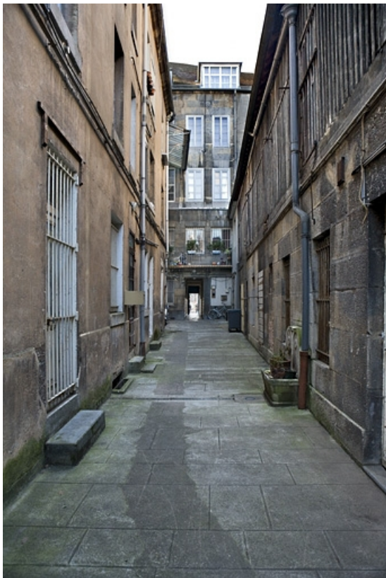
Vue d'ensemble des logis secondaires de la première cour, depuis le fond de cette cour. 25, Besançon Grande Rue 109, lieudit : îlot Forum
