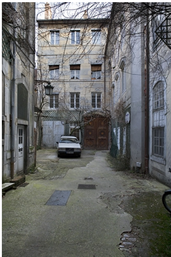
Vue d'ensemble des logis secondaires au fond de la deuxième cour.
