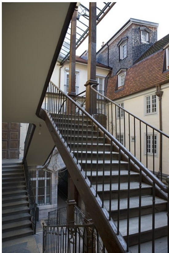
Détail de l'escalier à cage ouverte depuis l'intérieur de la cage.
