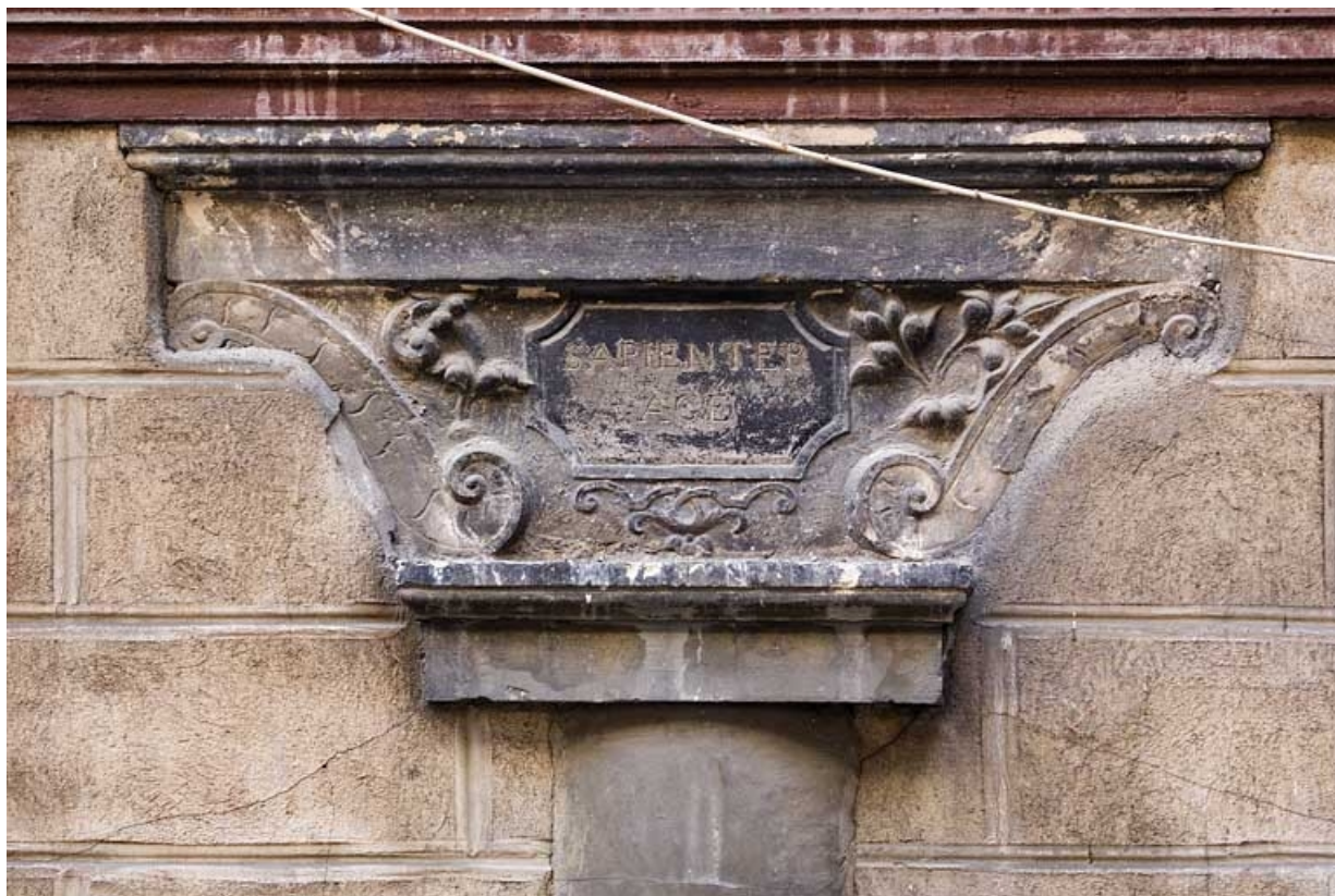
Détail du chapiteau du portique portant l'inscription latine "agis sagement". 25, Besançon Grande Rue 91, lieudit : îlot Forum
