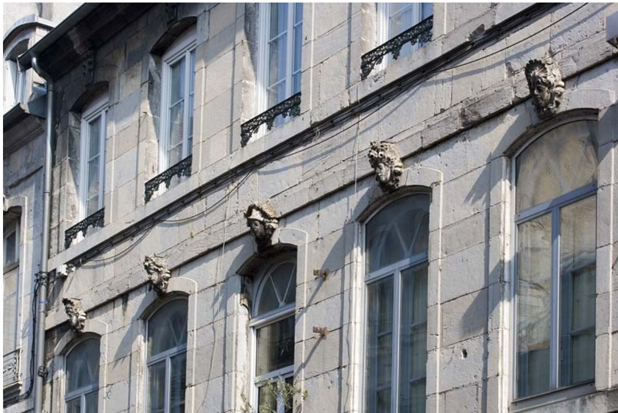
Détail des fenêtres au premier étage sur rue. 25, Besançon Grande Rue 91, lieudit : îlot Forum
