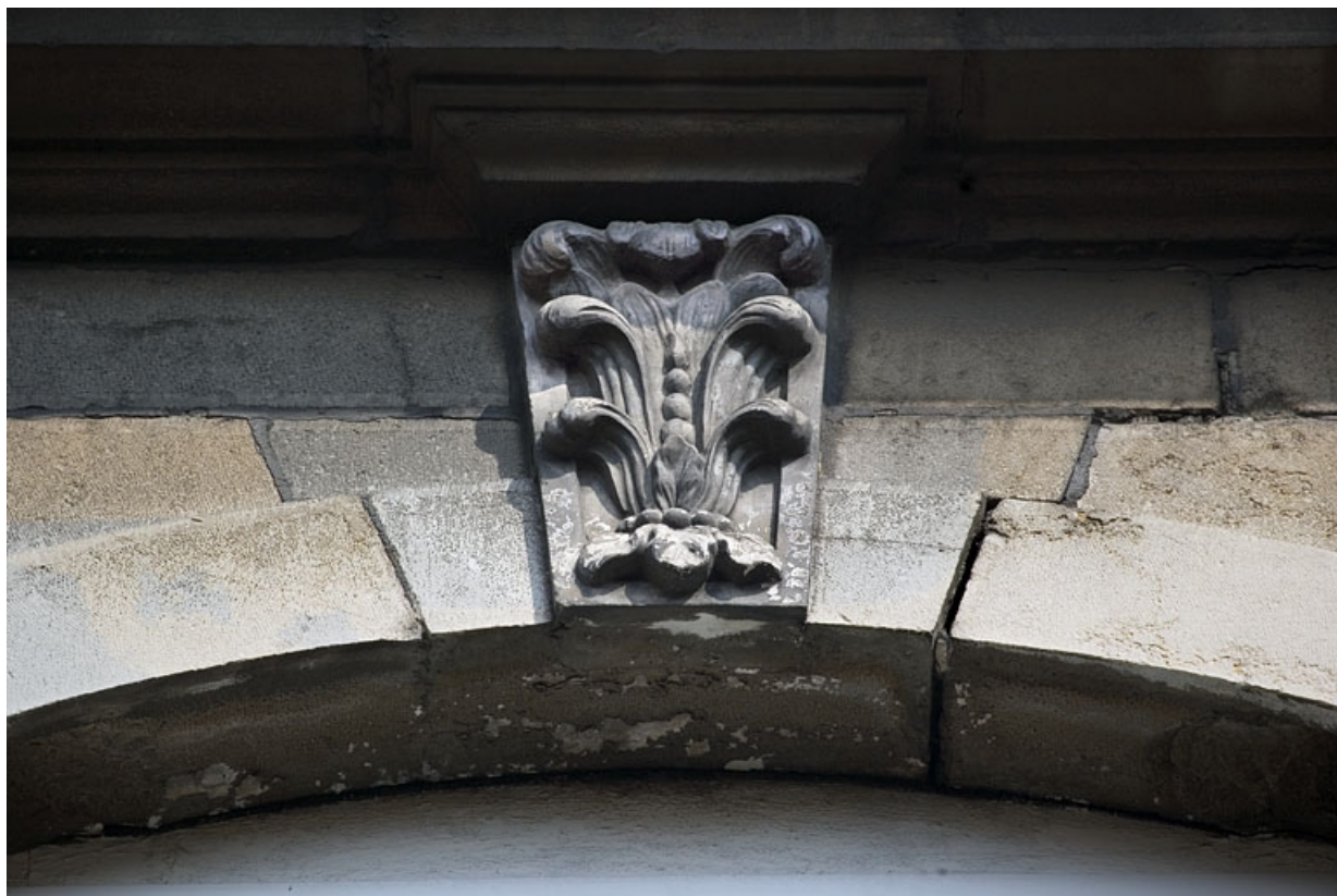
Détail d'une clé sur une fenêtre du deuxième étage sur rue.
