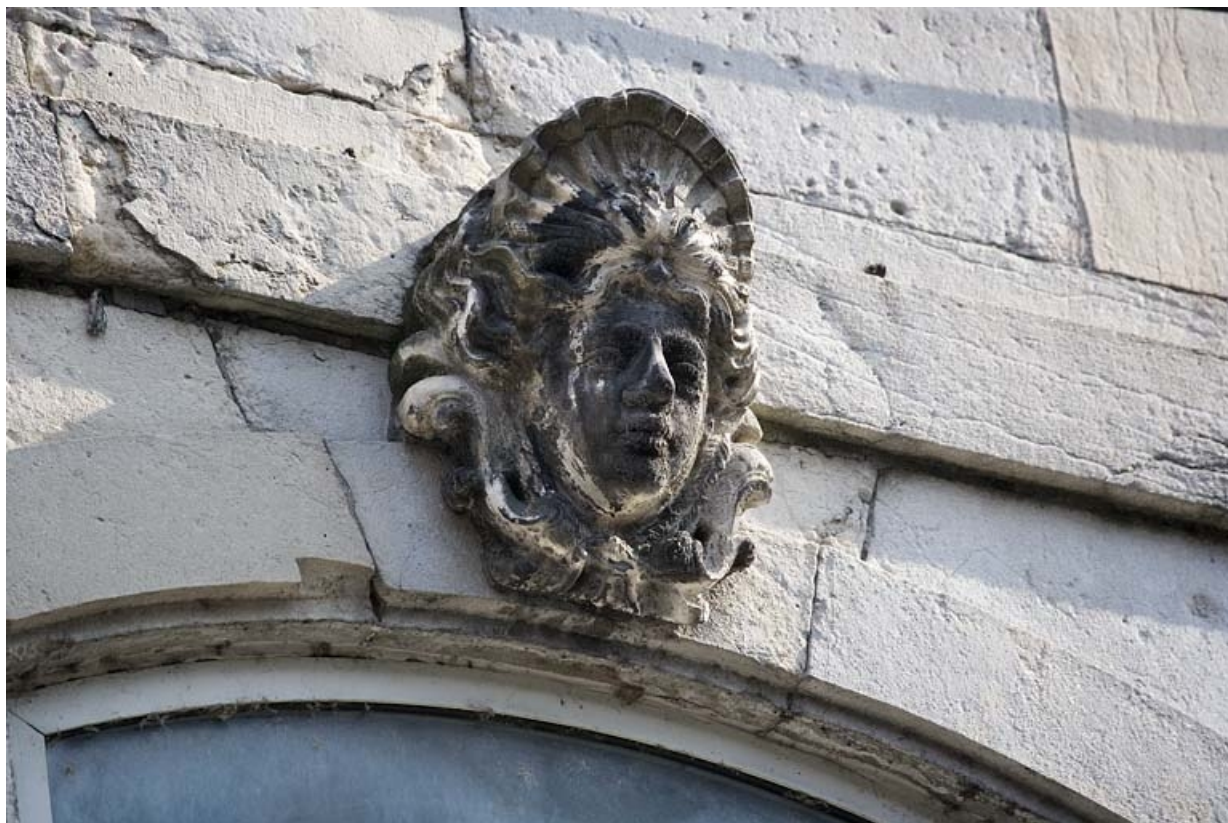
Détail de la clé d'une fenêtre au premier étage sur rue : figure coiffée d'une coquille.
