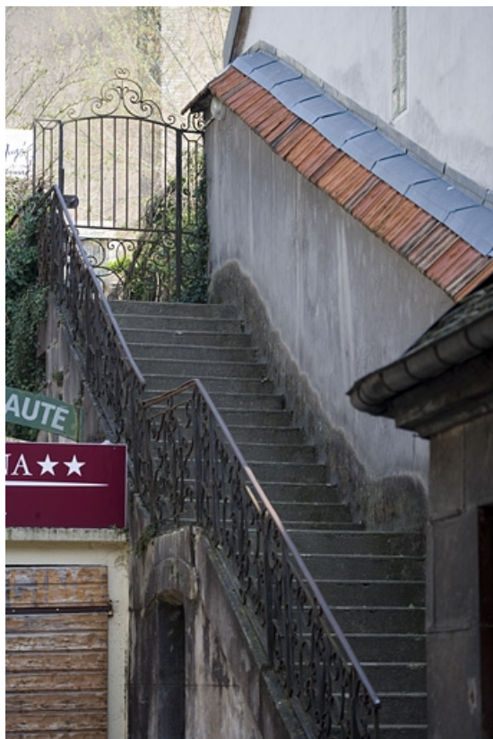
Vue de l'escalier isolé dans la deuxième cour conduisant à la terrasse gallo-romaine.
