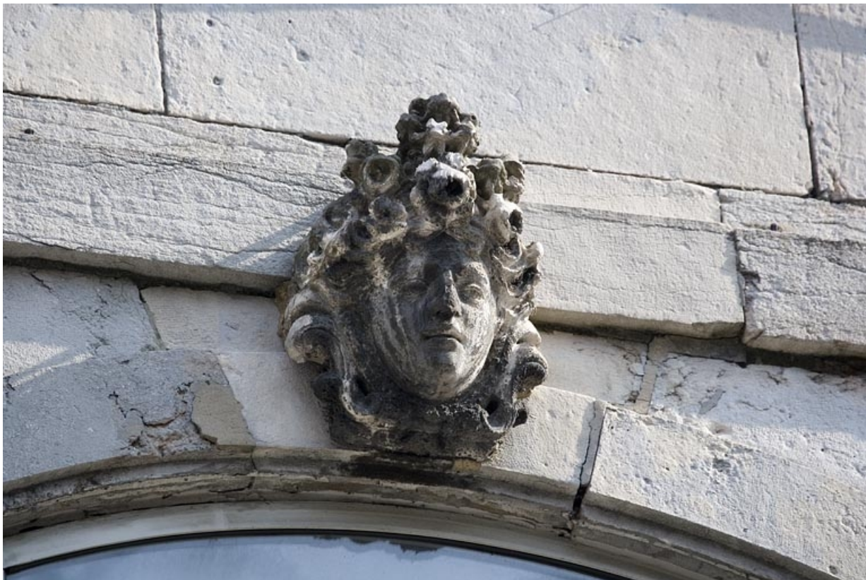
Détail de la clé d'une fenêtre au premier étage sur rue : figure coiffée d'un amas de fleurs.
