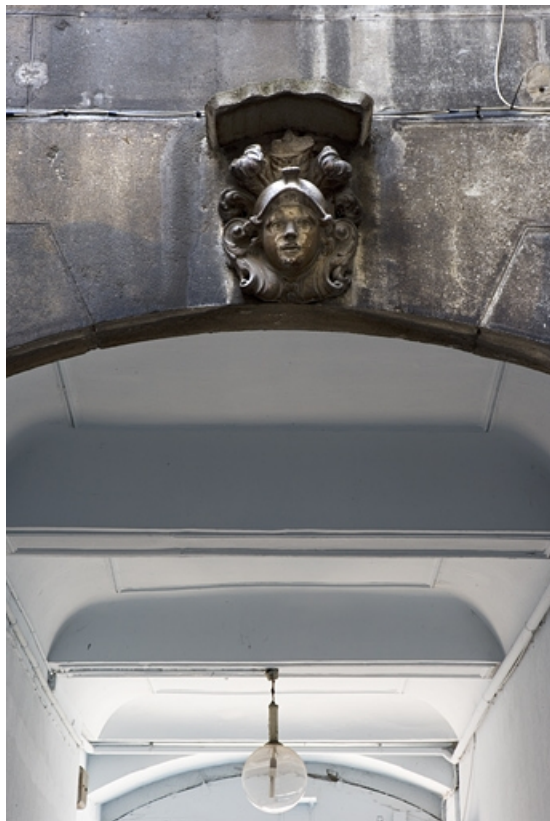
Première cour : détail du plafond du passage cocher avec une figure casquée sur la clé d'un arc. 25, Besançon Grande Rue 91, lieudit : îlot Forum
