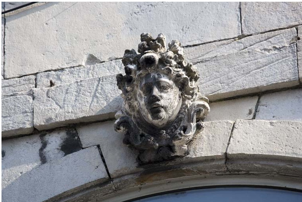
Détail de la clé d'une fenêtre au premier étage sur rue : figure coiffée d'une couronne de fleur. 25, Besançon Grande Rue 91, lieudit : îlot Forum
