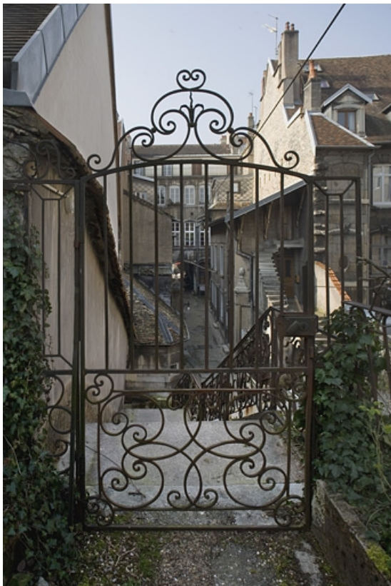
Détail de la grille de la porte de l'escalier isolé. 25, Besançon Grande Rue 91, lieudit : îlot Forum
