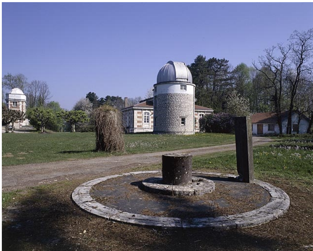
Partie nord : vue d'ensemble vers le bâtiment de l'astrographe, depuis l'entrée au sud. 25, Besançon, 34, 36, 41 à 43 avenue de l' Observatoire, lieudit : la Bouloie
