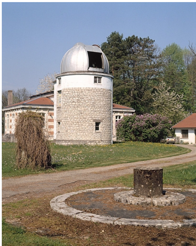
Tour avec la trappe du dôme ouverte, depuis le sud-ouest. 25, Besançon, 34 avenue de l' Observatoire, lieudit : la Bouloie
