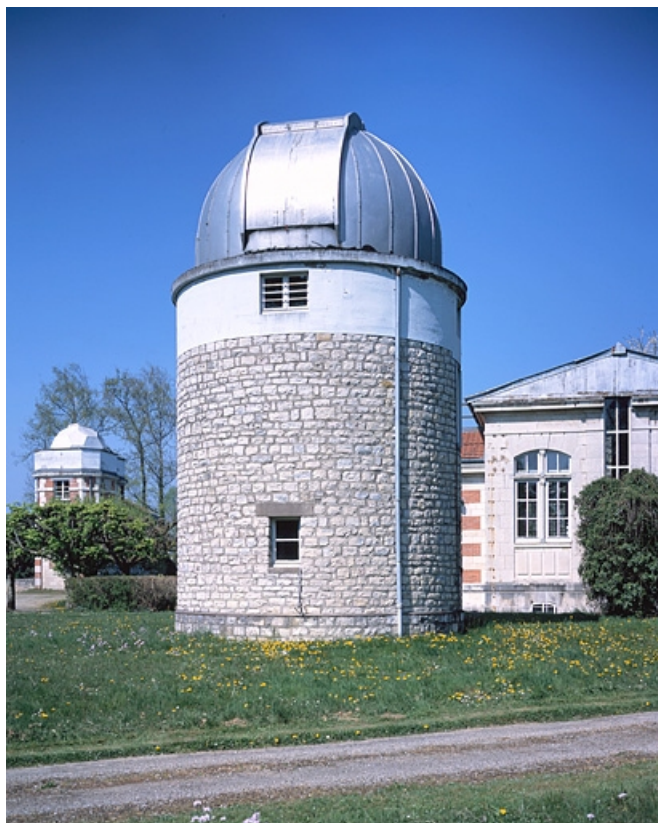
Tour avec la trappe du dôme fermée, depuis le sud-est.
