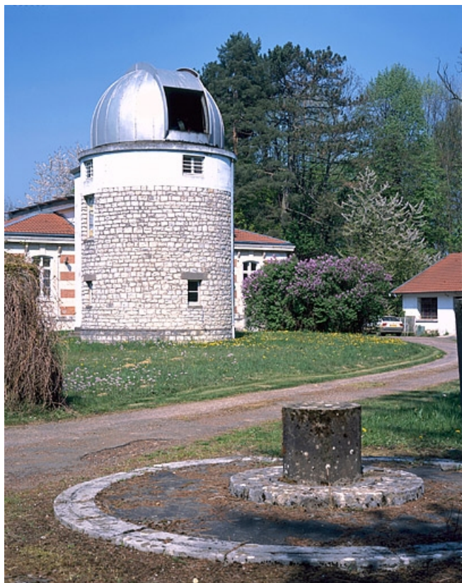
Tour avec la trappe du dôme ouverte, depuis le sud-ouest. 25, Besançon, 34 avenue de l' Observatoire, lieudit : la Bouloie
