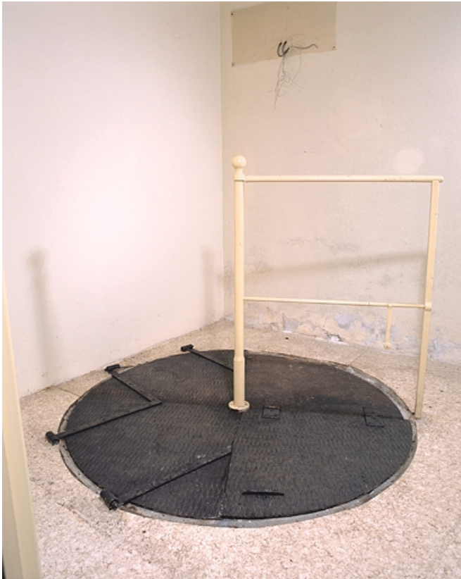
Sous-sol, salle ouest : puits des pendules à pression constante, trappe fermée. 25, Besançon, 34 avenue de l' Observatoire, lieudit : la Bouloie
