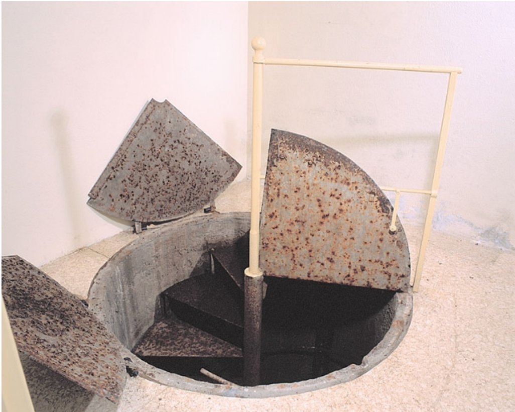
Sous-sol, salle ouest : puits des pendules à pression constante, trappe ouverte. 25, Besançon, 34 avenue de l' Observatoire, lieudit : la Bouloie
