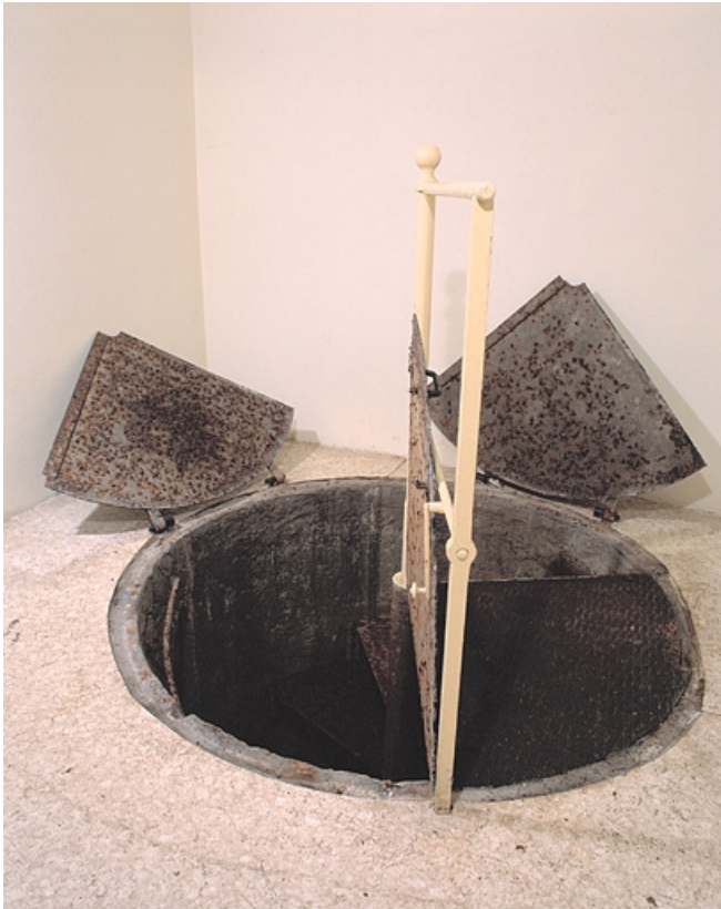
Sous-sol, salle ouest : puits des pendules à pression constante, trappe partiellement ouverte. 25, Besançon, 34 avenue de l' Observatoire, lieudit : la Bouloie
