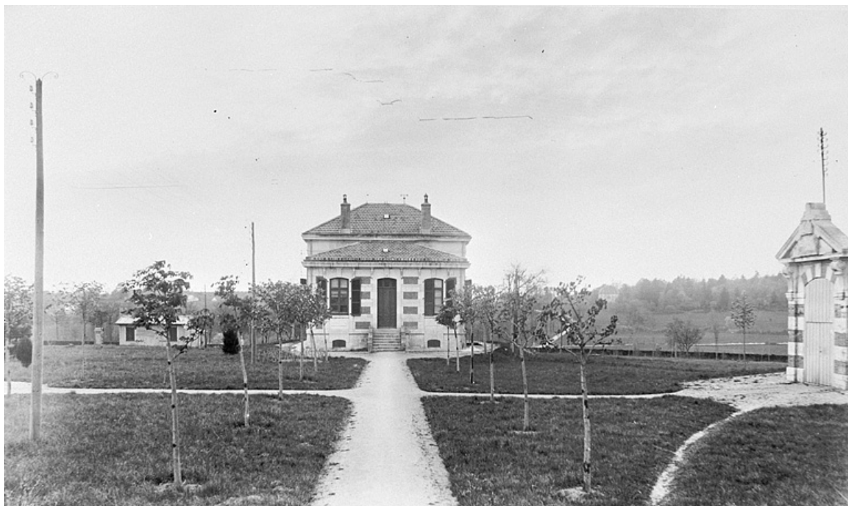
[Vue d'ensemble de la façade est], limite 19e siècle 20e siècle.
