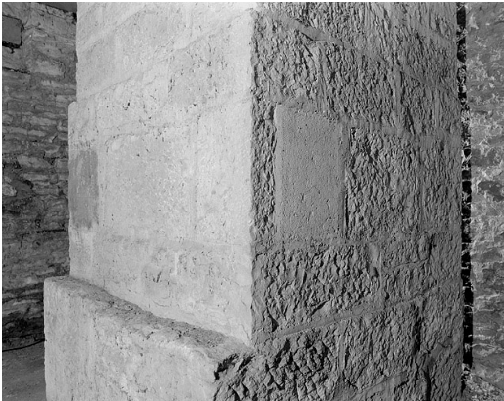
Sous-sol de la tour de l'équatorial coudé : ressauts du pilier.
