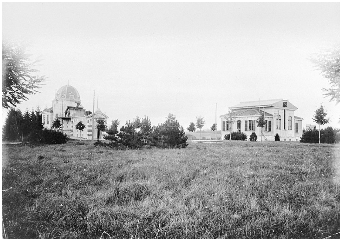
[Vue d'ensemble des pavillons du coudé et de la méridienne, depuis le sud-ouest], 1er quart 20e siècle. 25, Besançon, 34 avenue de l' Observatoire, lieudit : la Bouloie
