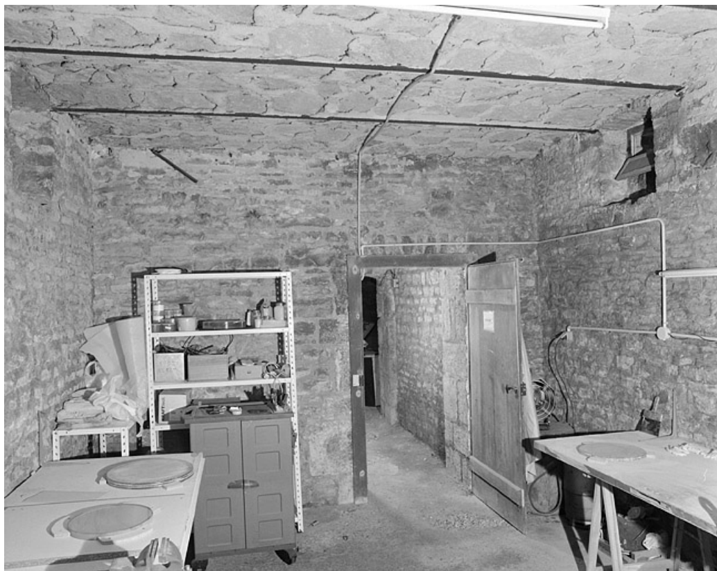
Sous-sol de l'ancien atelier de mécanique et d'horlogerie.
