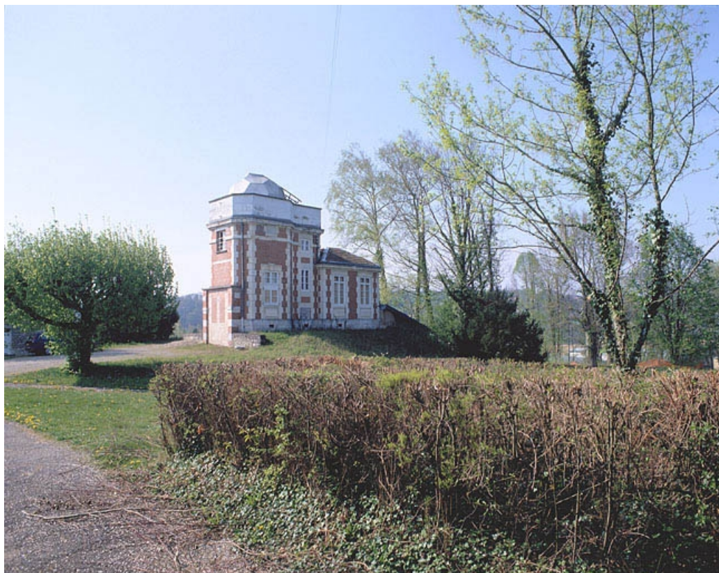
Vue d'ensemble depuis le pavillon de la méridienne, au sud-est.
