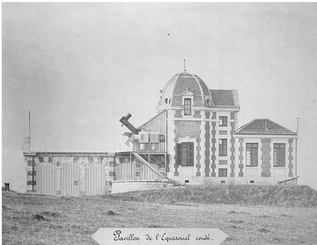
Pavillon de l'équatorial coudé [vu de l'est], fin 19e siècle. 25, Besançon, 34 avenue de l' Observatoire, lieudit : la Bouloie
