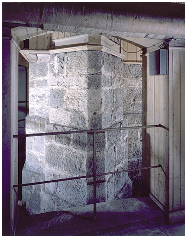
Sous-sol : pilier de la lunette méridienne et de sa pendule. 25, Besançon, 34 avenue de l' Observatoire, lieudit : la Bouloie
