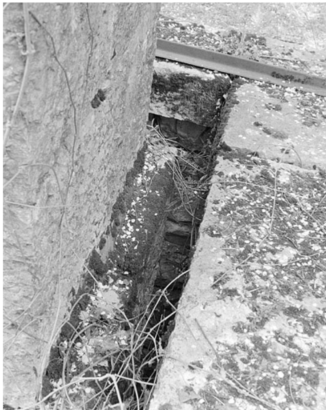
Pilier sud des mires nord de la lunette méridienne : espace entre le pilier et son puits.
