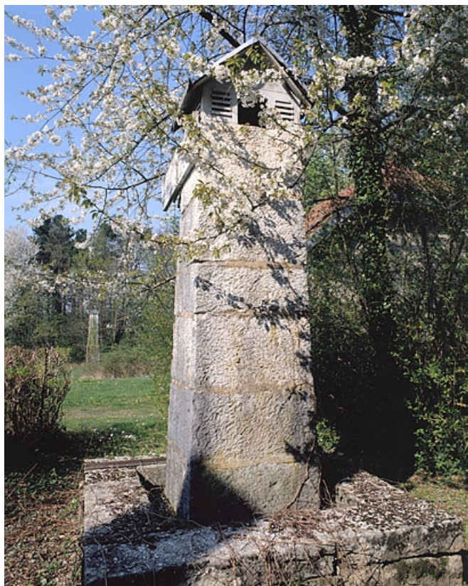
Piliers des mires nord de la lunette méridienne. Pilier sud au premier plan, nord au second. 25, Besançon, 34 avenue de l' Observatoire, lieudit : la Bouloie
