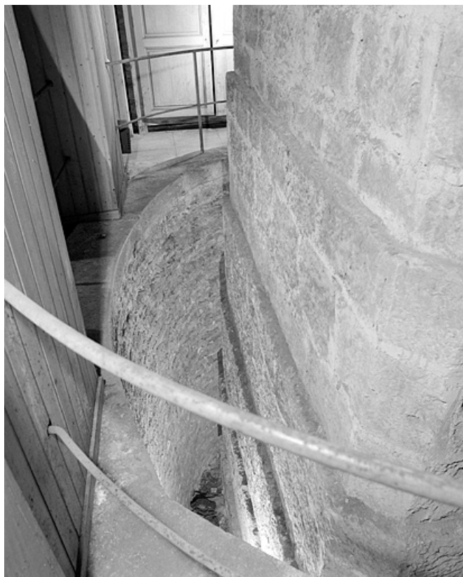
Sous-sol : puits du pilier de la lunette méridienne.
