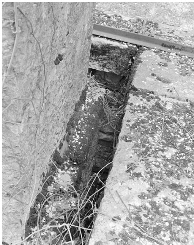
Pilier sud des mires nord de la lunette méridienne : espace entre le pilier et son puits.
