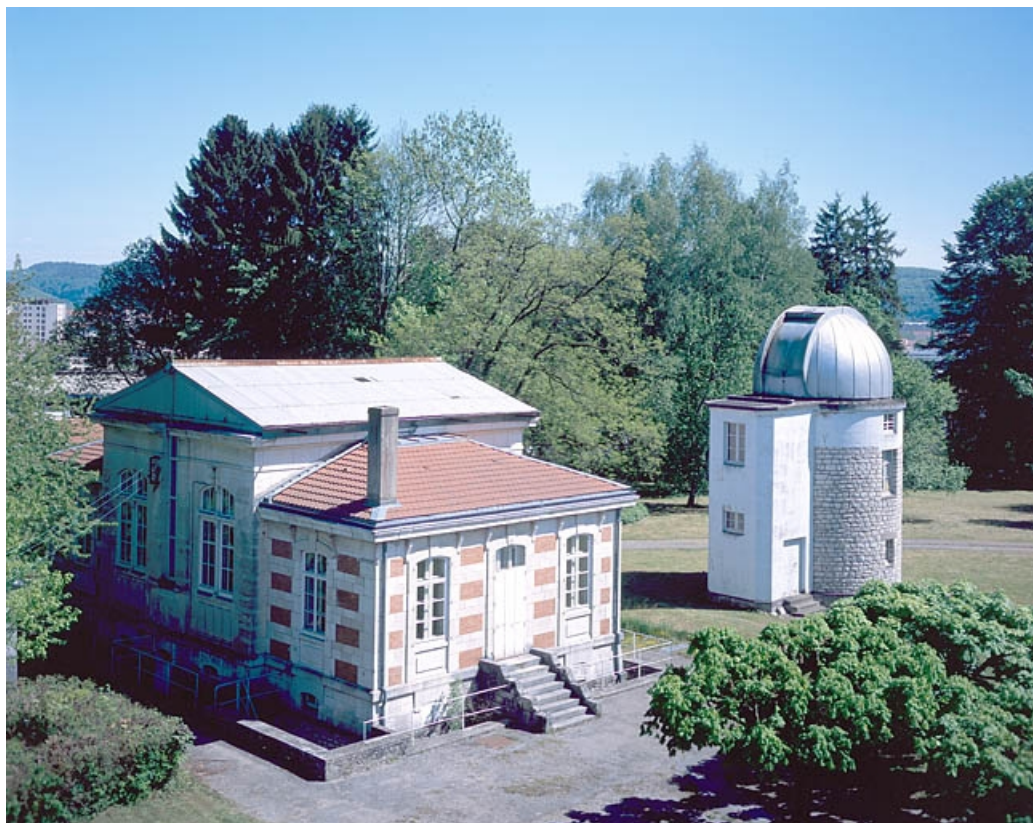
Vue d'ensemble plongeante depuis le pavillon de l'équatorial coudé, au nord-ouest. 25, Besançon
