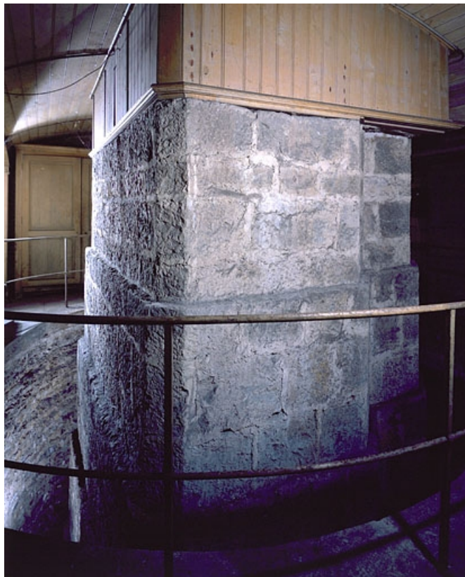
Sous-sol : pilier de la lunette méridienne (cadrage vertical). 25, Besançon, 34 avenue de l' Observatoire, lieudit : la Bouloie
