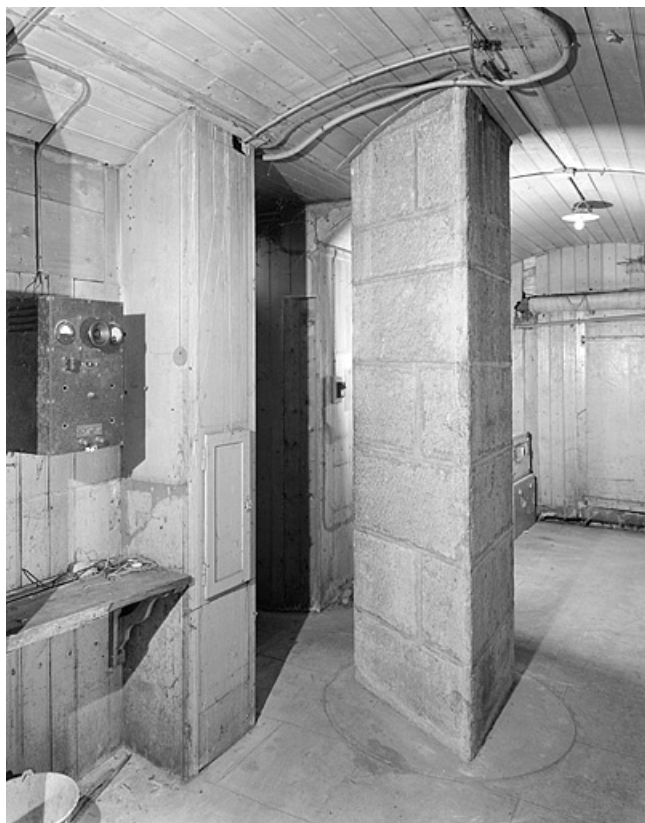
Sous-sol : pilier du collimateur nord et porte d'entrée.
