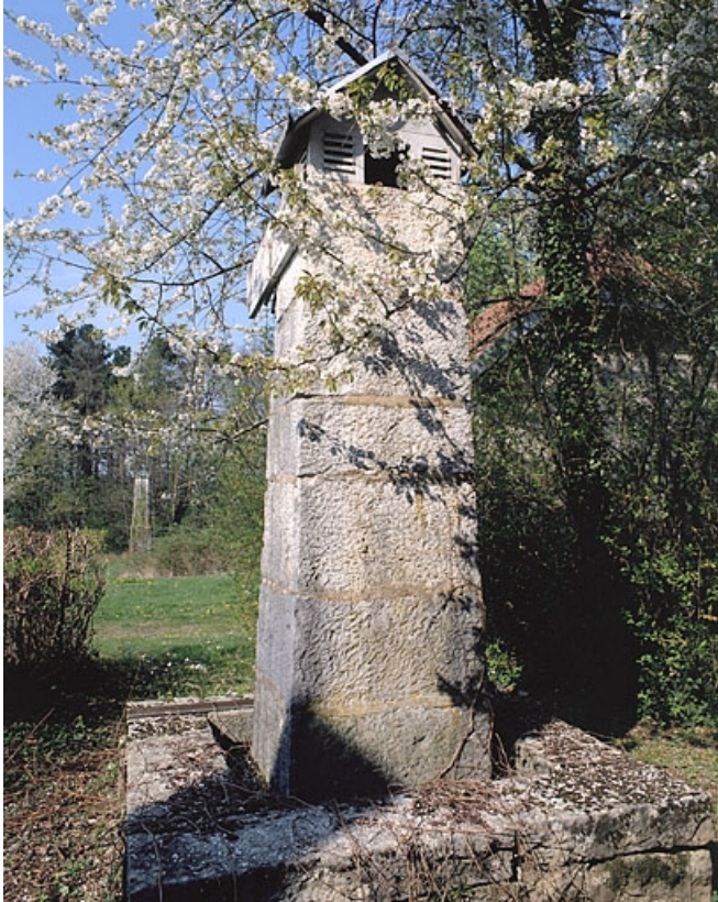
Piliers des mires nord de la lunette méridienne. Pilier sud au premier plan, nord au second. 25, Besançon, 34 avenue de l' Observatoire, lieudit : la Bouloie
