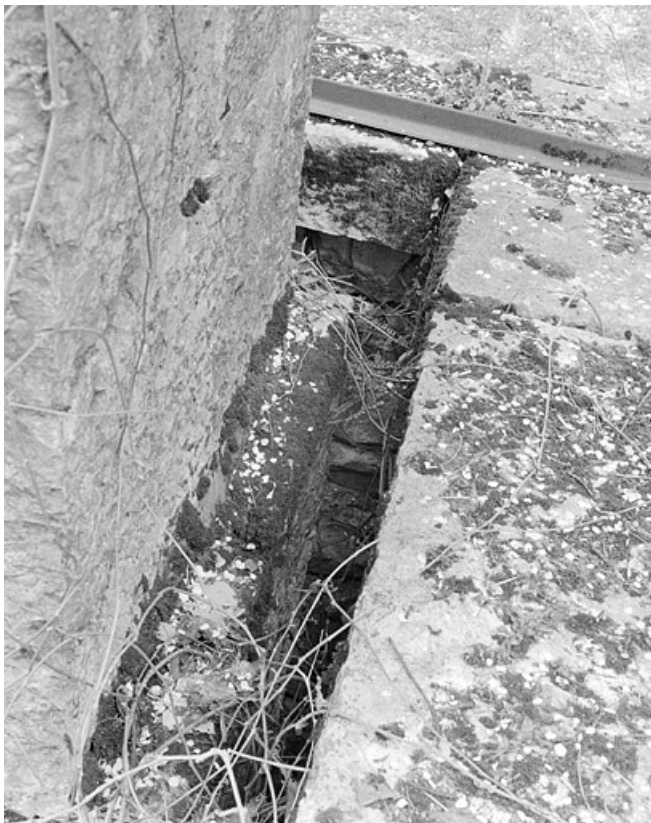
Pilier sud des mires nord de la lunette méridienne : espace entre le pilier et son puits. 25, Besançon, 34 avenue de l' Observatoire, lieudit : la Bouloie
