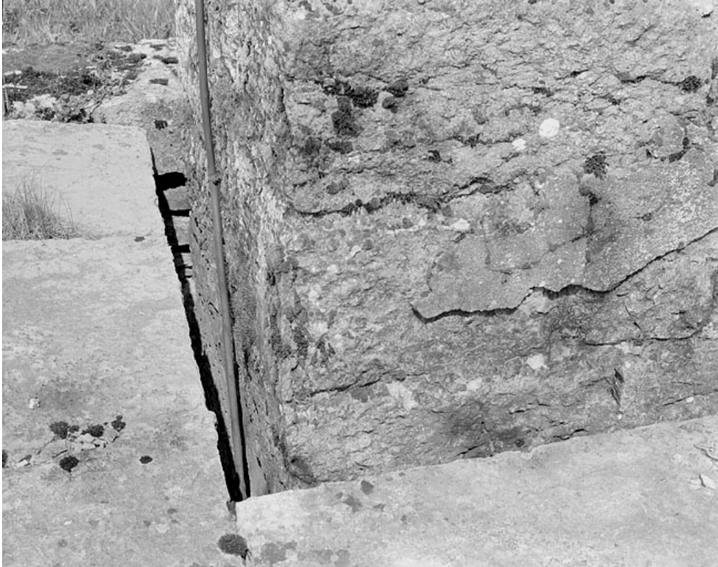
Pilier sud des mires sud de la lunette méridienne : espace entre le pilier et son puits.
