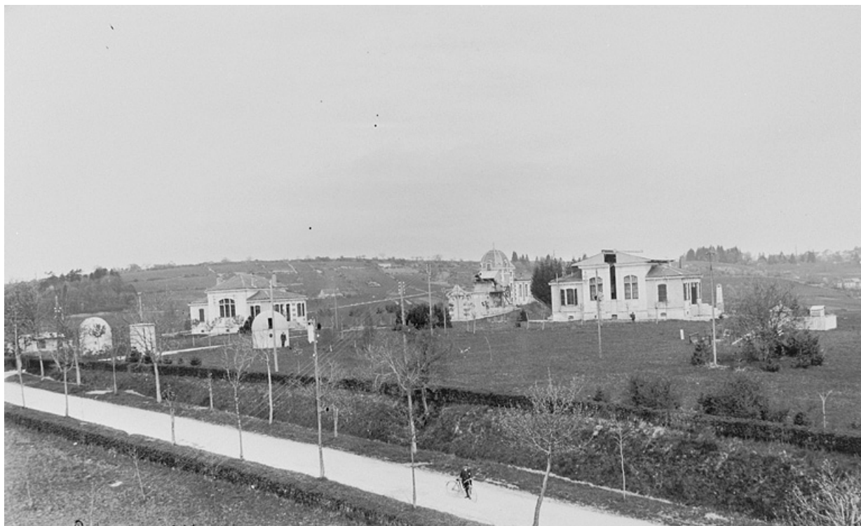
[Vue d'ensemble des pavillons, depuis le sud-est], 1911.
