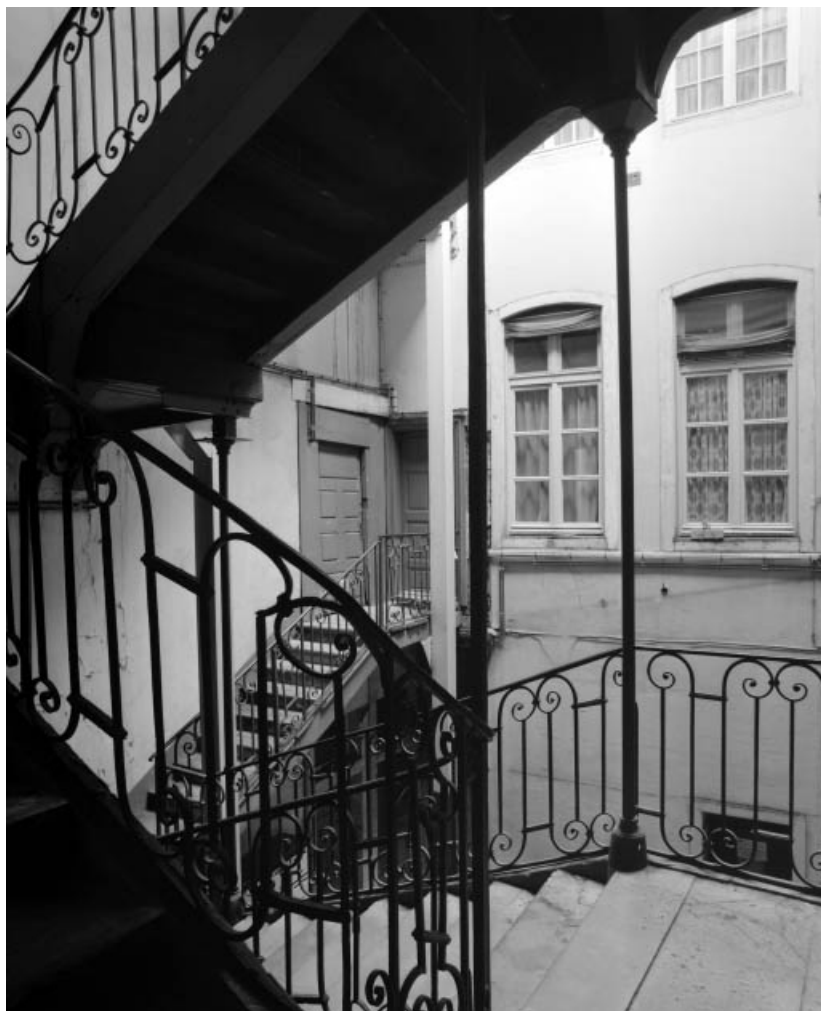
Vue du logis sur cour depuis l'escalier à cage ouverte.
