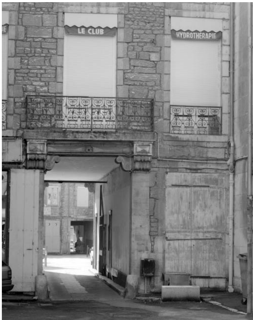
Façade antérieure du corps de logis sur cour : détail de l'entrée cochère. 25, Besançon Grande Rue 14, lieudit : îlot Pasteur
