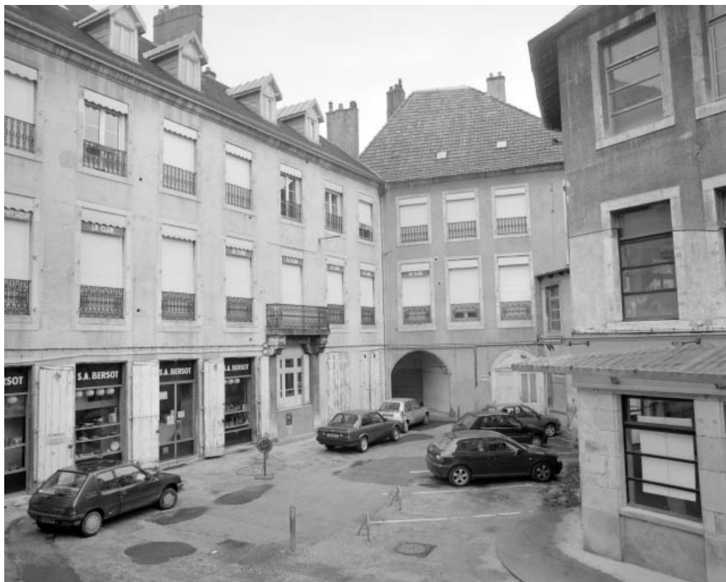
Façade postérieure du corps de logis sur cour, de trois quarts droit.
