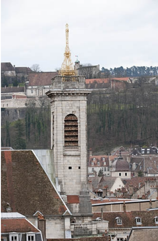
Vue du clocher de l'église Saint-Pierre et de la Citadelle depuis la grande roue installée, fin 2010, sur la place de la Révolution. 25, Besançon
