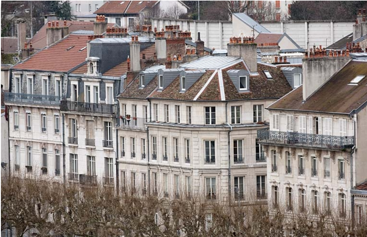
Détail des façades des immeuble sur le quai de Strasbourg depuis la grande roue installée, fin 2010, sur la place de la Révolution. 25, Besançon
