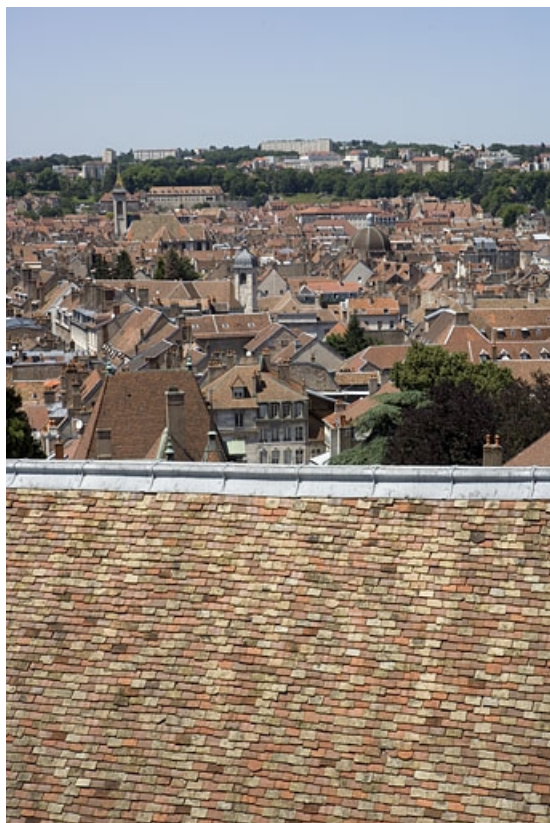
Vue d'ensemble des toits de la ville depuis celui de la cathédrale Saint-Jean . 25, Besançon
