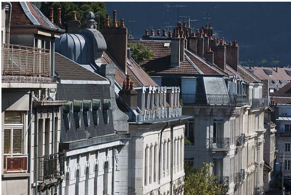
Vue des toits d'une partie de la rue Proudhon depuis le haut d'un immeuble. 25, Besançon
