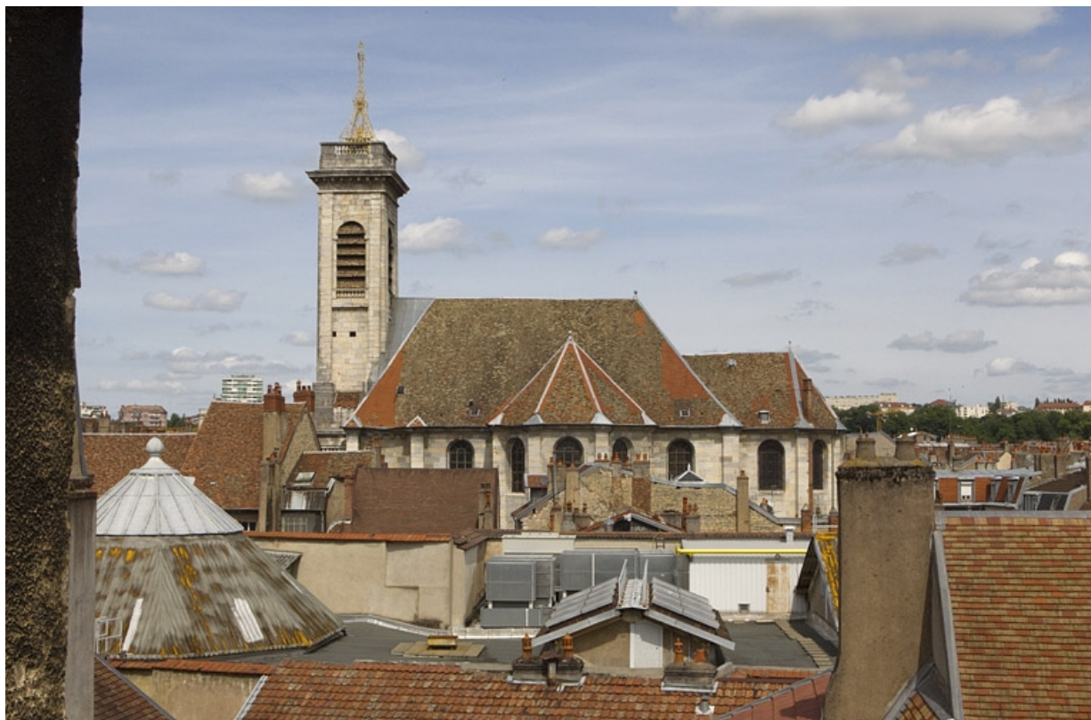
Vue de la façade latérale droite de l'église Saint-Pierre et des toits depuis un immeuble de la rue Moncey, 25, Besançon
