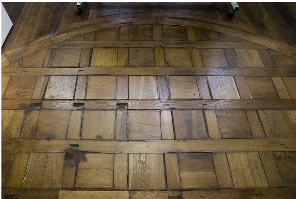
Détail du parquet d'une pièce située au premier étage, de face.
