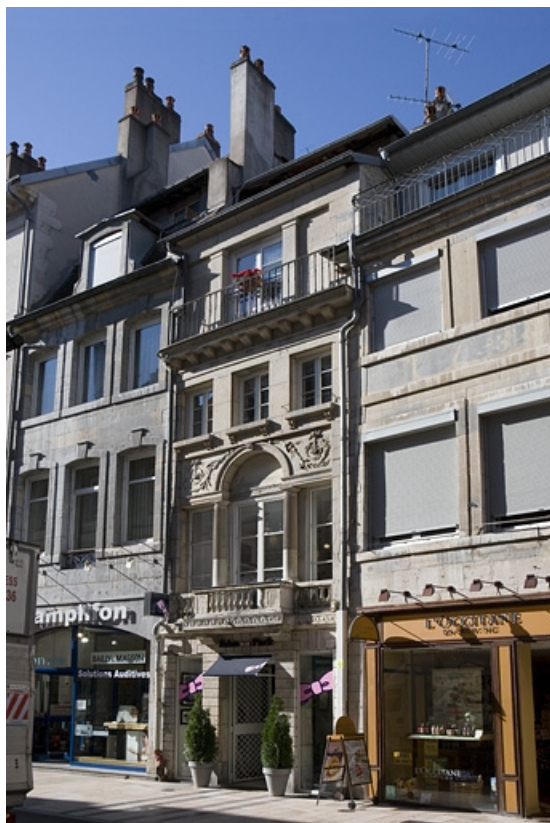
Vue d'ensemble de la façade sur rue de trois quarts droit. 25, Besançon Grande Rue 80, lieudit : îlot Terrier de Santans
