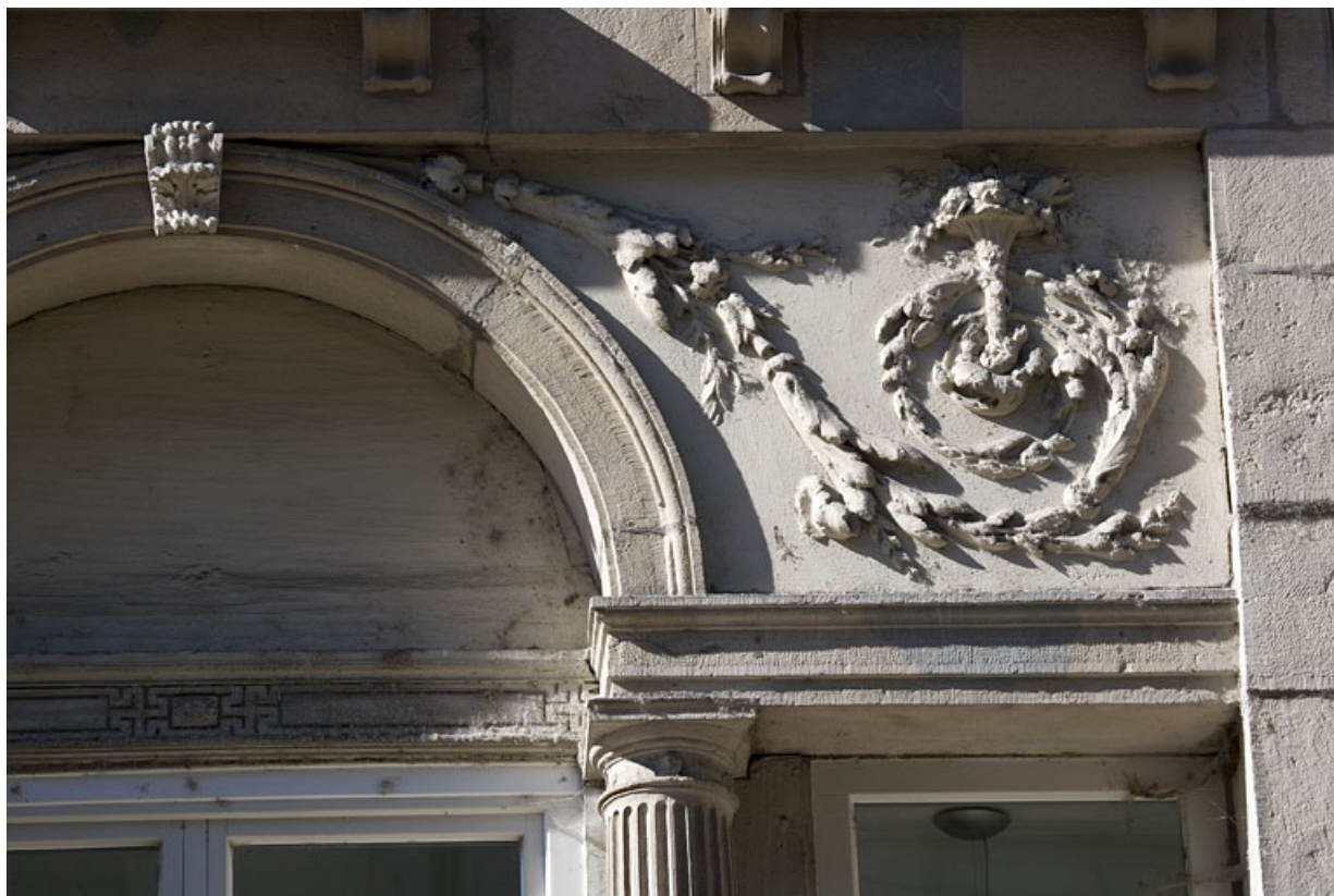
Détail d'un rinceau de feuillage encadrant l'arc de la serlienne.
