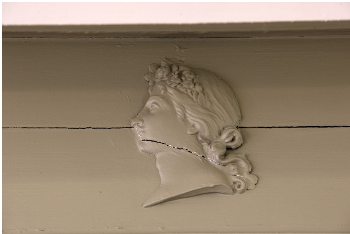
Détail d'une tête de femme de profil ornant les lambris d'une pièce située au premier étage.
