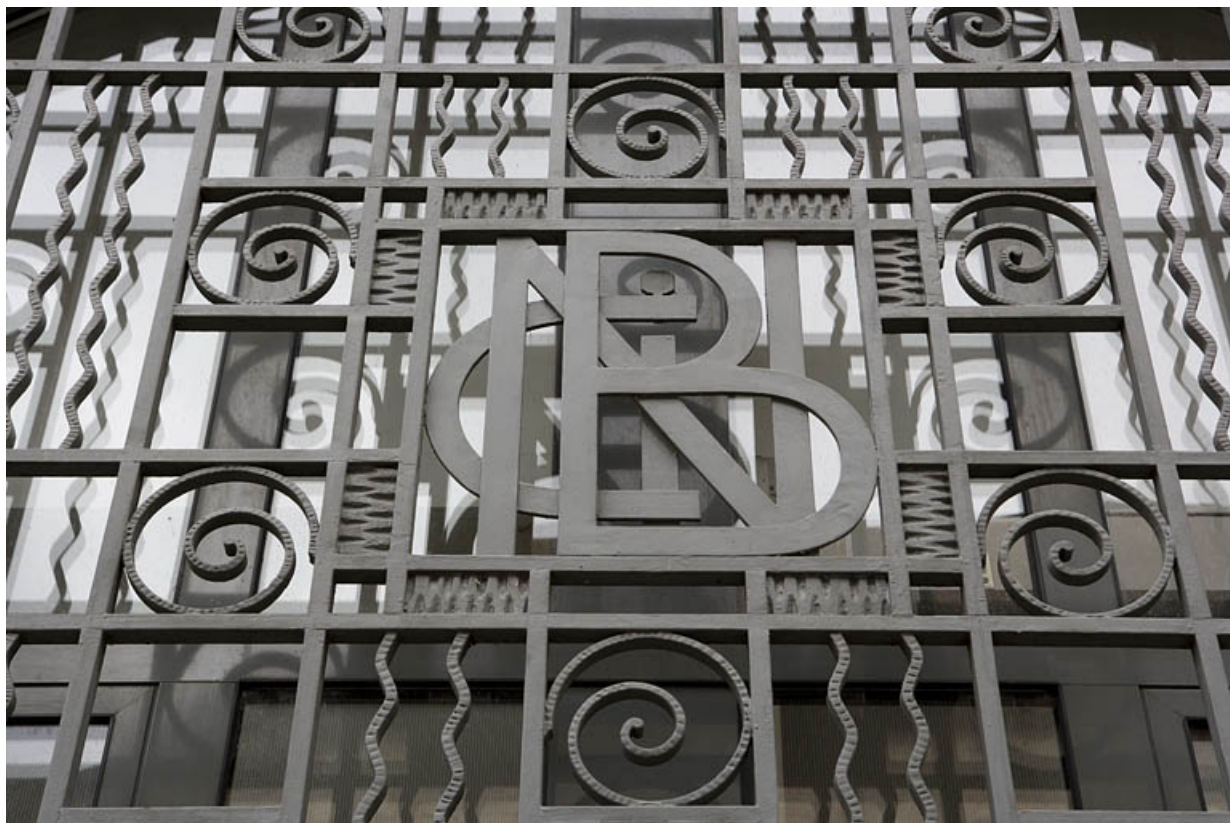
Détail de la ferronnerie d'une fenêtre du rez-de-chaussée.
