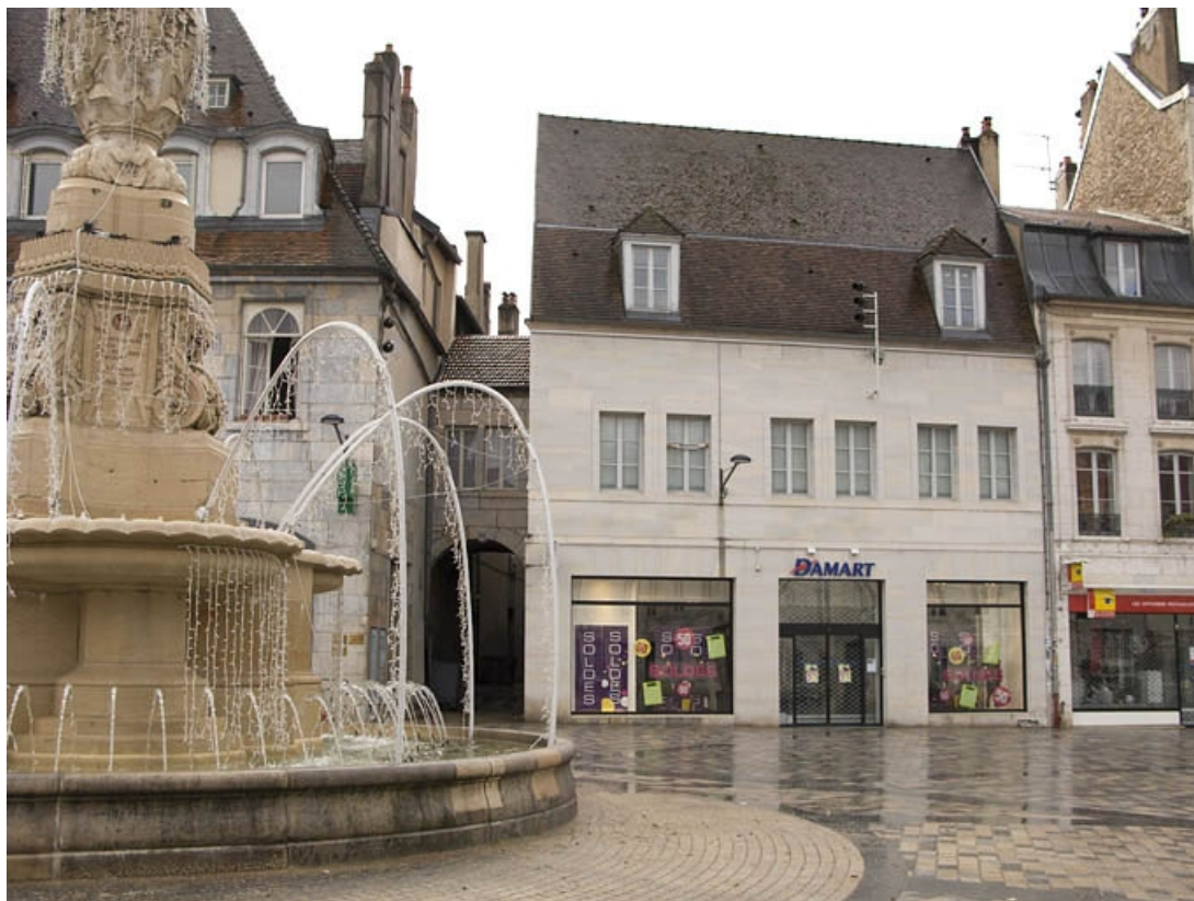
Vue d'ensemble des façades des logis secondaires de l'ancien hôtel, depuis la place de la Révolution. 25, Besançon Grande Rue 13, 15, lieudit : îlot Chevanney
