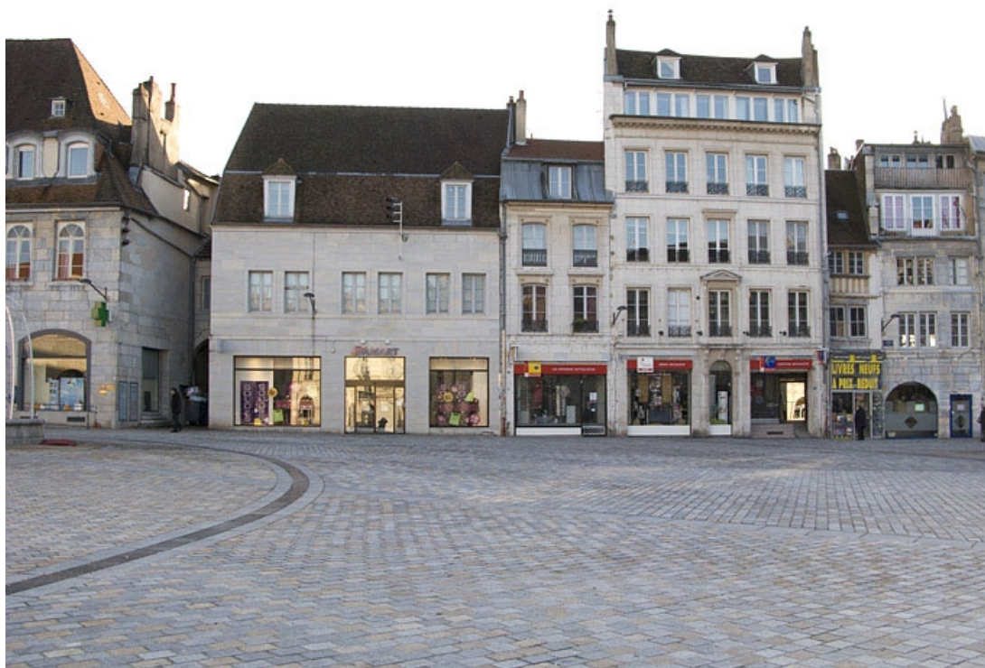
Vue d'ensemble éloignée des façades des logis secondaires de l'ancien hôtel, depuis la place de la Révolution. 25, Besançon Grande Rue 13, 15, lieudit : îlot Chevanney
