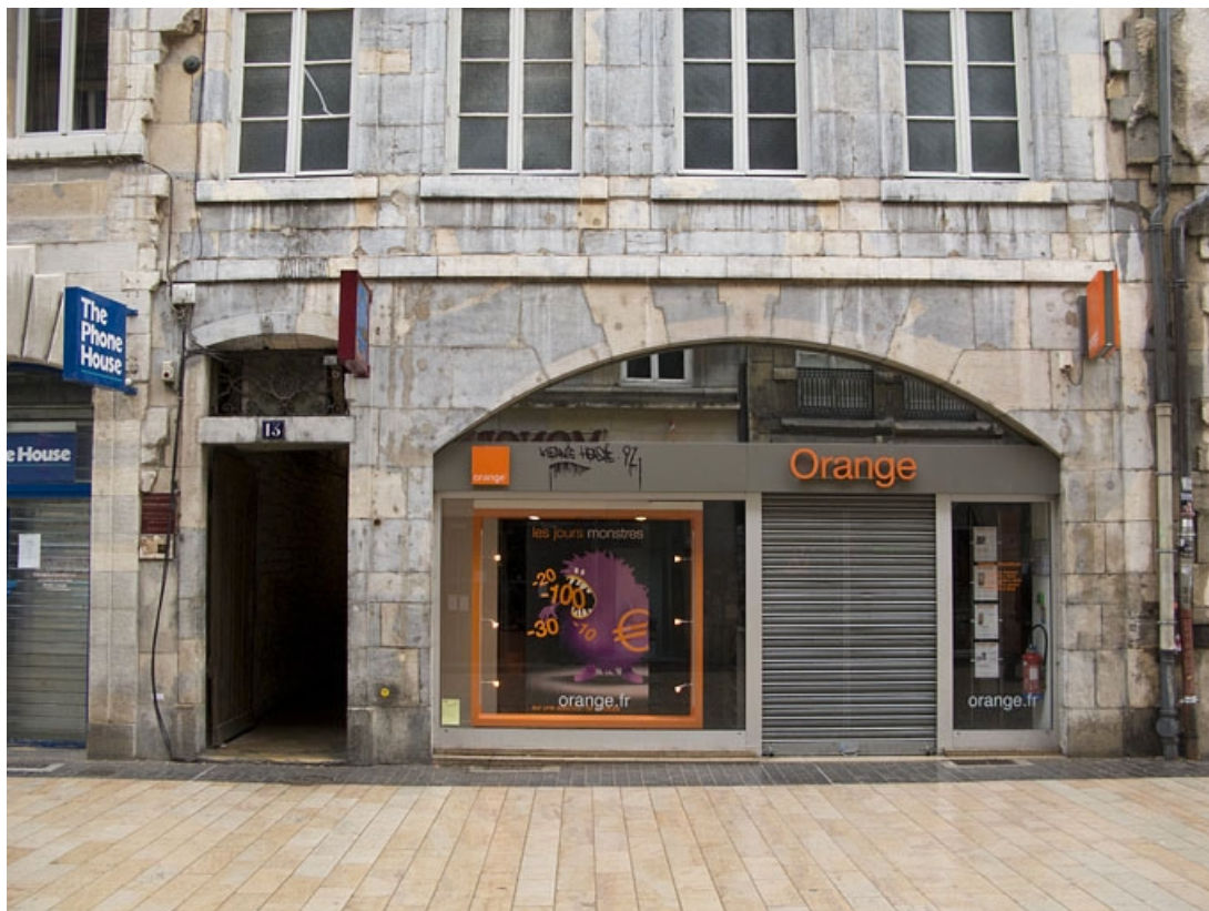
Détail du rez-de-chaussée de la façade antérieure du 13 Grande Rue : de face. 25, Besançon Grande Rue 13, 15, lieudit : îlot Chevanney
