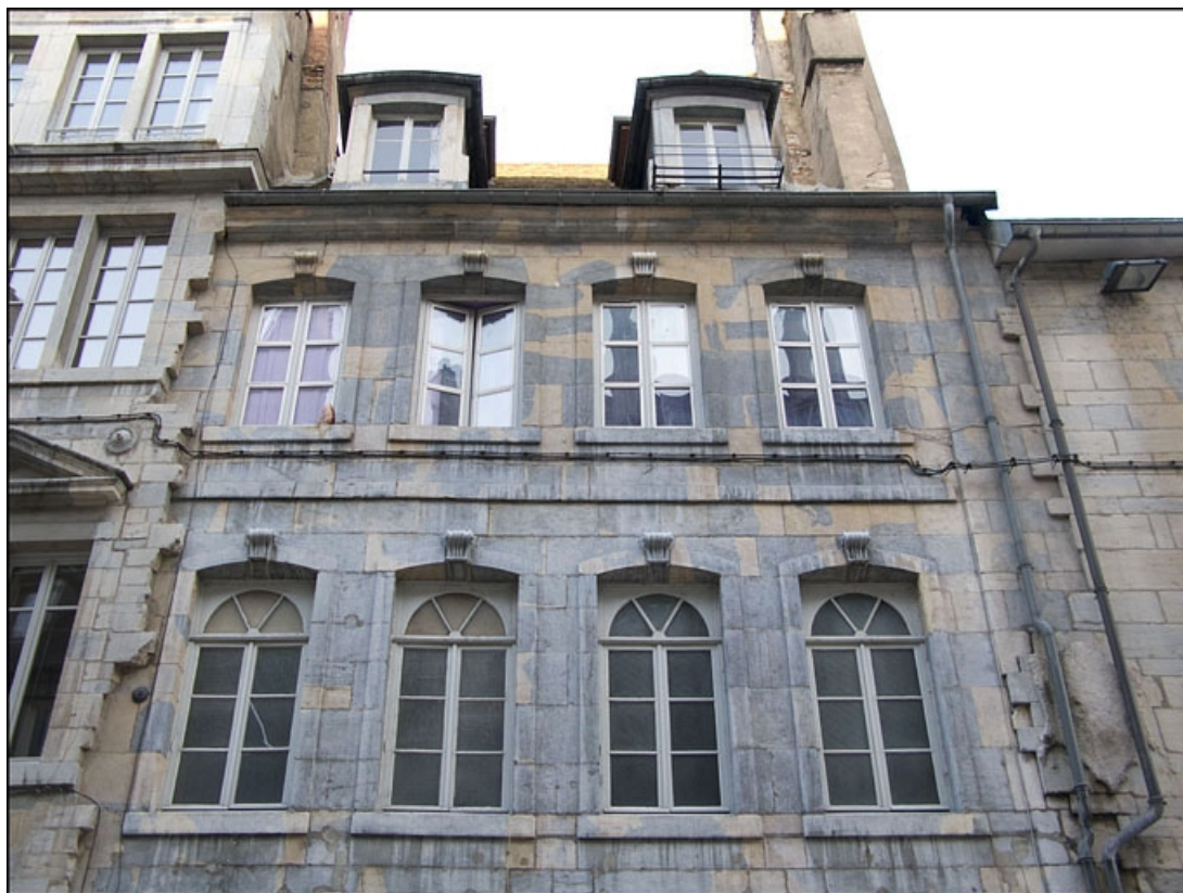
Détail des premier et deuxième étages de la façade antérieure du 13 Grande Rue : de face. 25, Besançon Grande Rue 13, 15, lieudit : îlot Chevanney
