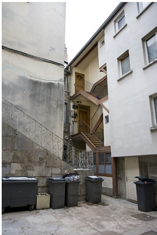
Vue des logis situés dans la deuxième cour : 13 Grande Rue.
