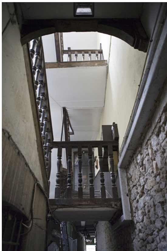
Détail de l'escalier à cage ouverte dans la première cour : 13 Grande Rue. 25, Besançon Grande Rue 13, 15, lieudit : îlot Chevanney
