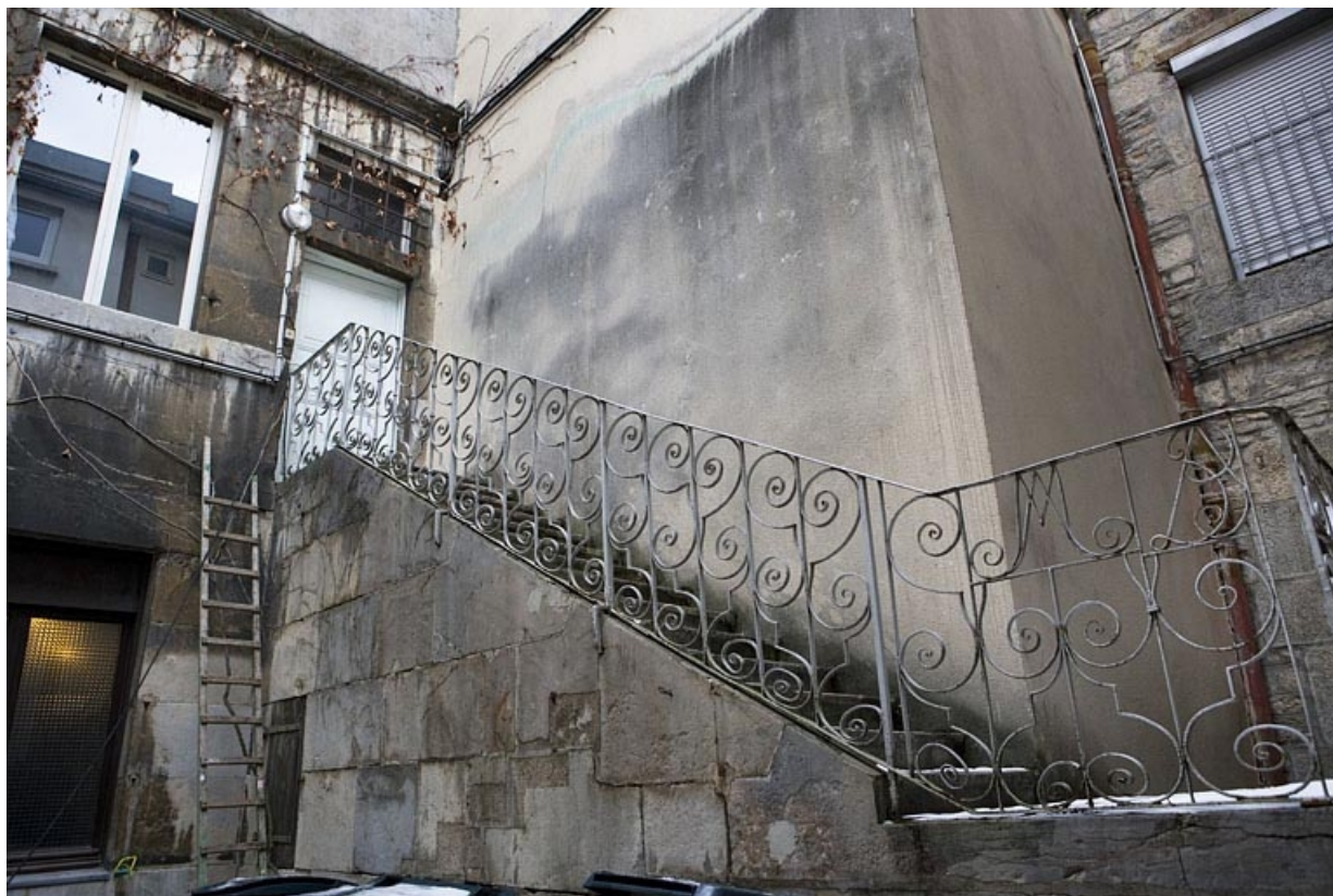
Détail d'un escalier extérieur situé dans la deuxième cour : 13 Grande Rue. 25, Besançon Grande Rue 13, 15, lieudit : îlot Chevanney
