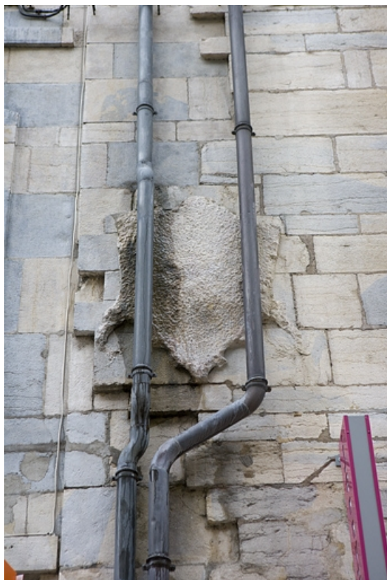
Détail des armoiries bûchées entre le 13 et le 15 Grande Rue.
