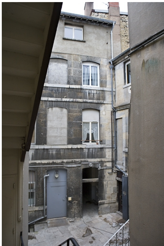
Façade postérieure du premier logis secondaire donnant sur la deuxième cour : 13 Grande Rue. 25, Besançon Grande Rue 13, 15, lieudit : îlot Chevanney
