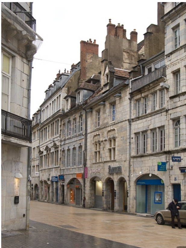
Vue d'ensemble des façades antérieures de trois quarts droit.
