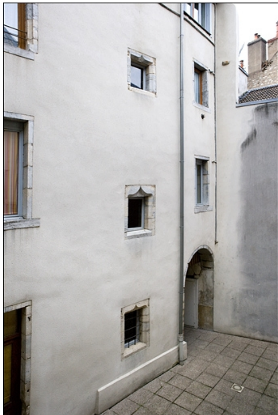
Façade postérieure du premier logis secondaire donnant sur la deuxième cour. 25, Besançon Grande Rue 17, lieudit : îlot Chevanney
