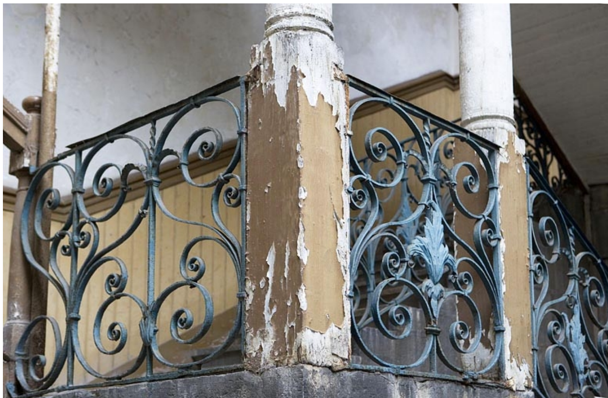
Détail de la rampe en ferronnerie de l'escalier à cage ouverte.
