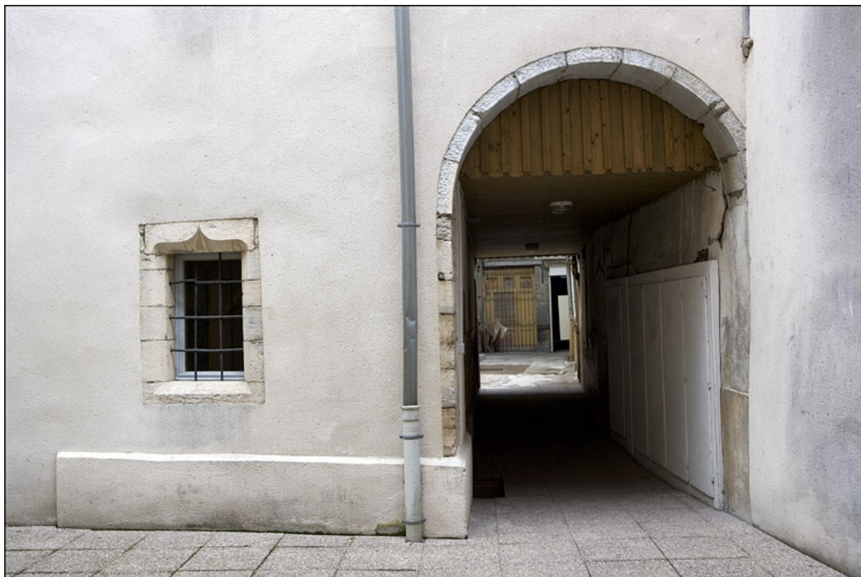
Premier logis secondaire, façade postérieure : détail du passage cocher.
