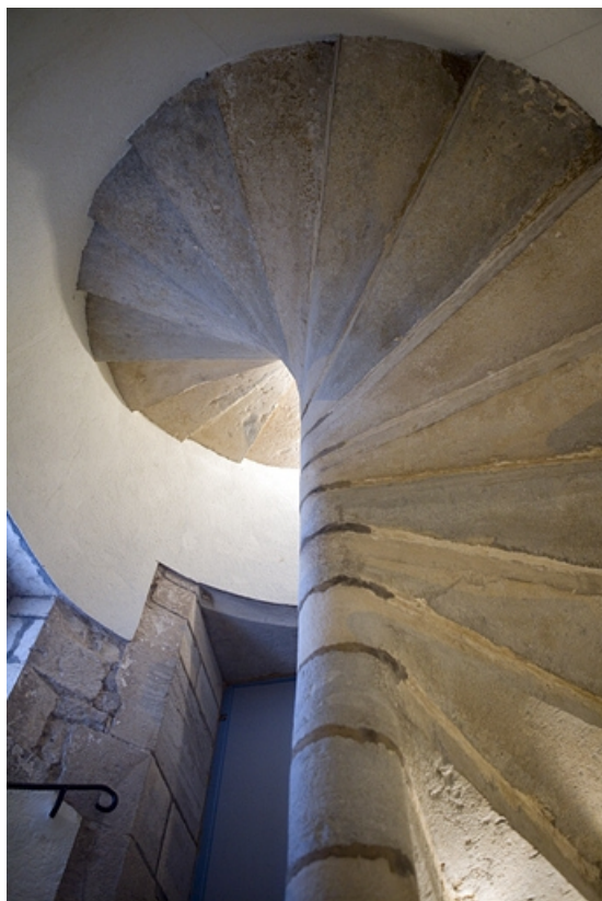
Premier logis secondaire : détail de l'escalier en vis avec la porte d'entrée.
