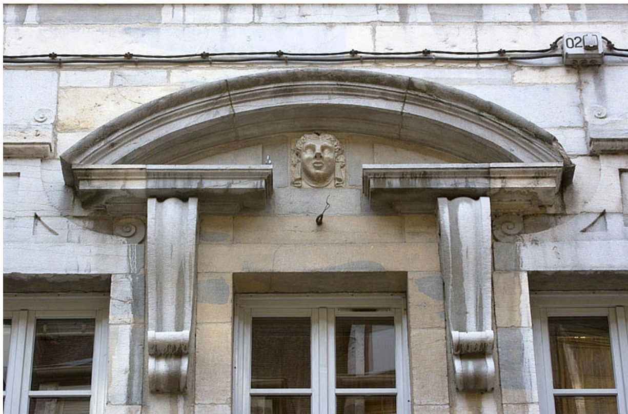
Façade antérieure du logis principal : détail d'un fronton cintré au-dessus d'une fenêtre du premier étage. 25, Besançon, 11 Grande Rue, lieudit : îlot Chevanney
