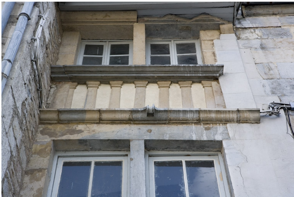
Détail du motif séparant le premier et le deuxième étage de l'entrée cochère. 25, Besançon, 11 Grande Rue, lieudit : îlot Chevanney
