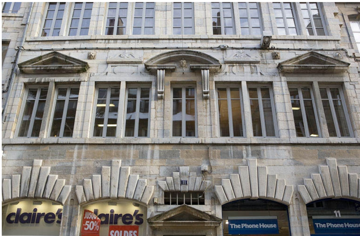
Façade antérieure du logis principal : détail du premier étage.
