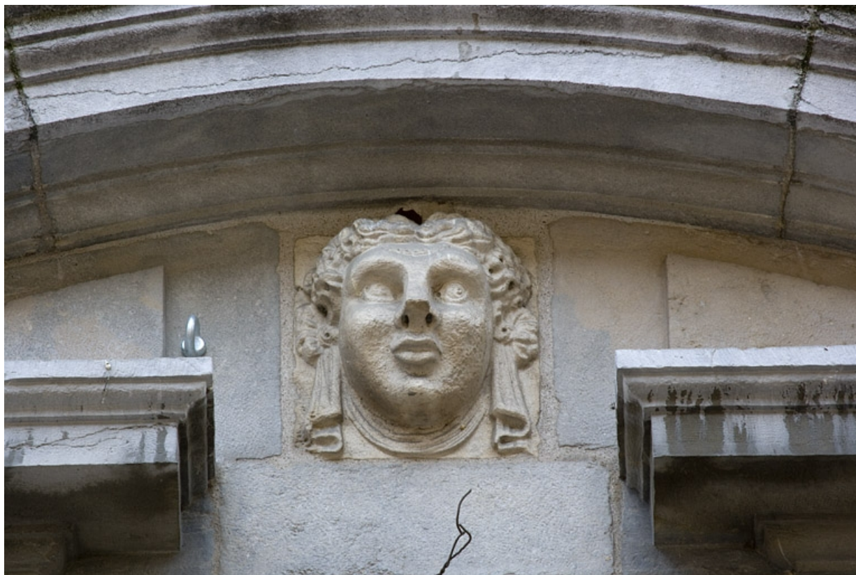
Façade antérieure du logis principal : détail d'une tête sculptée, fronton d'une fenêtre du premier étage. 25, Besançon, 11 Grande Rue, lieudit : îlot Chevanney
