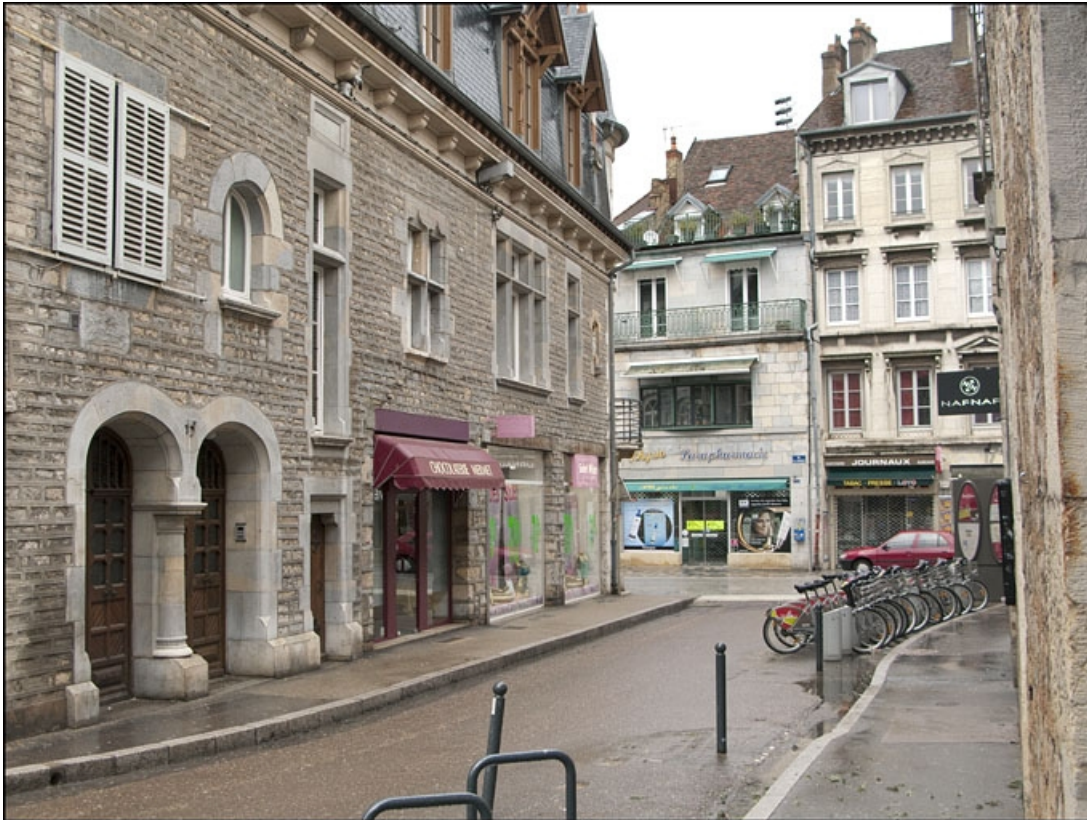
Vue d'ensemble de la façade située rue Luc Breton : de trois quarts gauche, vue rapprochée. 25, Besançon, 15 rue Luc Breton, lieudit : îlot Chevanney
