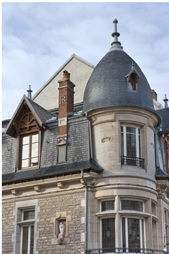
Détail de la partie supérieure de la tourelle d'angle. 25, Besançon, 15 rue Luc Breton, lieudit : îlot Chevanney
