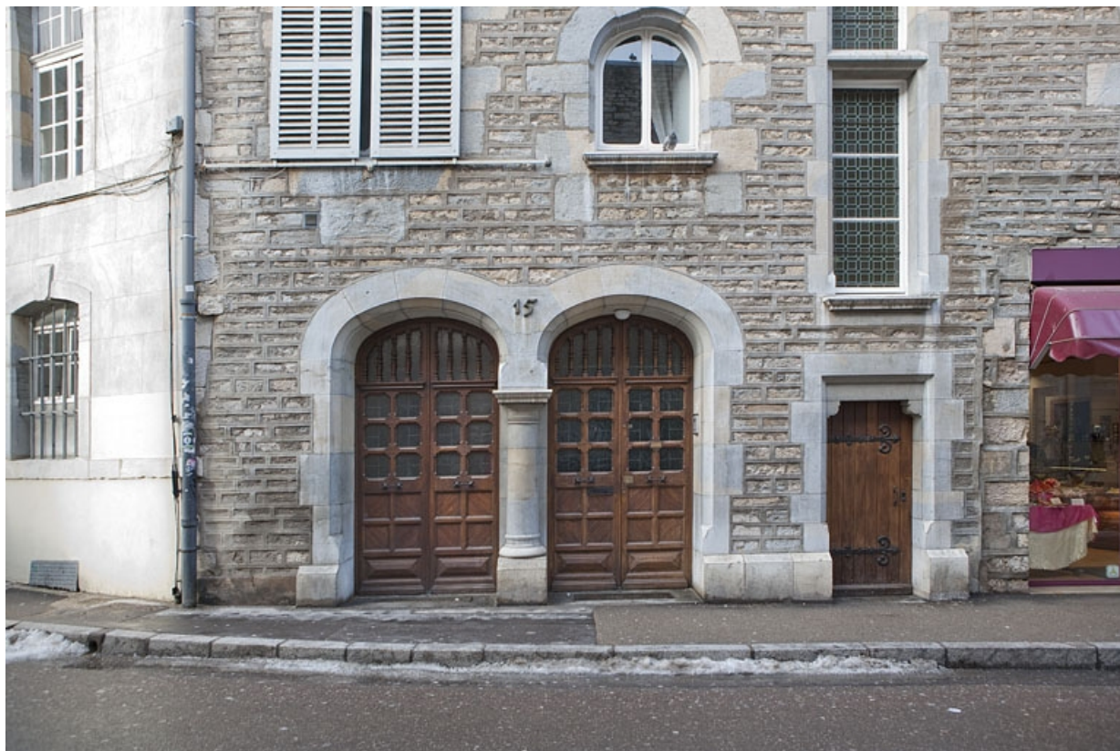
Façade rue Luc Breton : détail de l'entrée.
