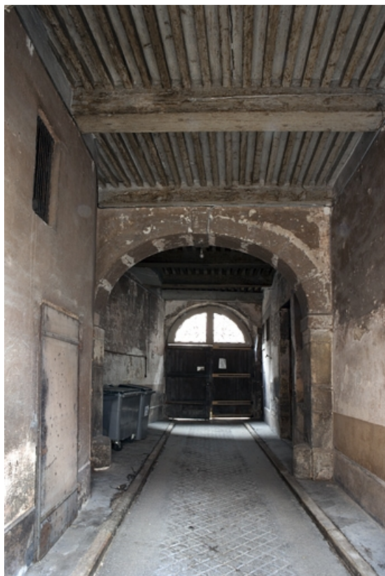
Vue d'ensemble du passage cocher, de face.
