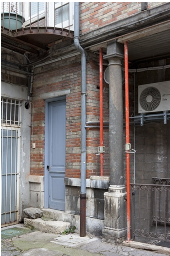
Détail d'une colonne en pierre à l'angle du bûcher.
