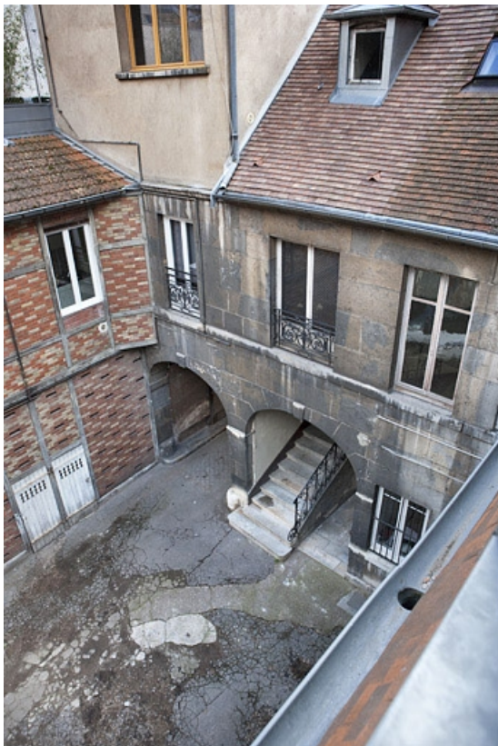
Vue d'ensemble de l'aile des communs en fond de cour.
