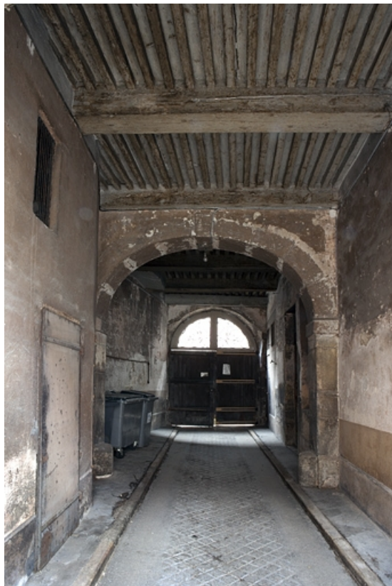
Vue d'ensemble du passage cocher, de face.
