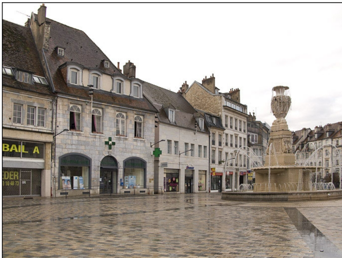
Vue d'ensemble du logis principal de trois quarts gauche dans l'alignement de la place.
