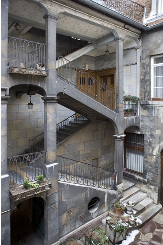
Détail de l'escalier à cage ouverte de trois quarts gauche.
