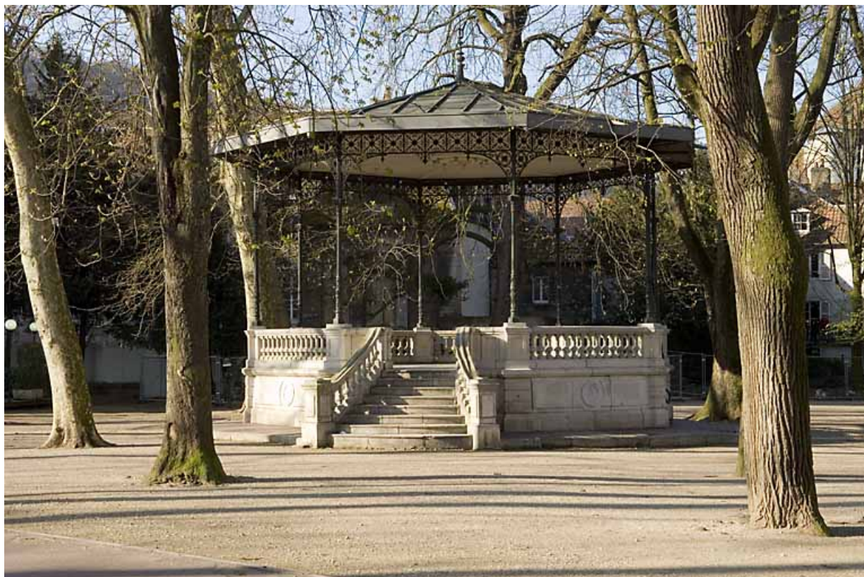
Kiosque : vue d'ensemble, de face.
