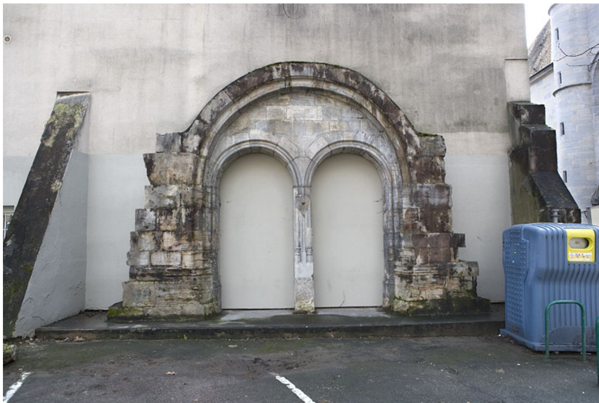
Détail de l'ancien portail d'entrée de l'église du couvent des Carmes, de face. 25, Besançon rue de la Préfecture, lieudit : îlot Granvelle
