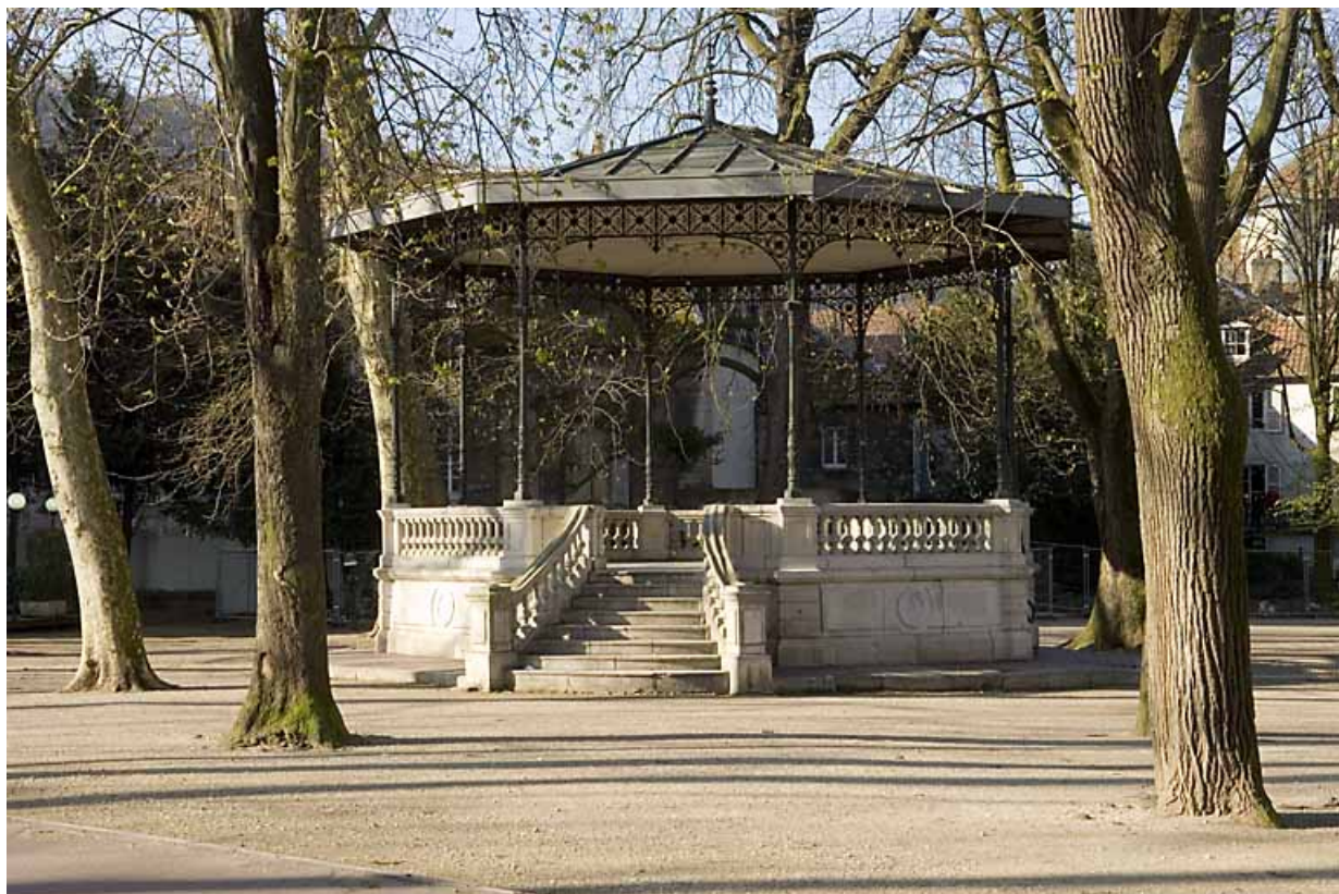
Kiosque : vue d'ensemble, de face.
