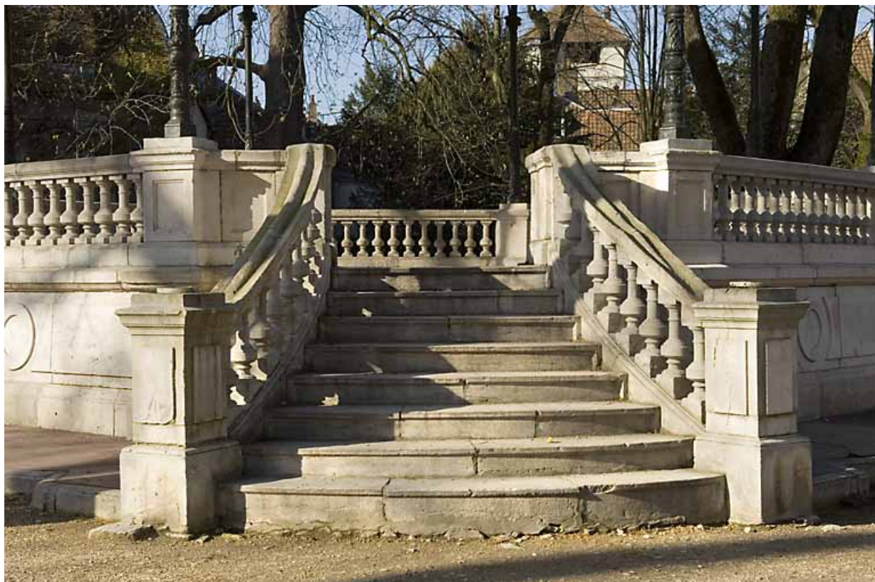
Kiosque : détail de la montée d'escalier.
