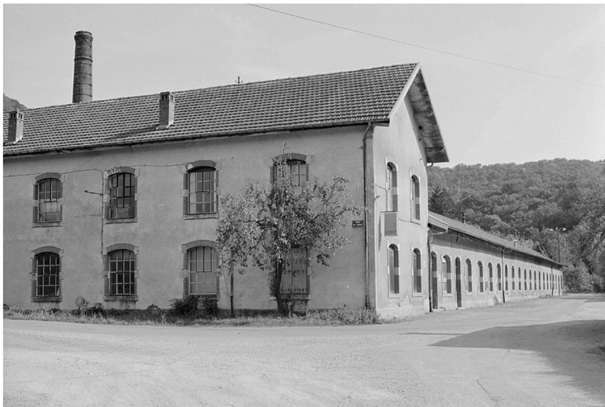
Façade antérieure depuis l'ouest.
