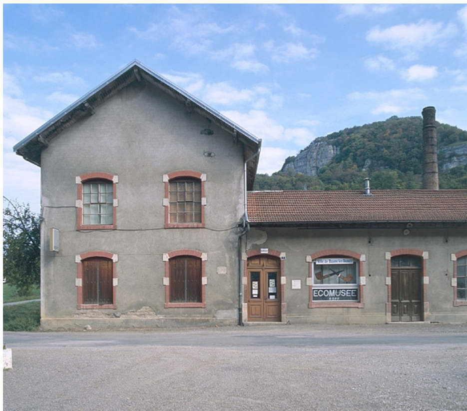
Façade antérieure du bâtiment à étage.
