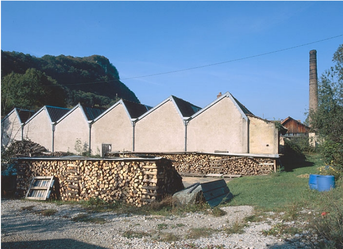
Murs-pignons est de l'atelier de fabrication.
