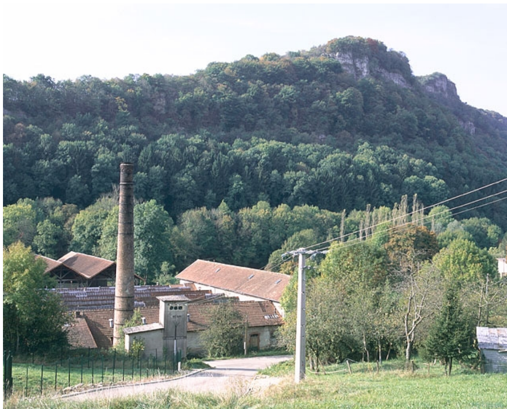
Vue des toitures depuis le nord.
