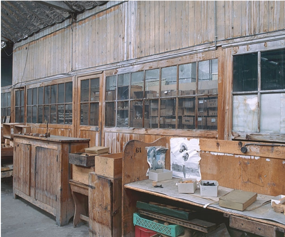
Cloison vitrée d'un atelier de vérification.
