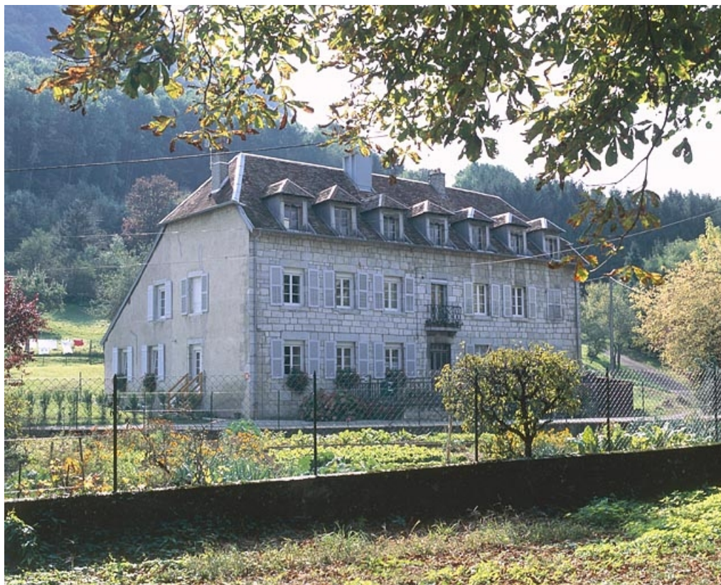
Vue de trois quarts du logement ouvrier collectif dit maison Laillet.
