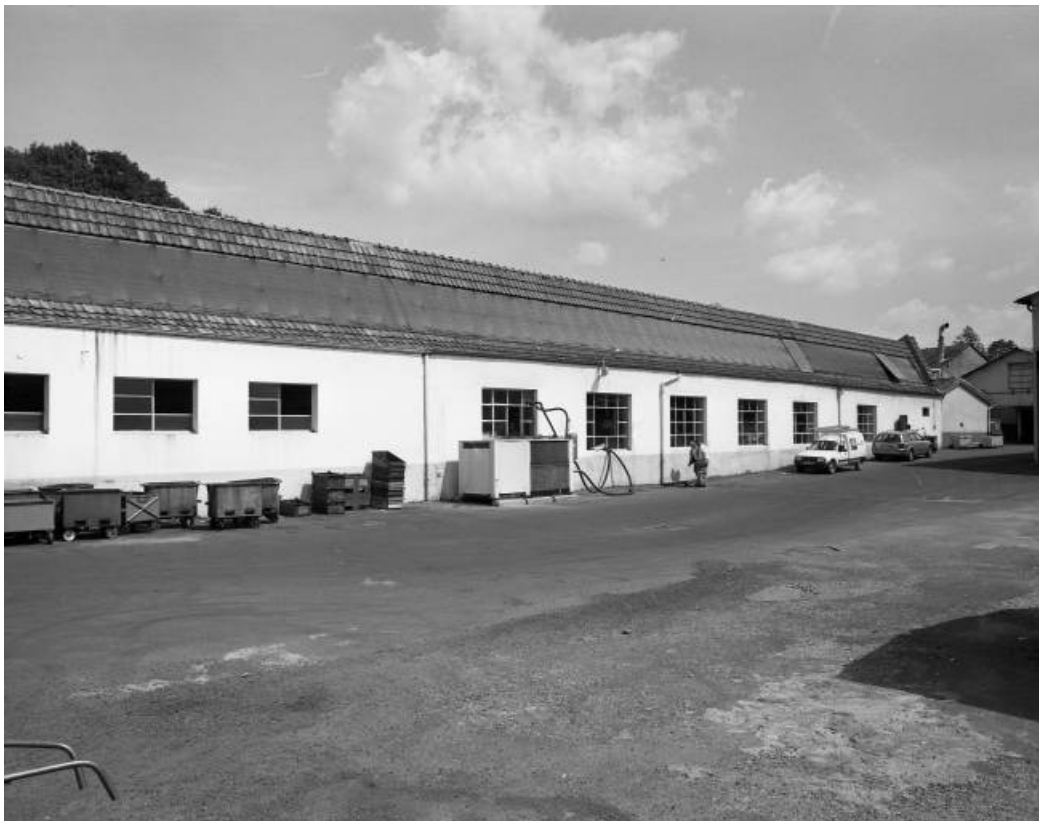
Atelier de fabrication (crémaillères de direction). Façade est.
