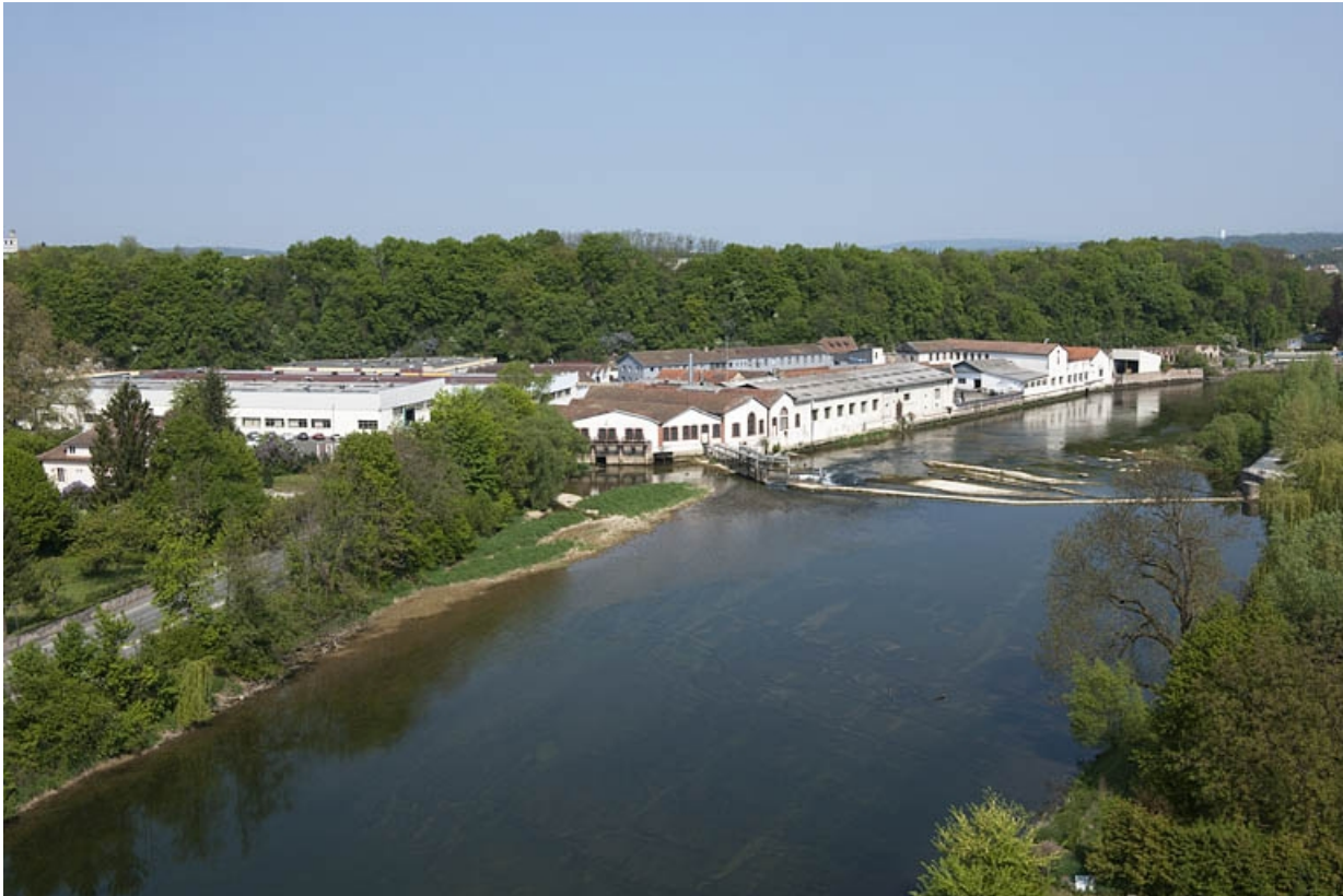
Vue plongeante depuis le sud-est.
