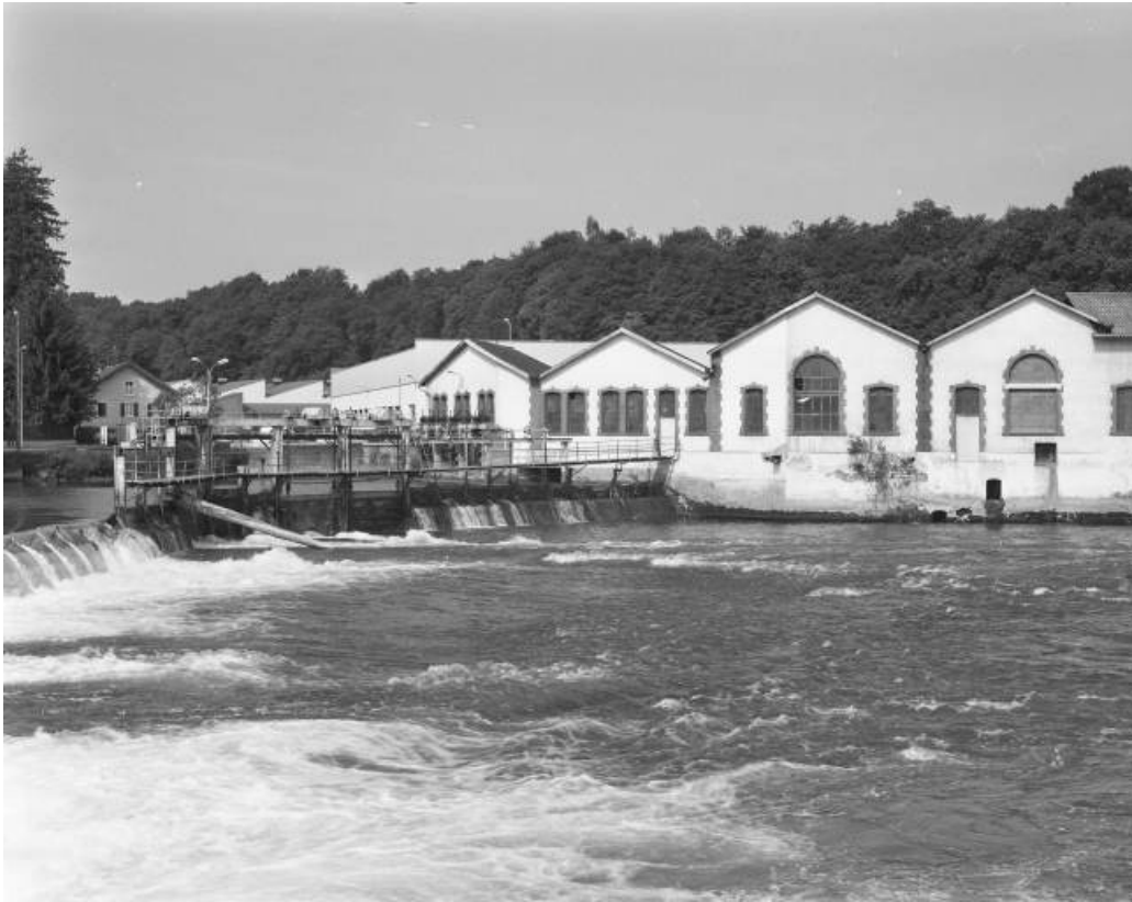
Entrepôt industriel (ancienne fonderie) et vannes du barrage depuis la rive droite. Vue rapprochée. 25, Valentigney R.D. 38
