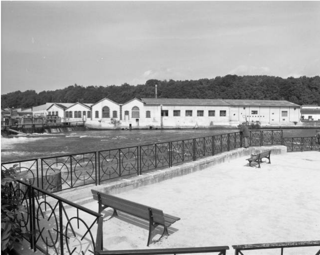
Bâtiments sud depuis la rive droite.
