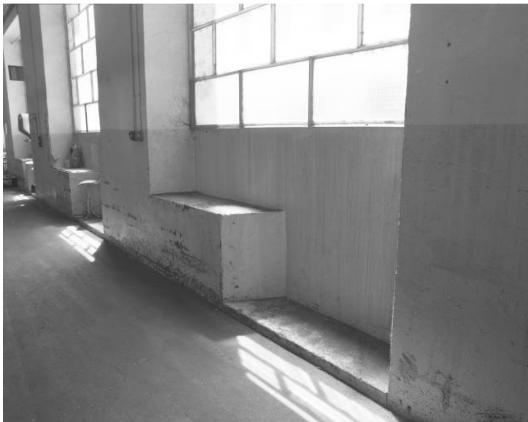
Atelier outillage-entretien mécanique. Vue intérieure des anciennes ouvertures.
