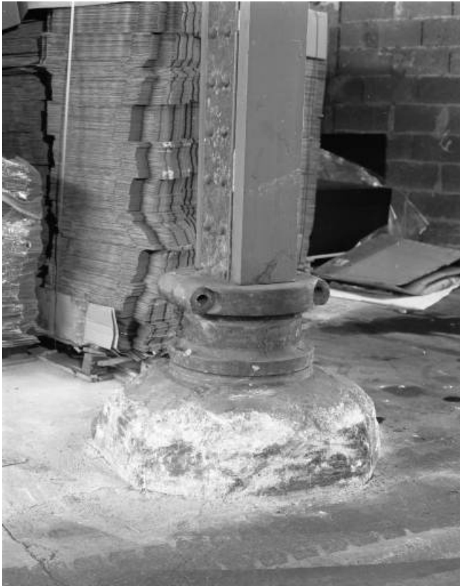
Ancienne fonderie. Base d'un pilier (fonte ?).
