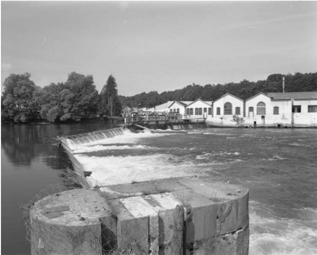
Vue d'ensemble depuis le pont.
