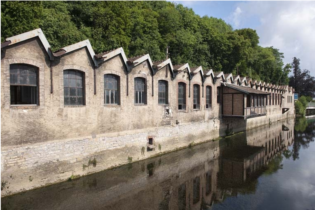
Atelier de fabrication nord. Murs-pignons depuis le sud-est.
