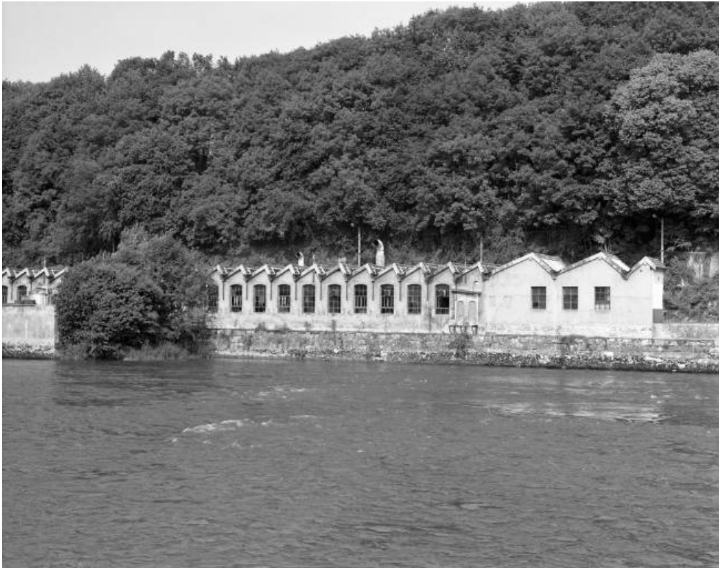
Atelier des fins de séries. Façade est depuis la rive droite.
