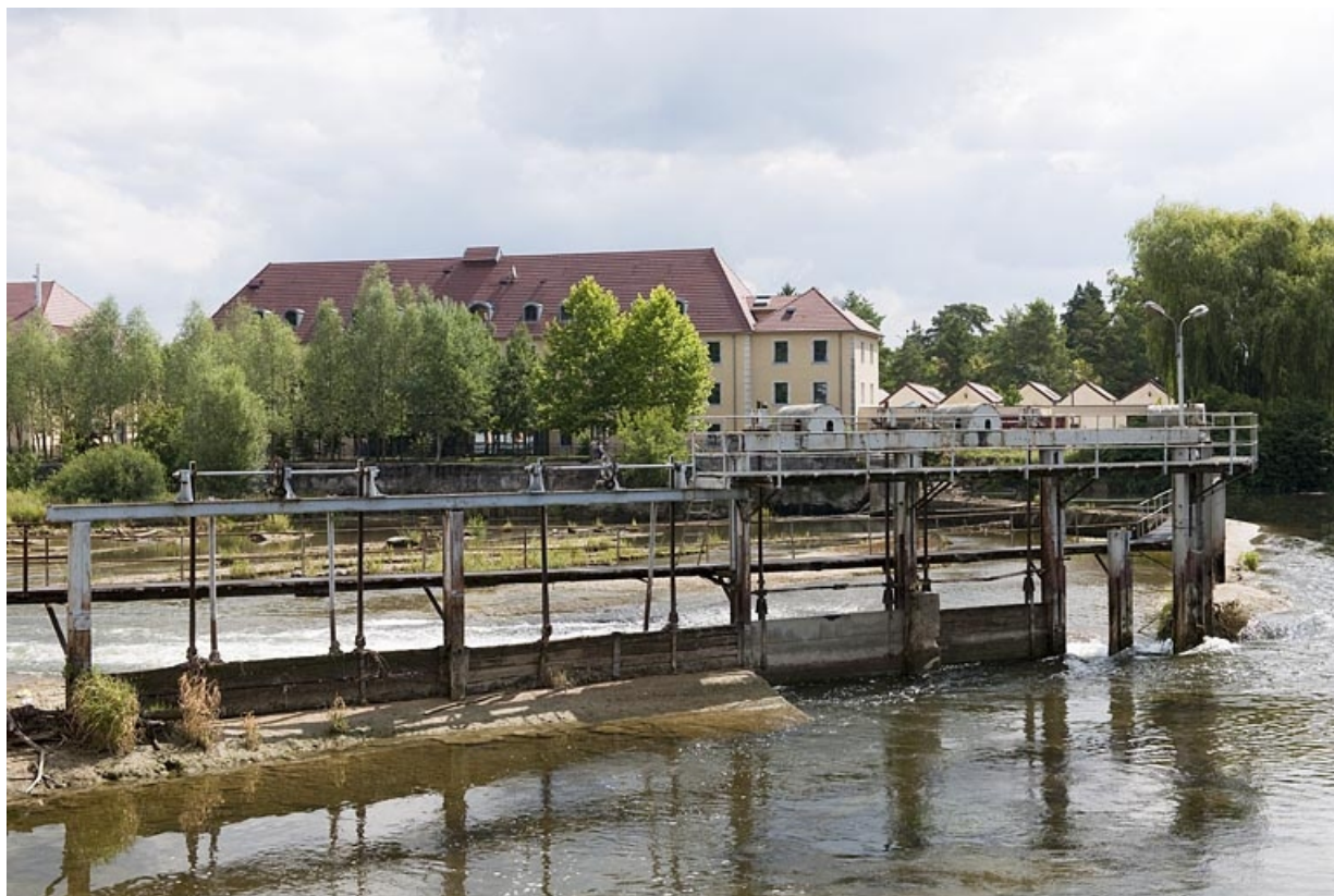
Barrage depuis la rive gauche.
