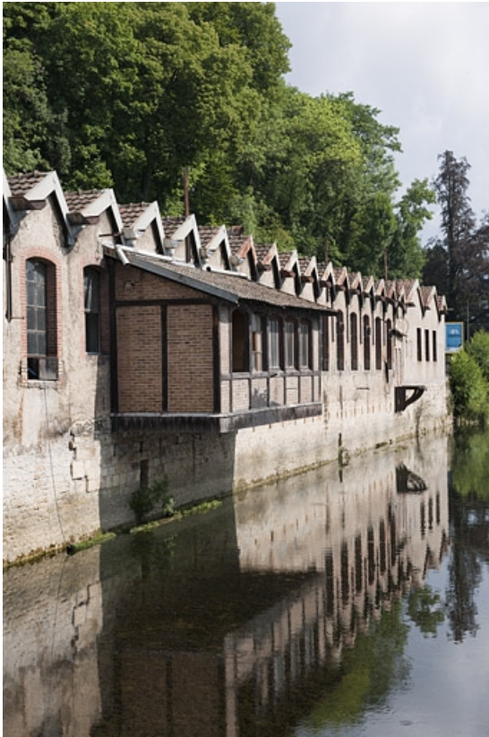
Atelier de fabrication nord. Murs-pignons donnant sur le canal de fuite.
