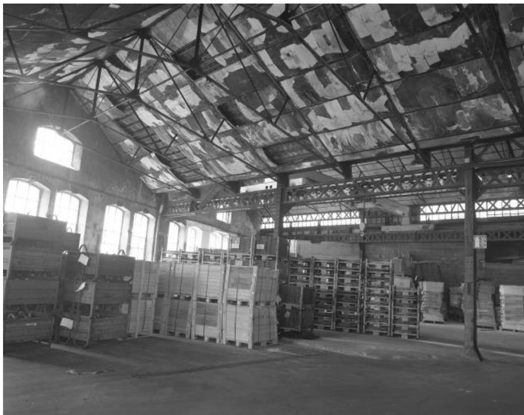
Ancienne fonderie. Vue intérieure générale.
