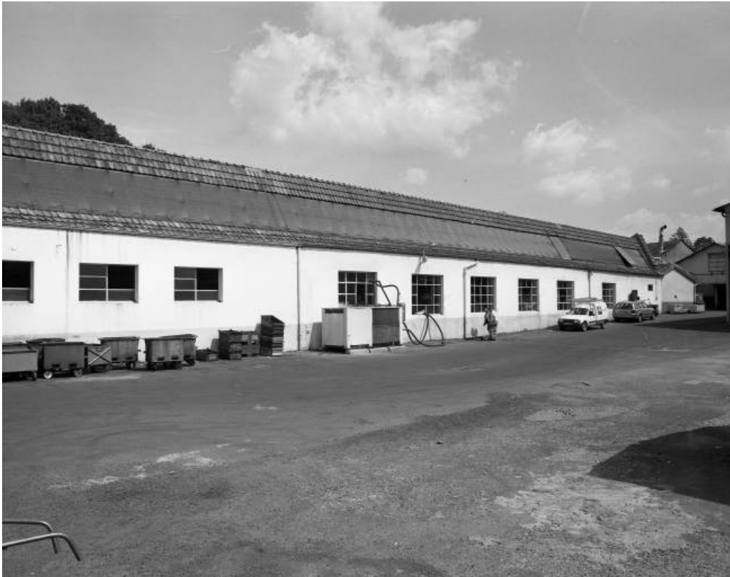
Atelier de fabrication (crémaillères de direction). Façade est. 25, Valentigney R.D. 38
