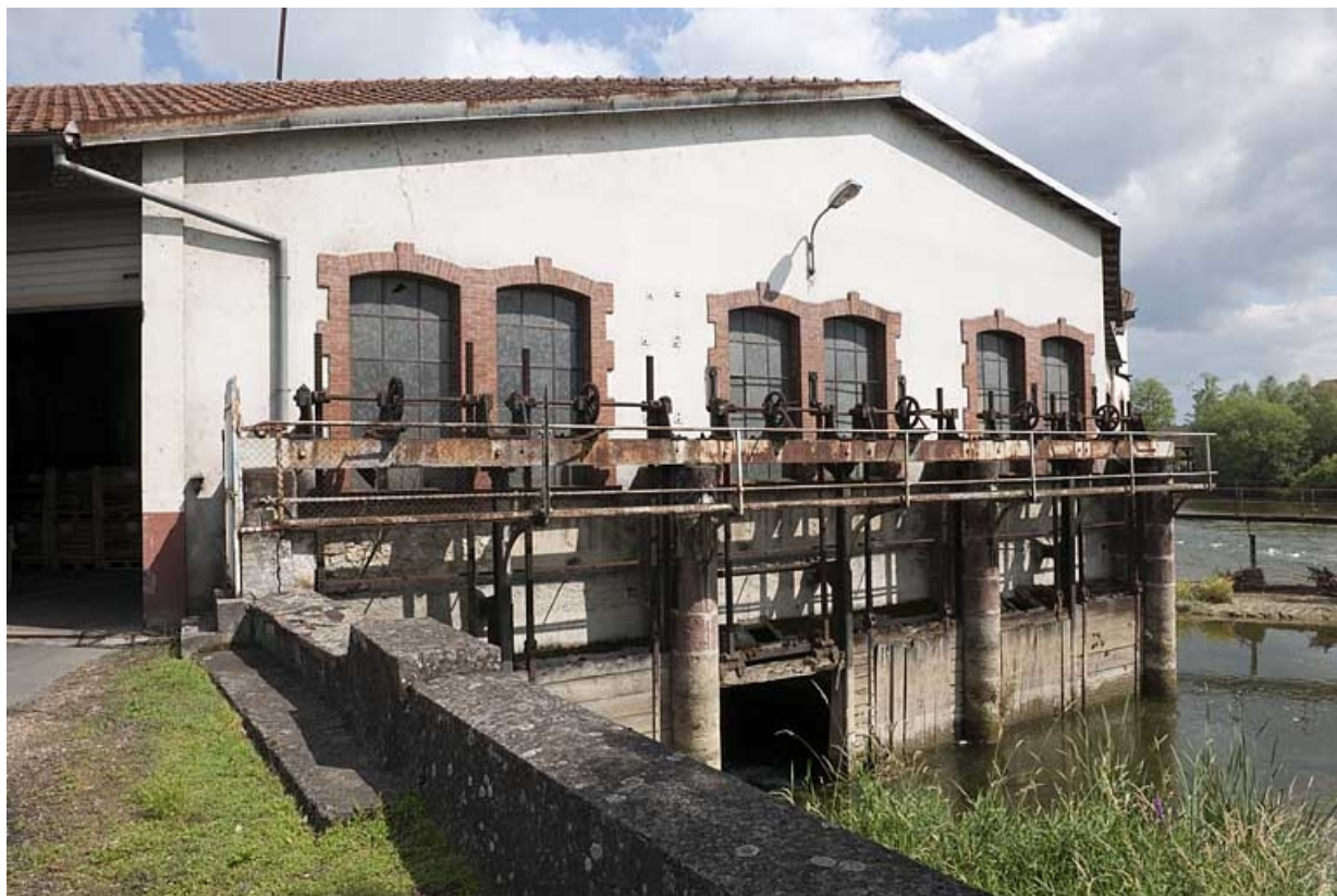
Vannage de prise d'eau devant le pignon d'un magasin industriel. 25, Valentigney R.D. 38
