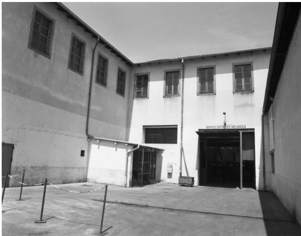
Atelier outillage-entretien mécanique. Façade sud.
