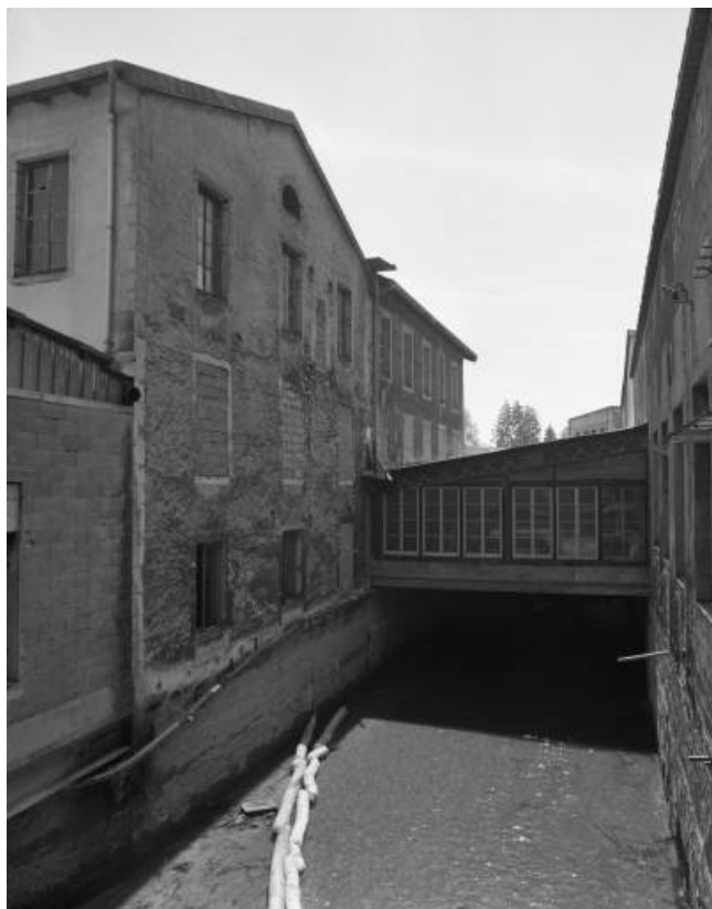
Atelier outillage-entretien mécanique. Façade ouest. 25, Valentigney R.D. 38
