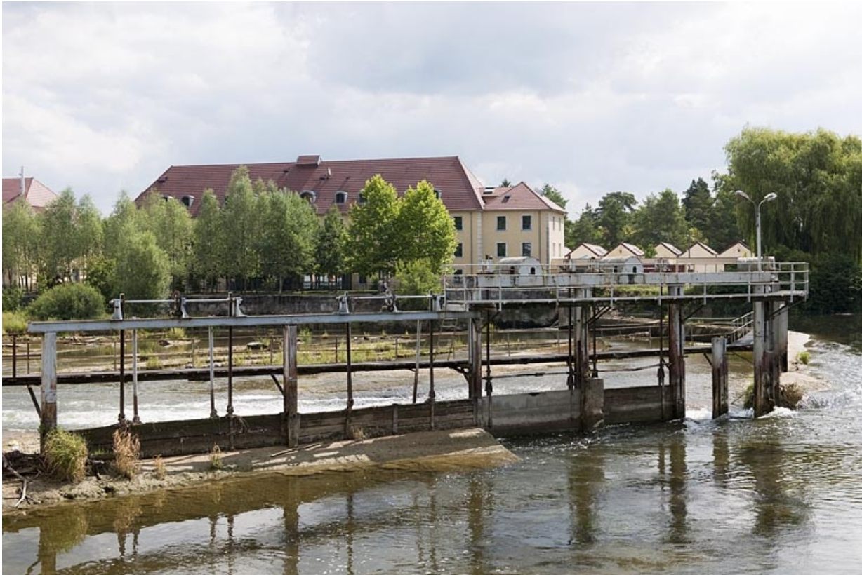
Barrage depuis la rive gauche.
