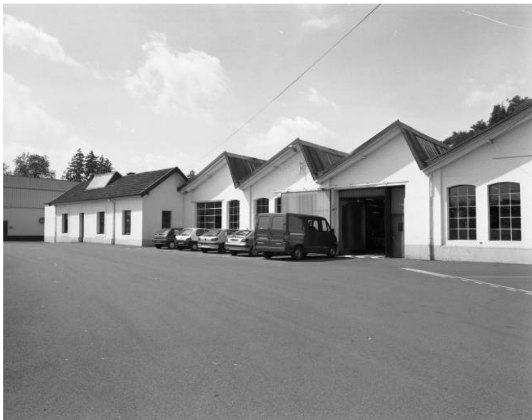
Atelier de fabrication (culbuteurs). Vue d'ensemble depuis l'est.
