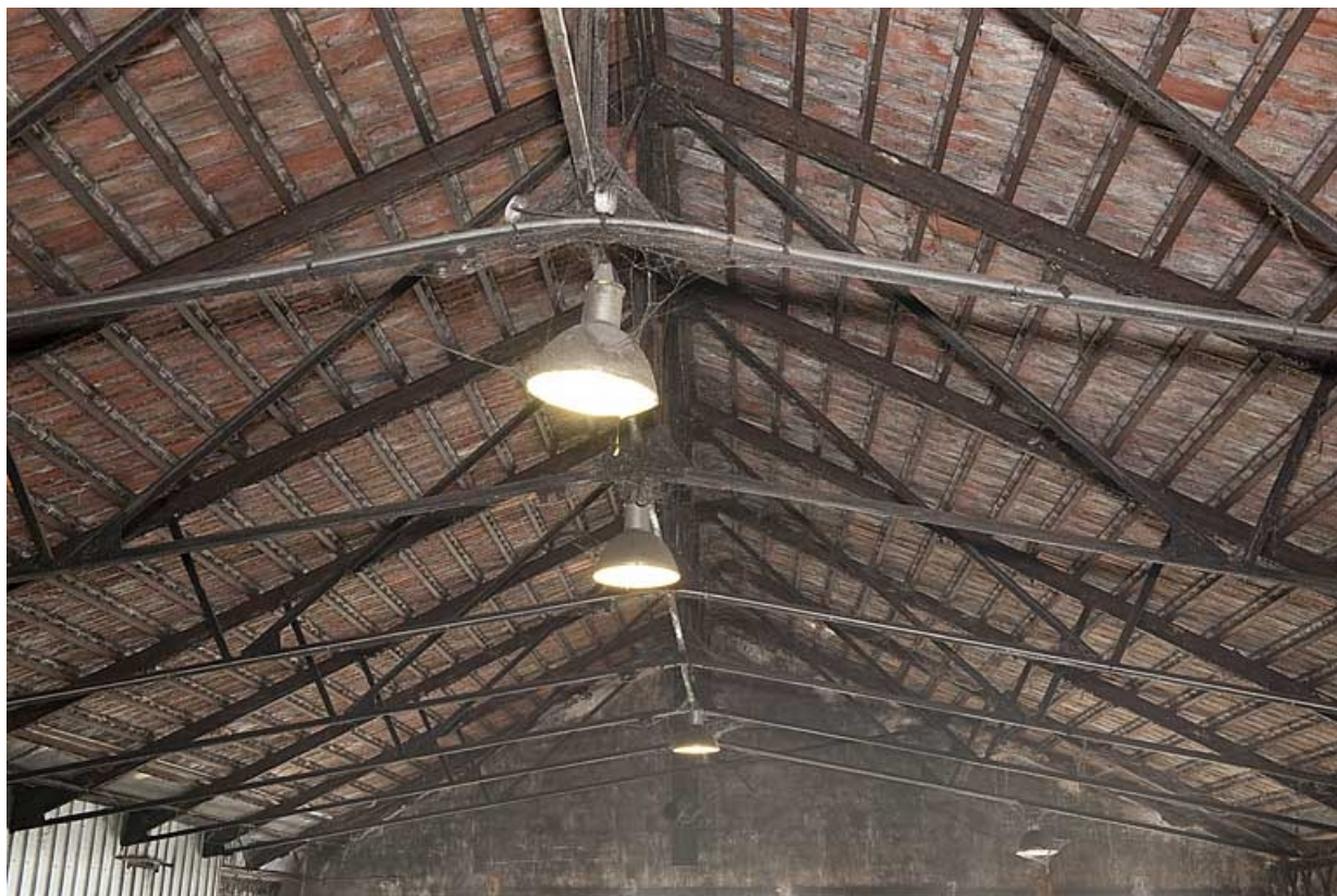
Charpente métallique d'un magasin industriel.
