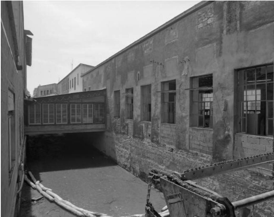
Atelier de fabrication (axes de fourchettes). Façade est. 25, Valentigney R.D. 38
