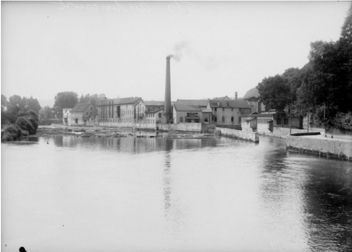
[Vue d'ensemble depuis le pont en aval].
