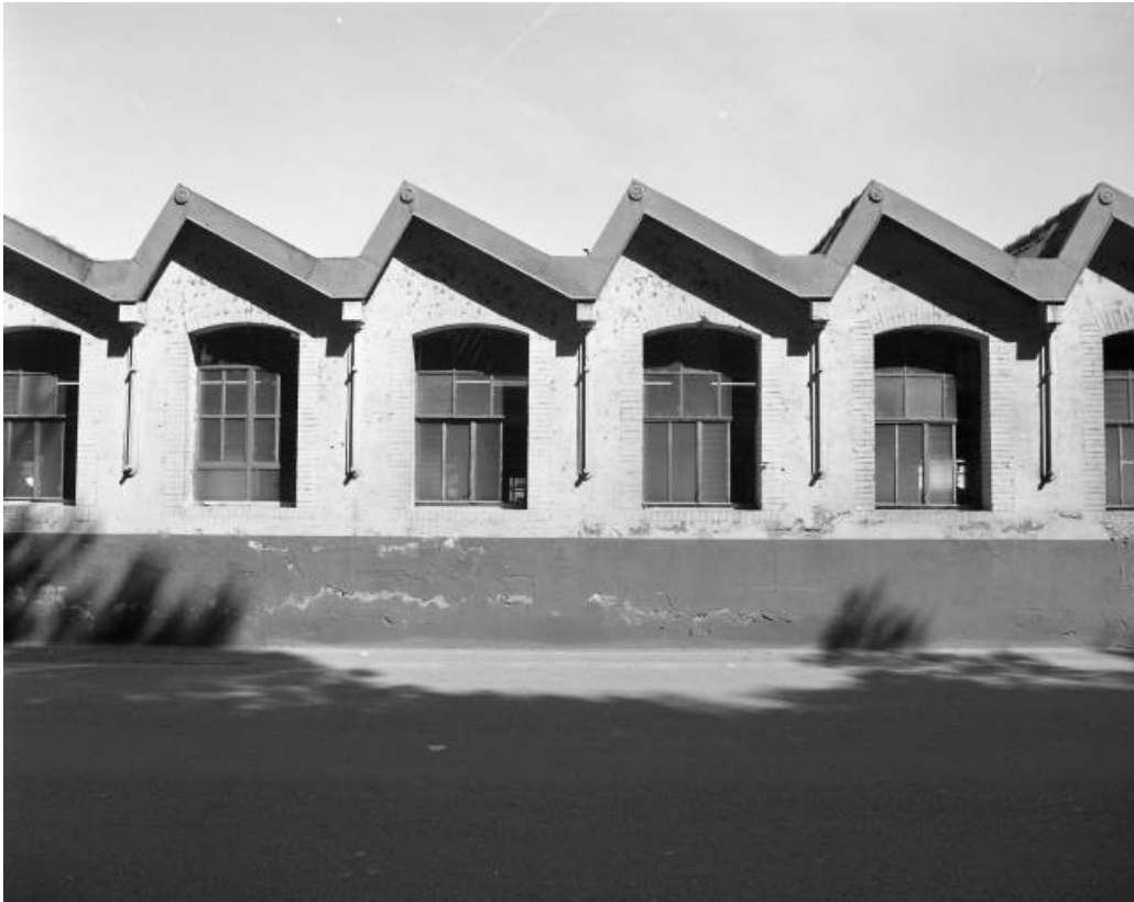
Atelier des fins de séries. Façade ouest. Détail.
