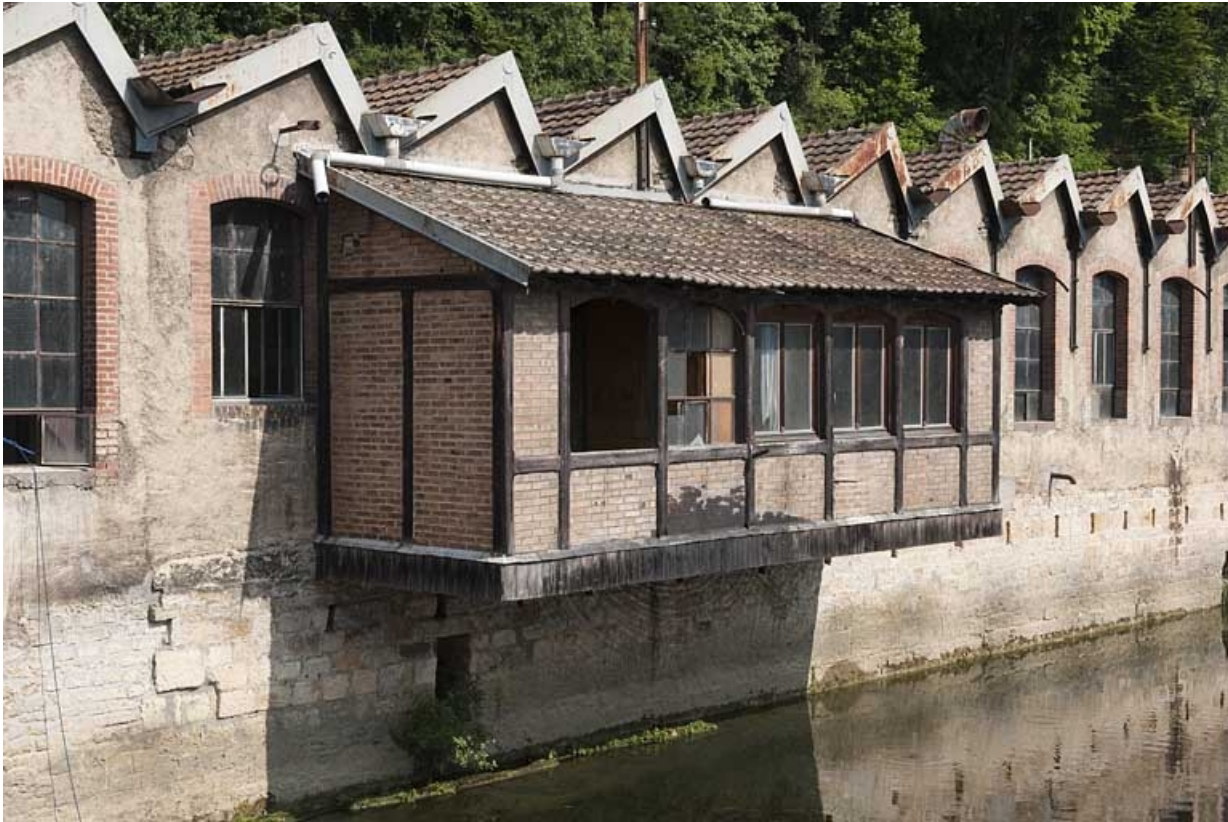
Atelier de fabrication nord. Construction en surplomb sur le canal de fuite. 25, Valentigney R.D. 38
