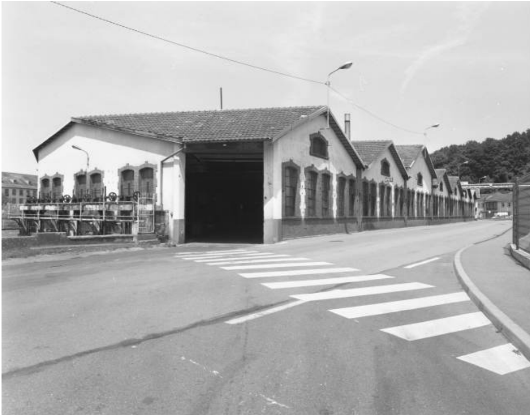
Ancienne fonderie vue de trois quarts gauche.
