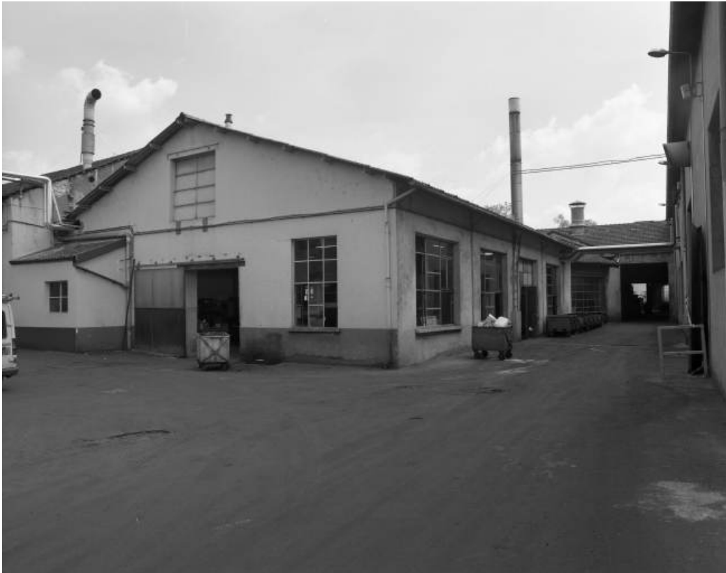
Atelier de fabrication (pièces de rechange). Vue de trois quarts gauche. 25, Valentigney R.D. 38
