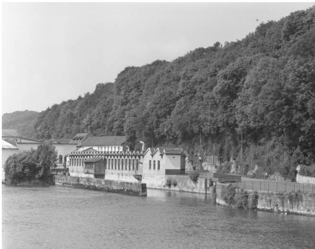
Vue d'ensemble depuis le pont. Vue rapprochée.
