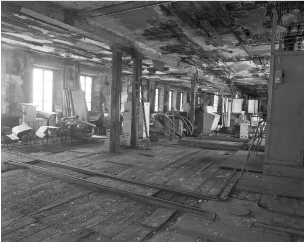
Atelier outillage-entretien mécanique. Premier étage.
