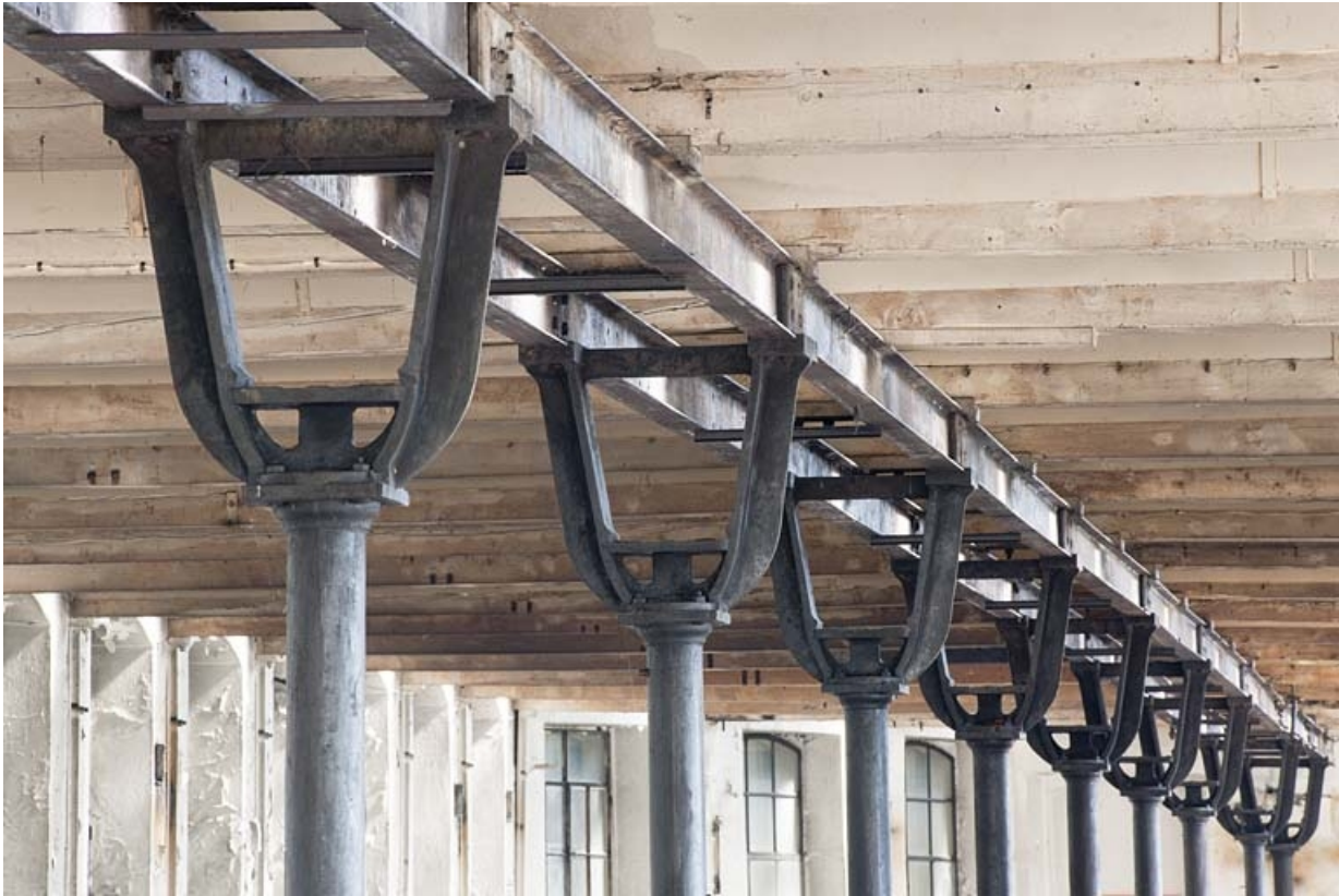
Atelier de fabrication nord. Détail des parties supérieures des colonnes en lyre. 25, Valentigney R.D. 38
