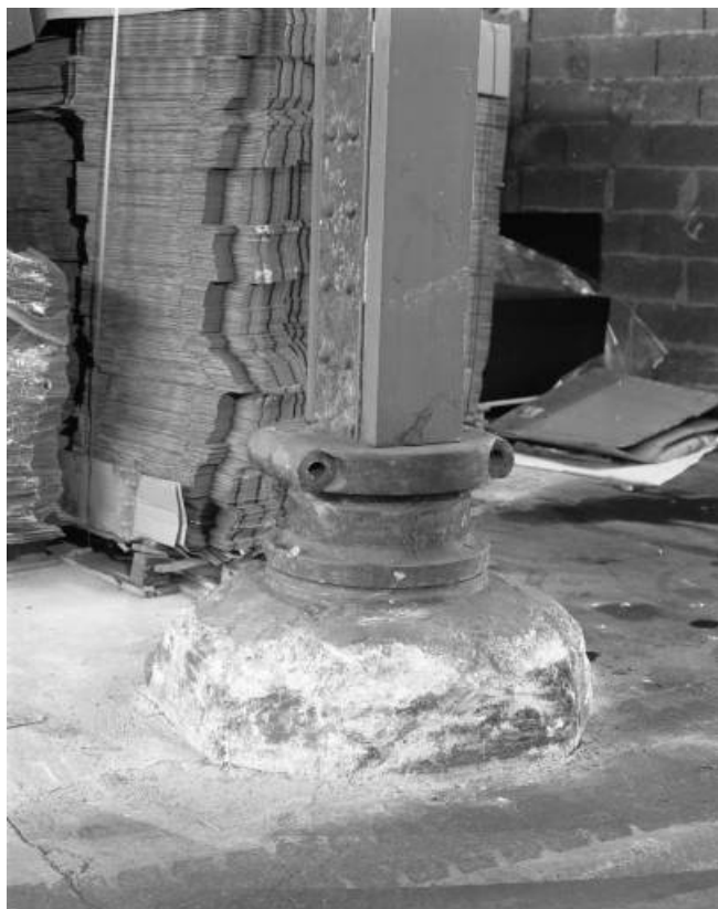
Ancienne fonderie. Base d'un pilier (fonte ?).
