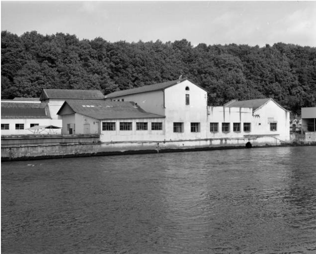
Atelier outillage-entretien mécanique depuis la rive droite. Vue rapprochée. 25, Valentigney R.D. 38
