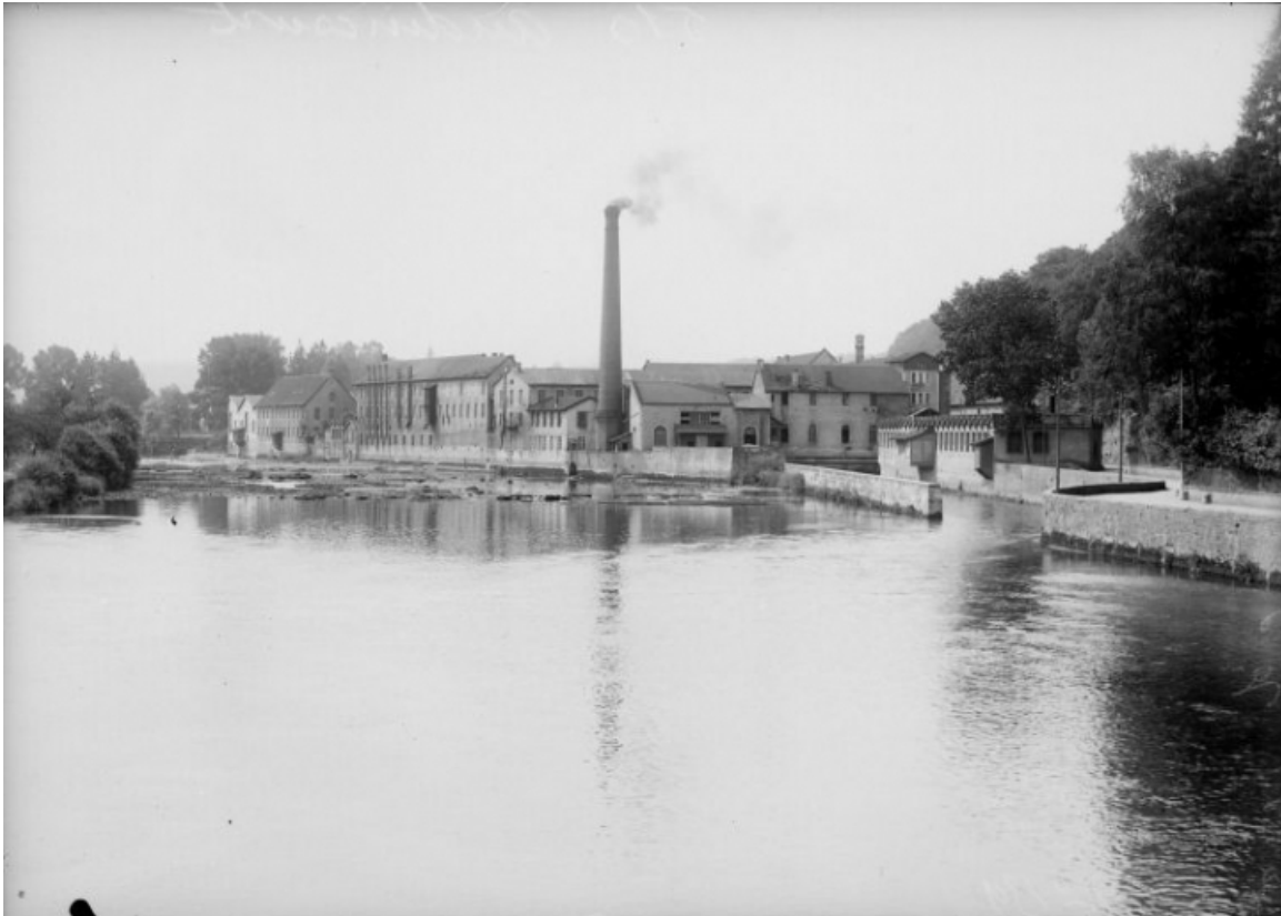
[Vue d'ensemble depuis le pont en aval].
