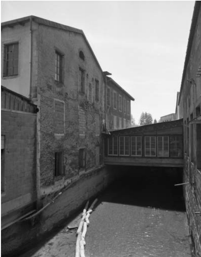
Atelier outillage-entretien mécanique. Façade ouest.
