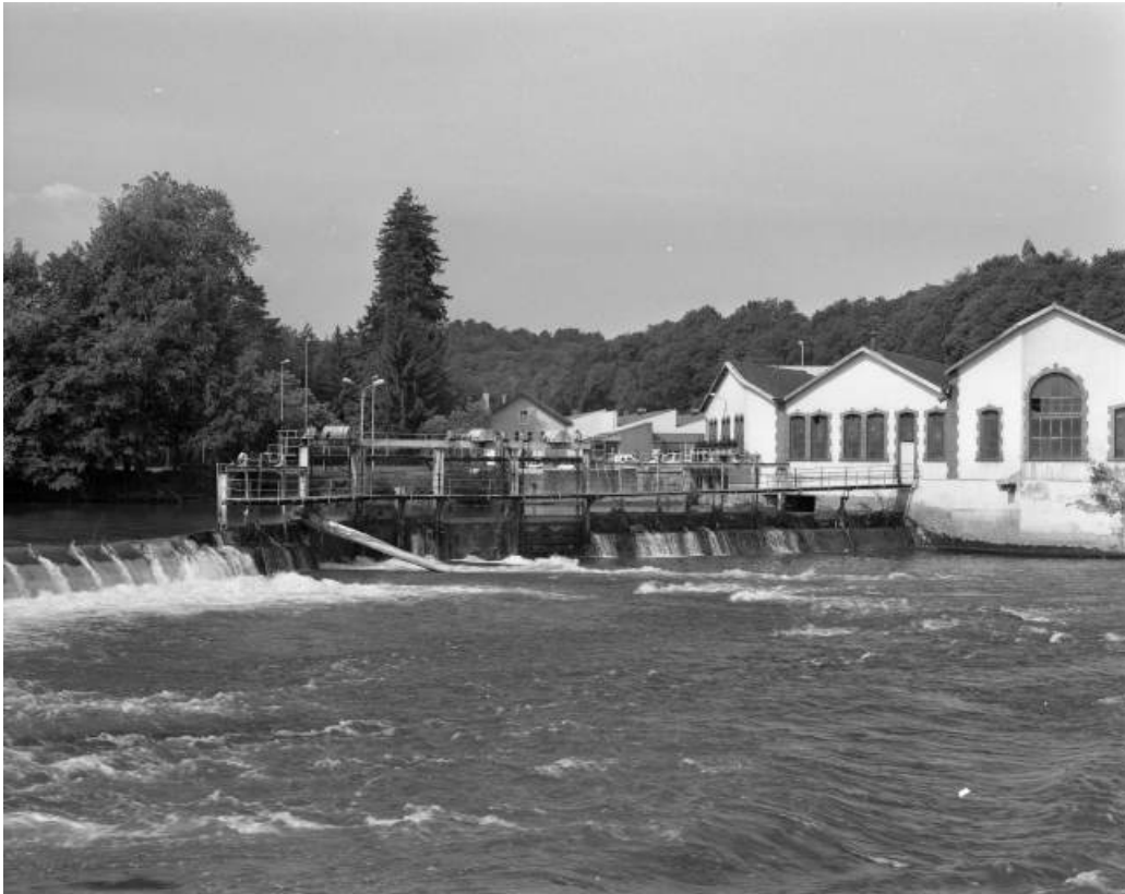
Entrepôt industriel (ancienne fonderie) et vannes du barrage depuis la rive droite. 25, Valentigney R.D. 38
