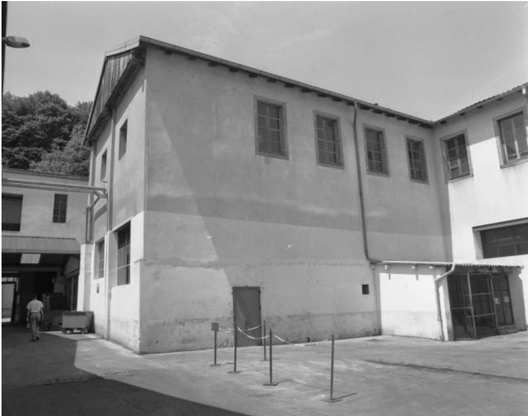
Atelier de fabrication (outillage-entretien mécanique). Vue de trois quarts gauche. 25, Valentigney R.D. 38
