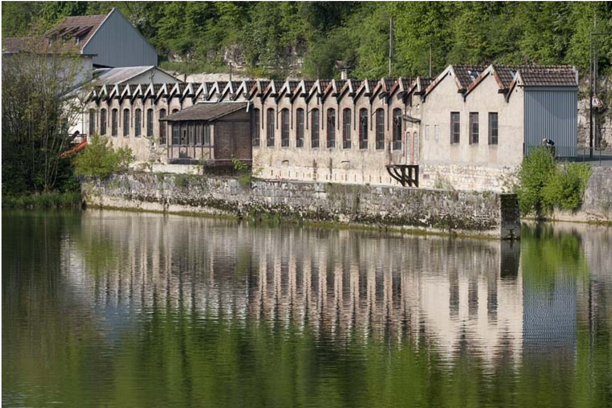
Atelier de fabrication nord. Vue rapprochée depuis le pont.
