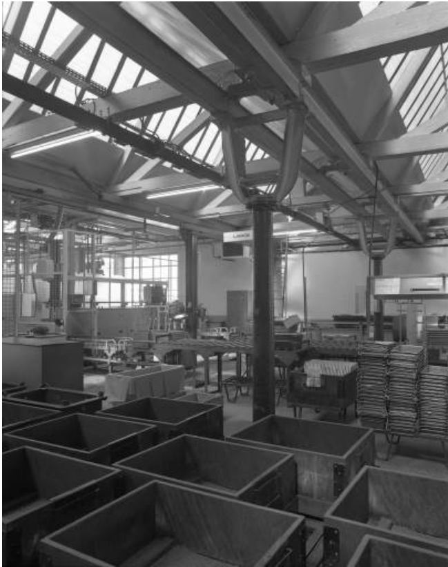
Atelier des culbuteurs. Charpente en bois.
