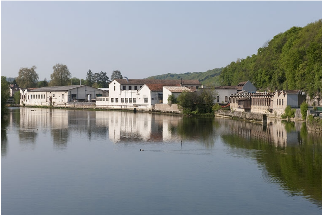
Vue d'ensemble depuis l'aval.
