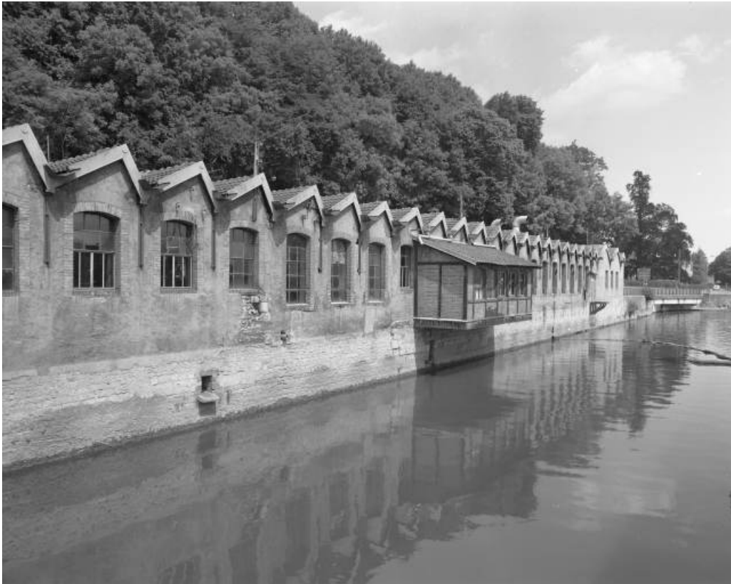
Atelier des fins de séries. Façade est.
