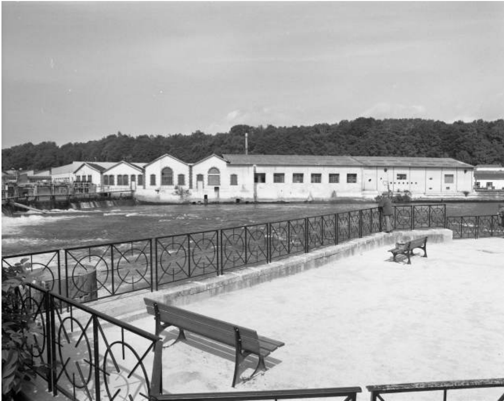
Bâtiments sud depuis la rive droite.
