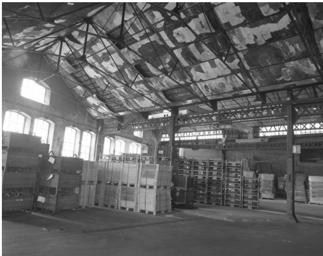
Ancienne fonderie. Vue intérieure générale.
