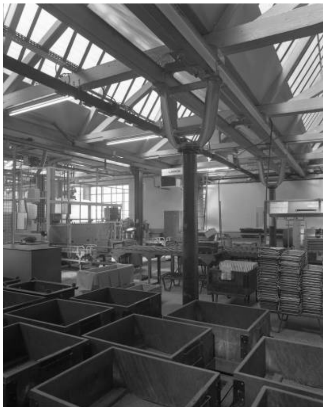
Atelier des culbuteurs. Charpente en bois.
