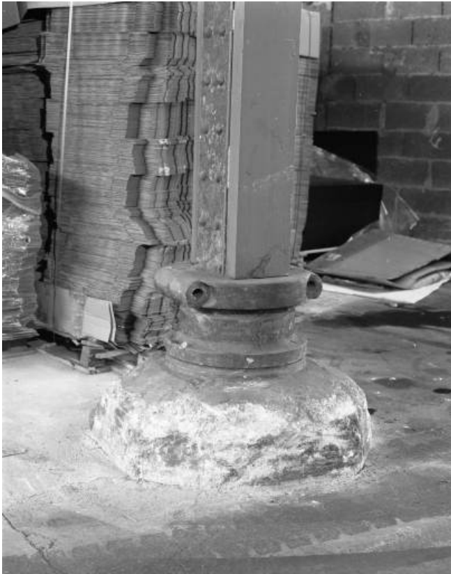
Ancienne fonderie. Base d'un pilier (fonte ?).
