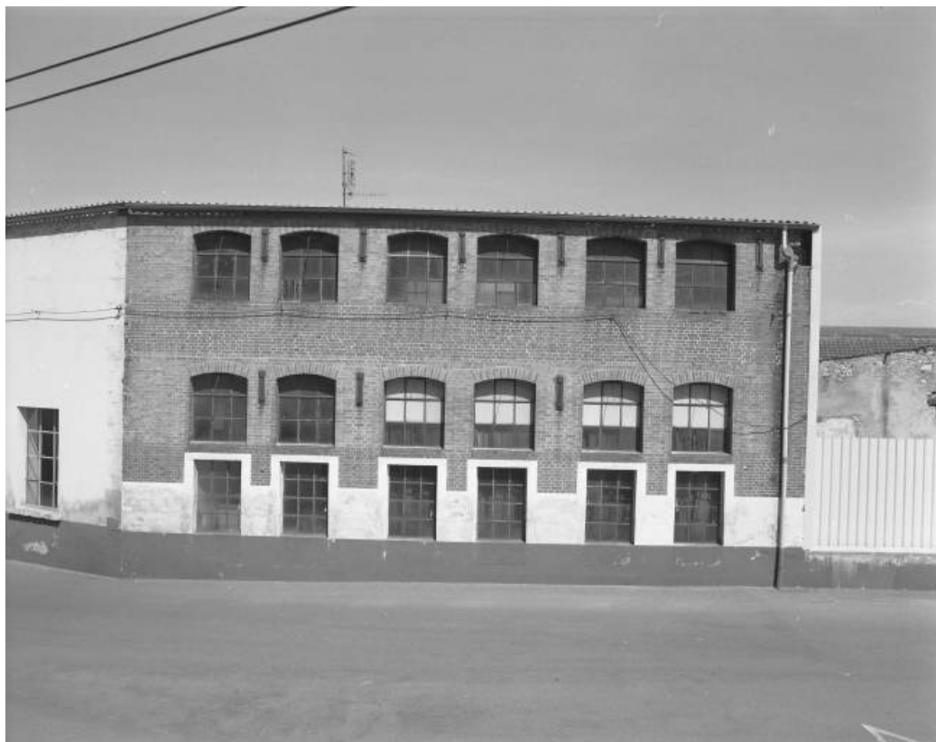
Atelier de contrôle. Vue de face.
