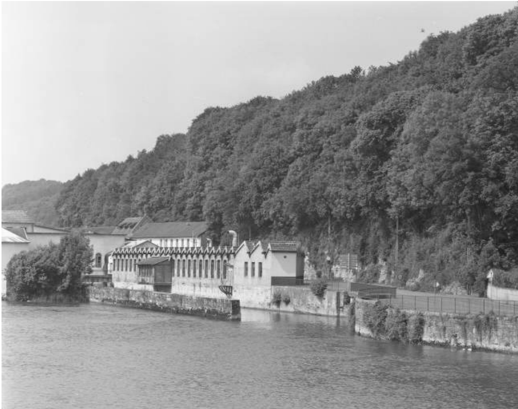
Vue d'ensemble depuis le pont. Vue rapprochée.
