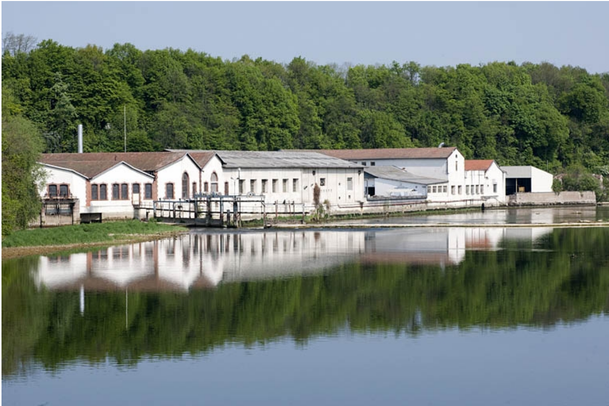
Vue d'ensemble depuis la rive droite en amont.
