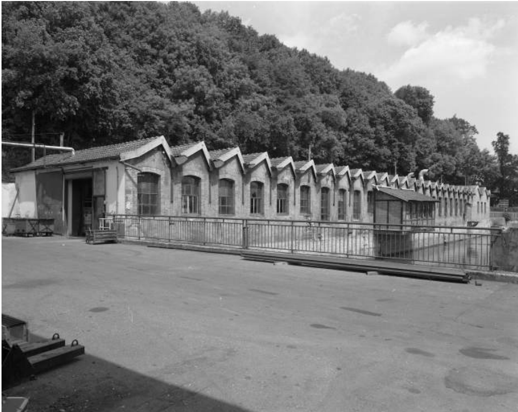
Atelier des fins de séries. Façade est vue de trois quarts gauche.
