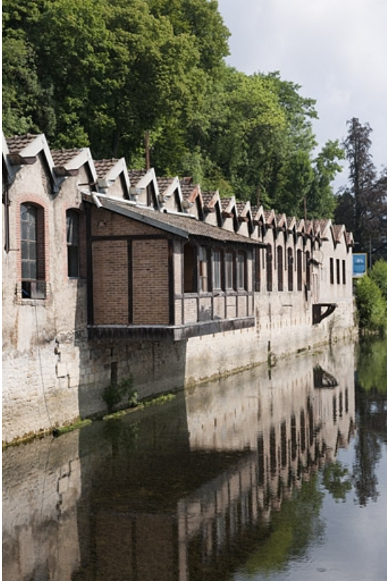
Atelier de fabrication nord. Murs-pignons donnant sur le canal de fuite. 25, Valentigney R.D. 38
