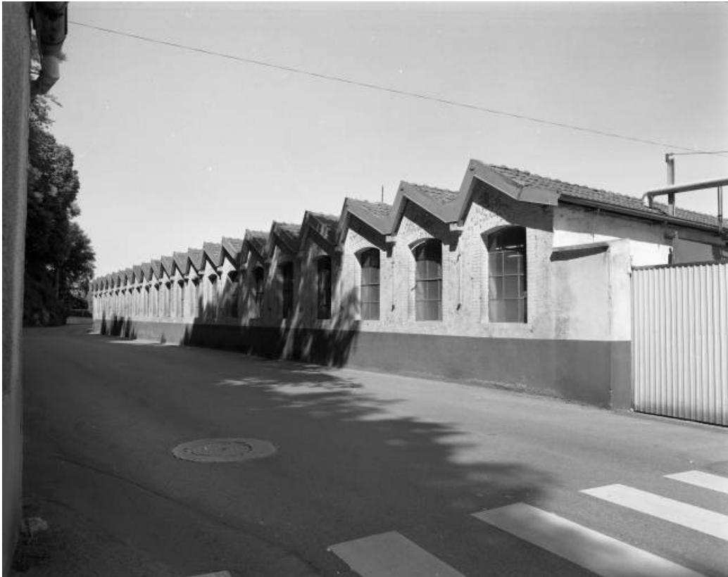
Bâtiment nord. Atelier de fabrication (fins de séries). Façade ouest vue de trois quarts droite. 25, Valentigney R.D. 38
