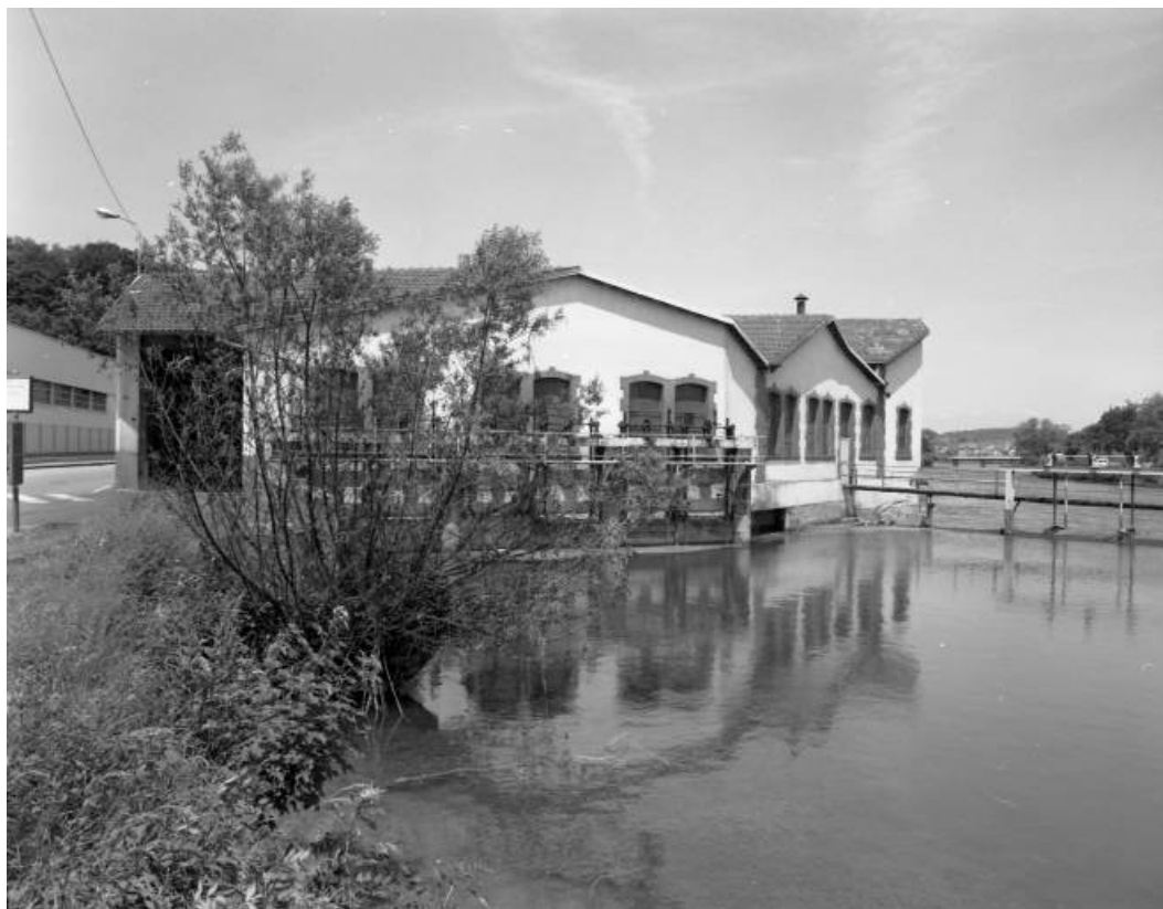
Ancienne fonderie vue du sud. 25, Valentigney R.D. 38
