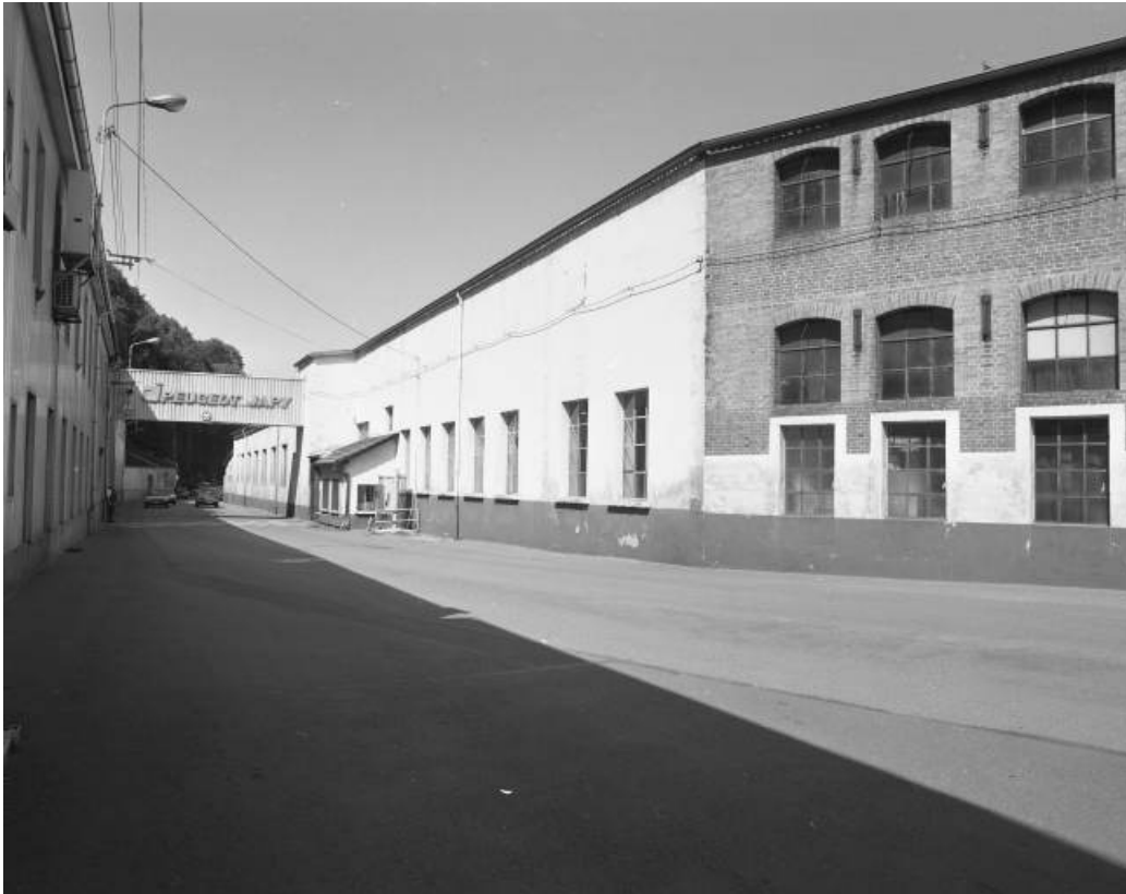
Vue générale depuis le sud. Atelier de contrôle au premier plan.
