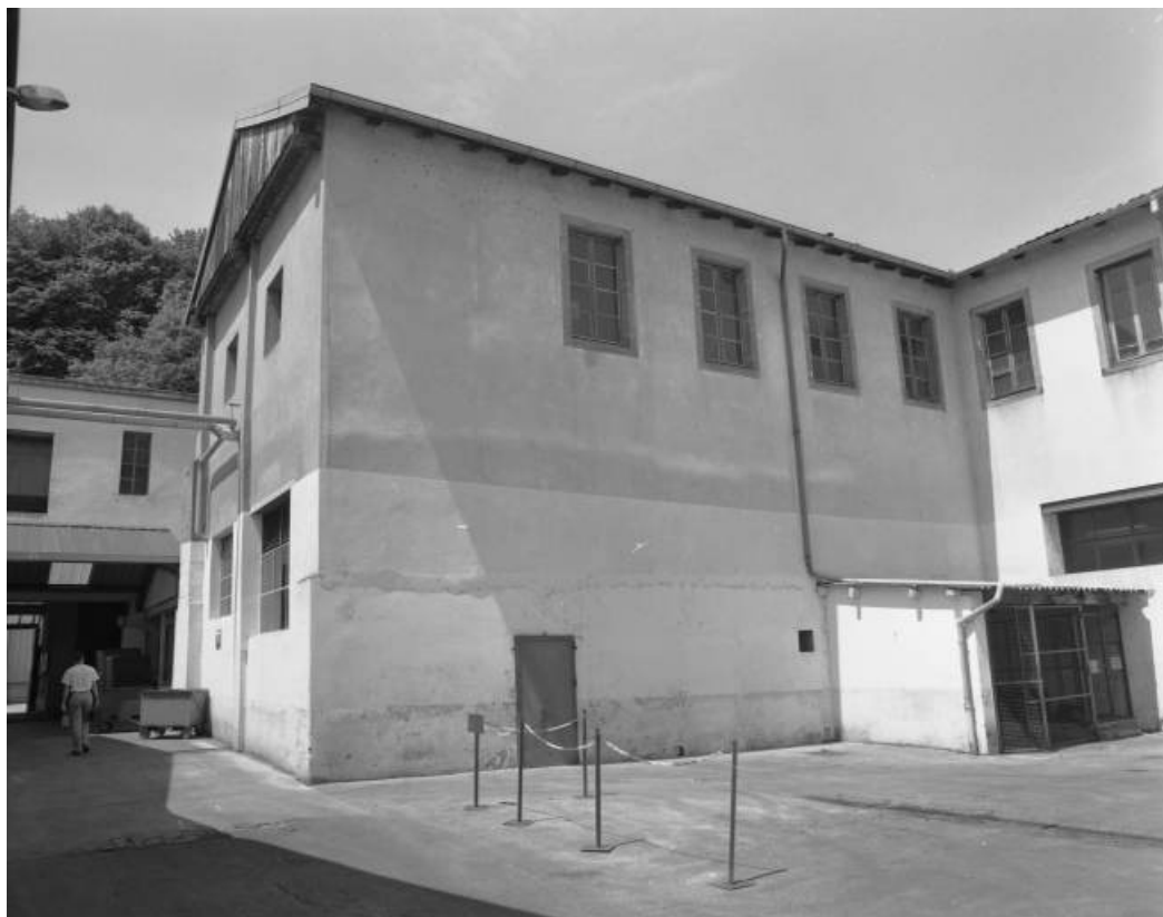
Atelier de fabrication (outillage-entretien mécanique). Vue de trois quarts gauche.
