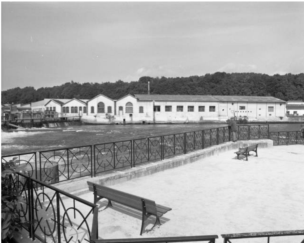
Bâtiments sud depuis la rive droite.
