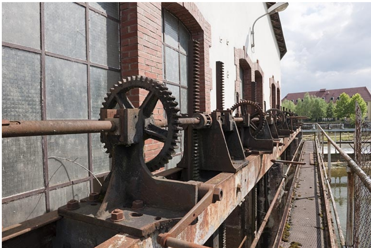
Détail du vannage de prise d'eau.
