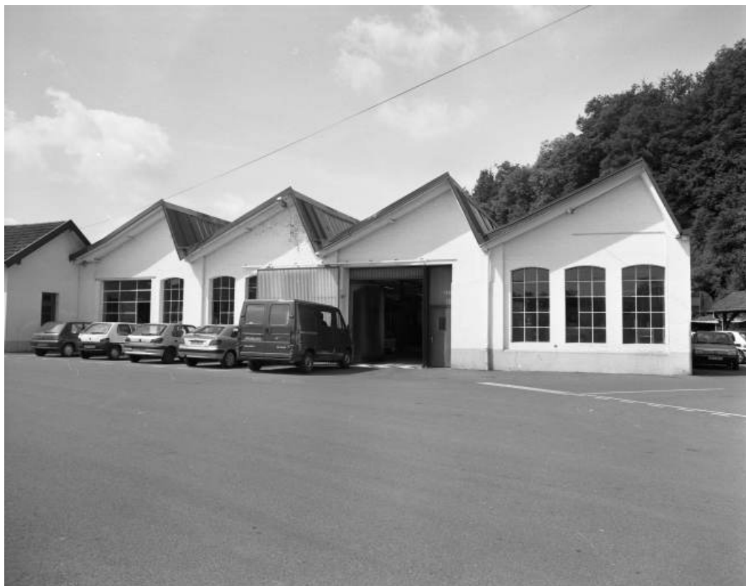
Atelier des culbuteurs. Détail de la façade est.
