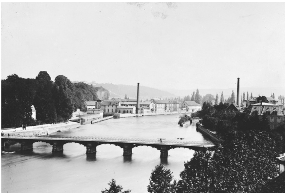
Usine Sous-Roche depuis la rive droite. 25, Valentigney R.D. 38
