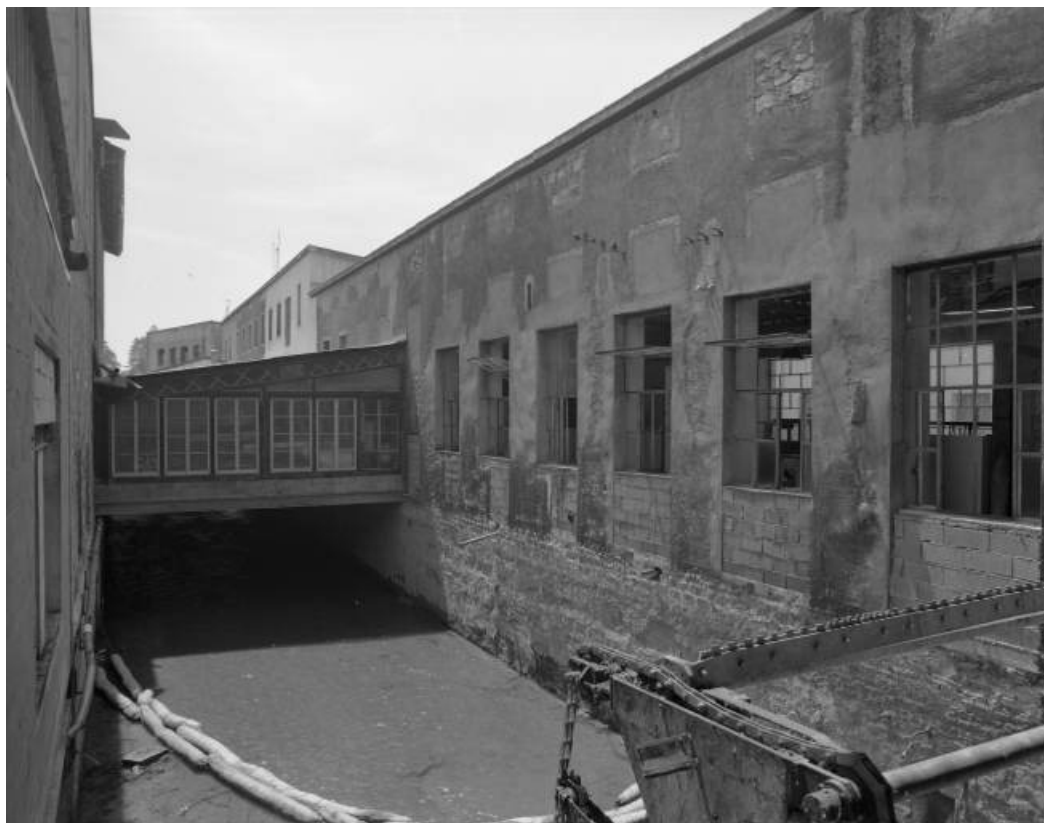
Atelier de fabrication (axes de fourchettes). Façade est.
