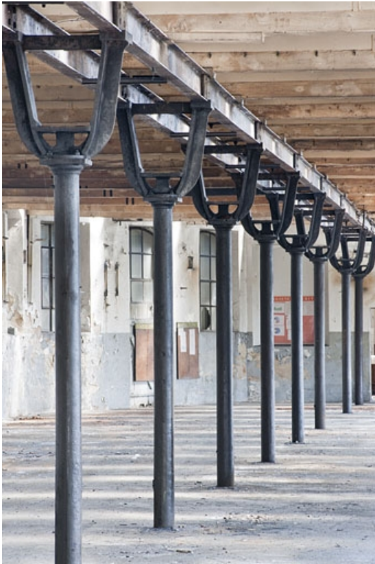
Atelier de fabrication nord. File de colonnes depuis le sud-est. 25, Valentigney R.D. 38
