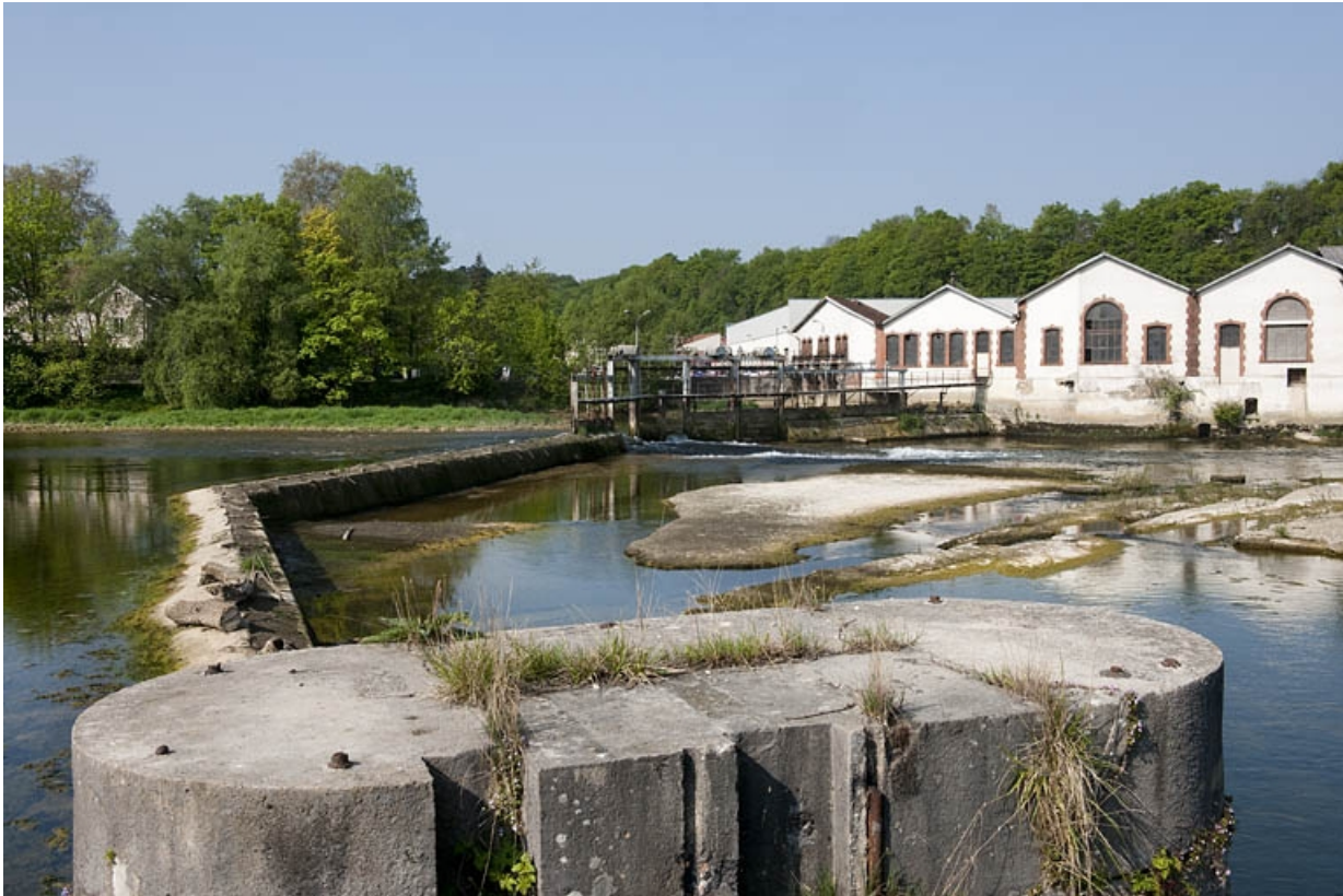
Le barrage depuis la rive droite.
