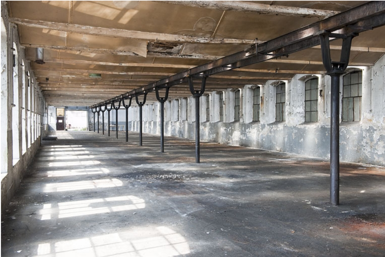
Atelier de fabrication nord. Vue intérieure depuis le nord-est.
