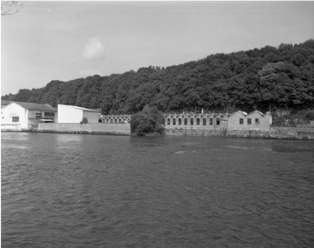
Vue générale depuis la rive droite.
