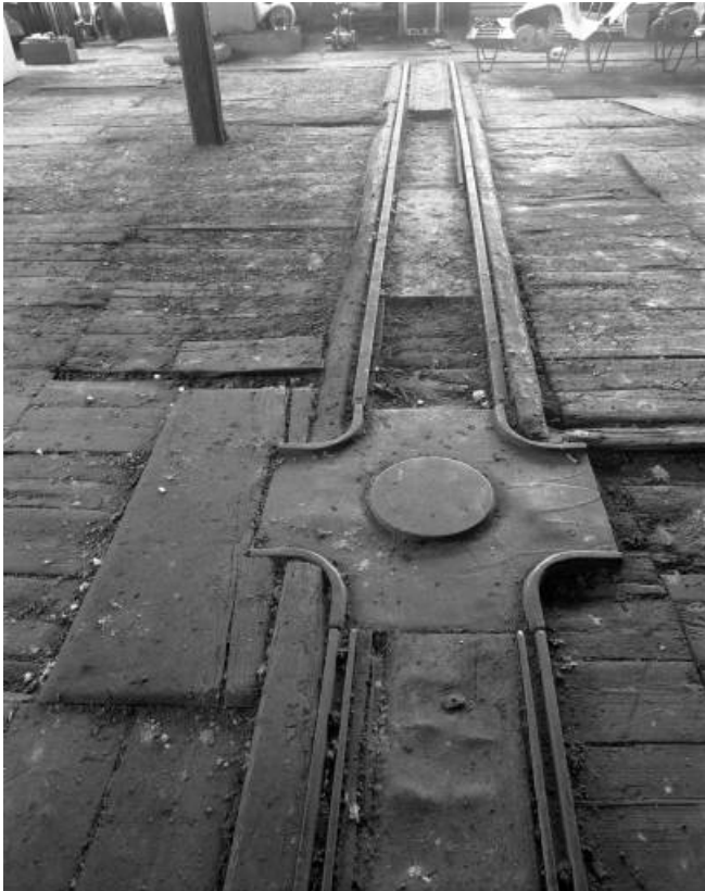
Atelier outillage-entretien mécanique. Premier étage. Rails des wagonnets. 25, Valentigney R.D. 38
