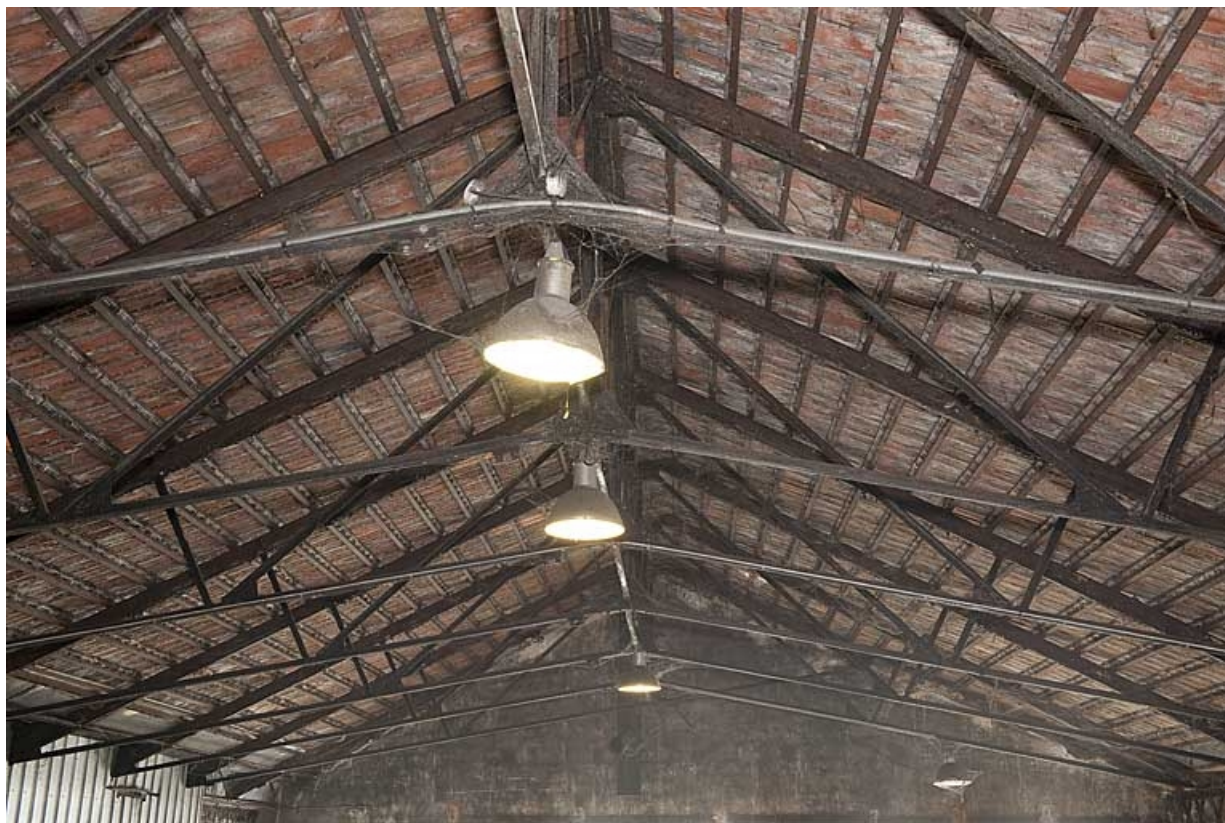
Charpente métallique d'un magasin industriel.
