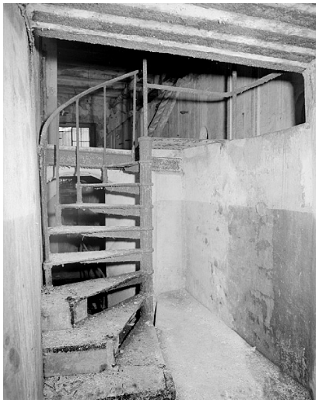
Premier étage, escalier d'accès à la salle des cuves.
