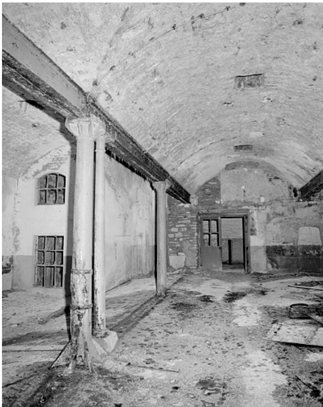
Premier étage, grande salle, côté ouest. 25, Montbéliard, 12 rue des Huisselets
