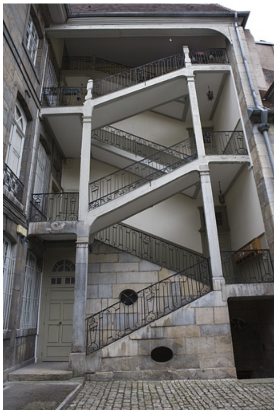
Vue d'ensemble de l'escalier à cage ouverte de face. 25, Besançon, 51 rue Mégevand, lieudit : îlot Granvelle
