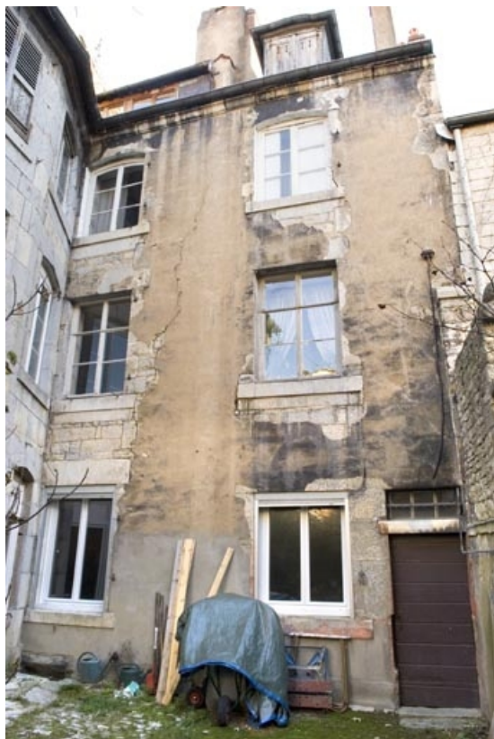
Vue d'ensemble de la façade postérieure du logis secondaire.
