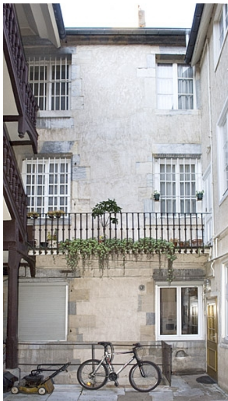
Vue d'ensemble de la façade antérieure du logis secondaire.
