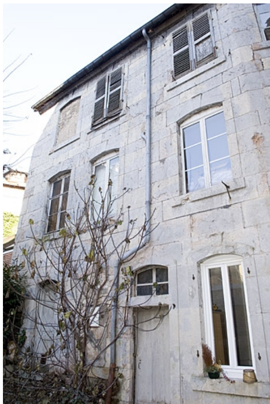
Vue d'ensemble de l'aile du logis secondaire dans la deuxième cour.
