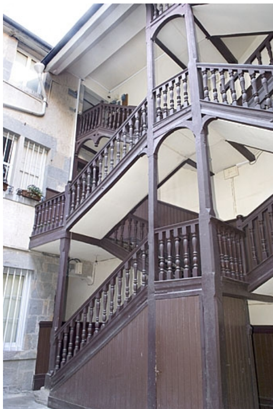
Vue d'ensemble de l'escalier à cage ouverte trois quarts droit.
